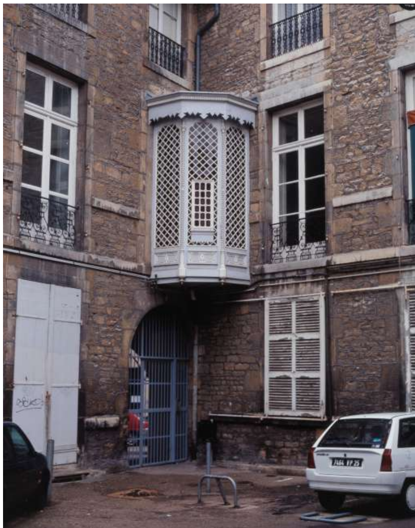
Façade antérieure sur cour : détail de l'angle gauche.
