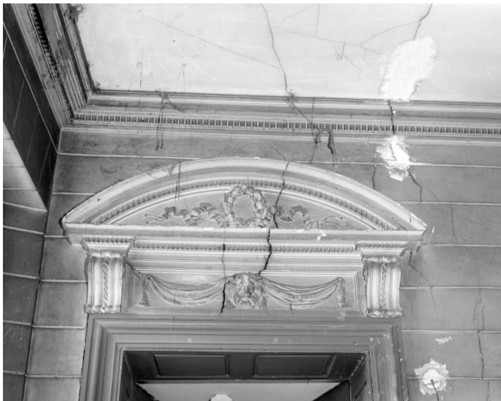
Intérieur : escalier d'honneur, porte droite sur le palier : détail du fronton.
