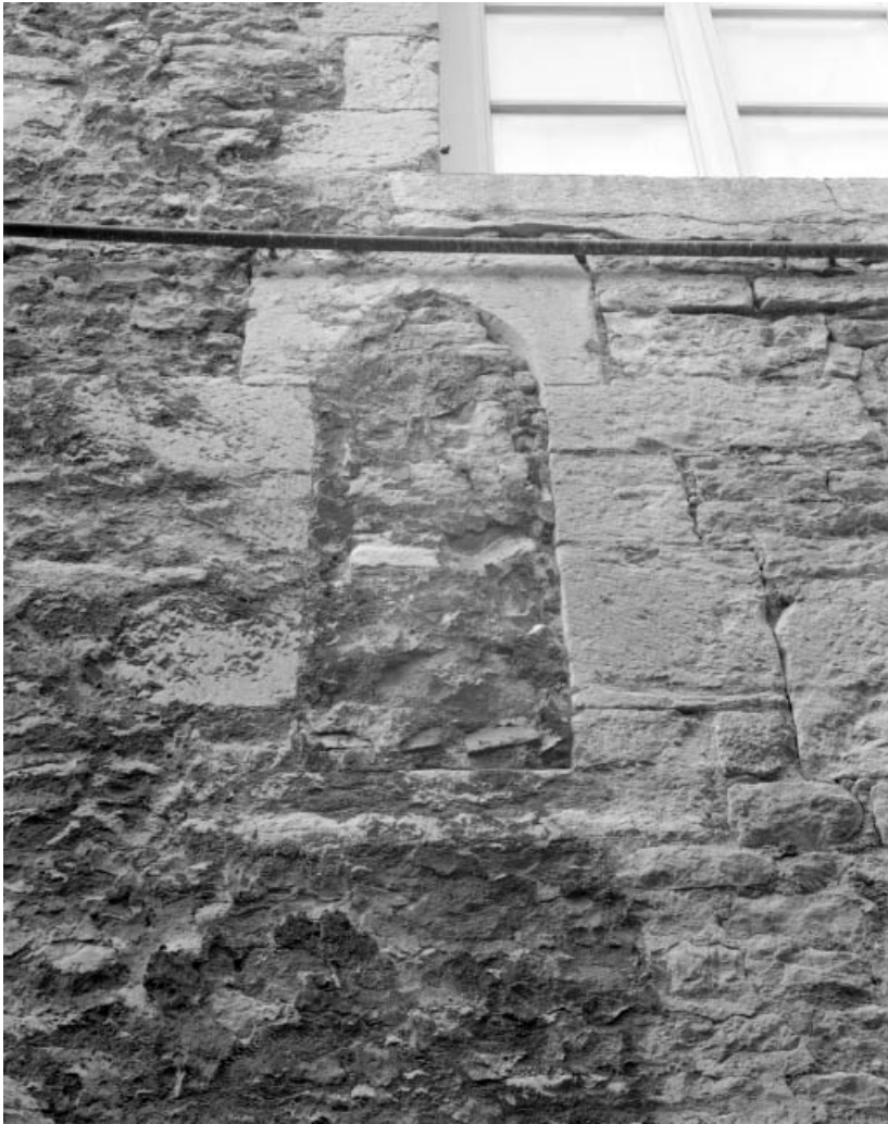
Façade latérale gauche : détail d'une baie murée.
