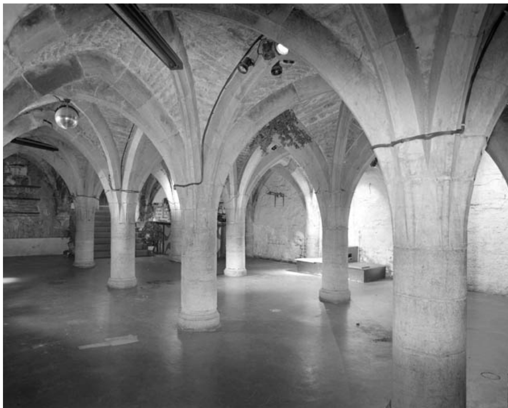
Sous-sol de l'aile droite : vue d'ensemble depuis le fond.
