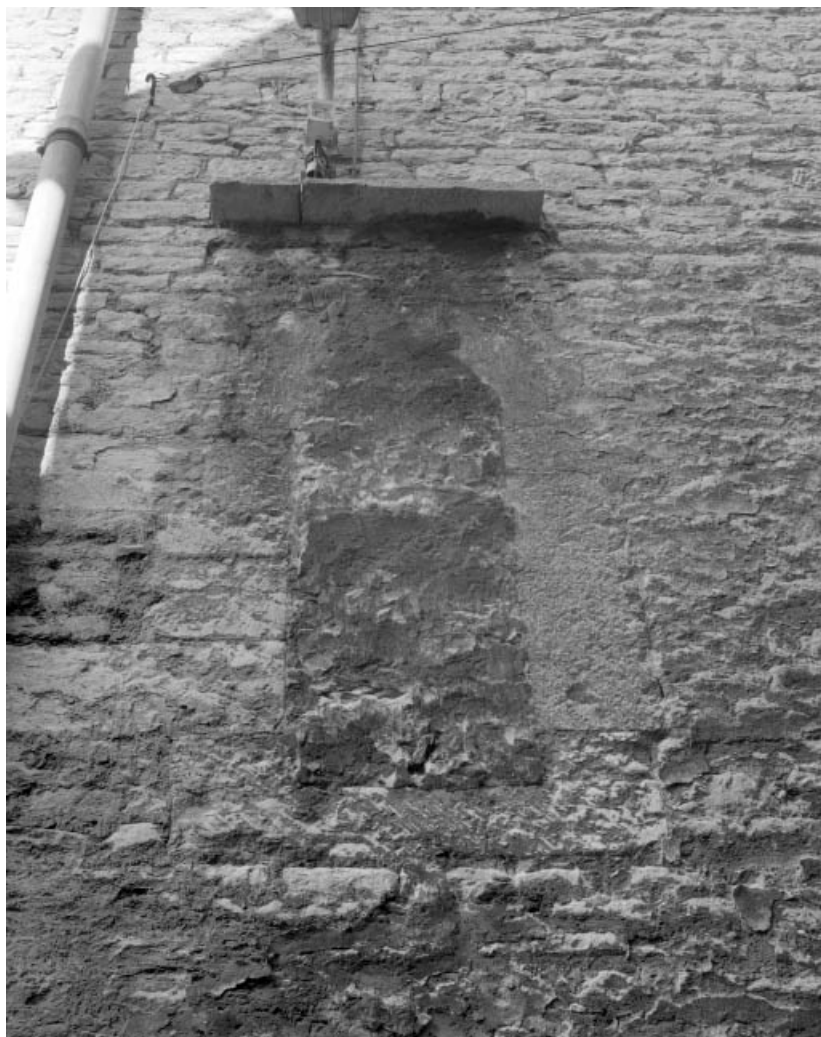
Façade latérale gauche : détail d'une baie murée.
