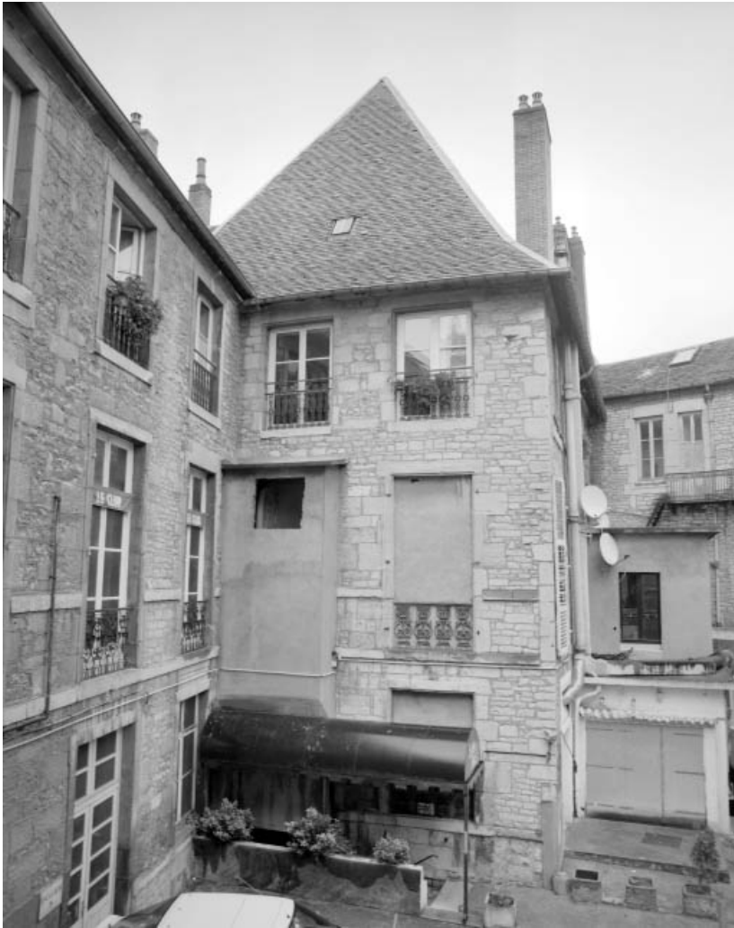
Logis sur cour : détail de l'avant-corps droit. 25, Besançon, 6 rue Pasteur, lieudit : îlot Pasteur
