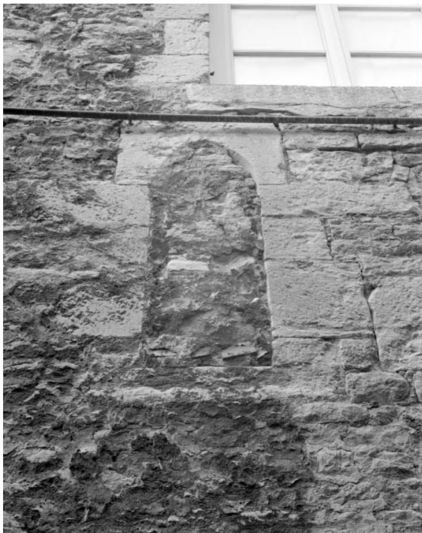
Façade latérale gauche : détail d'une baie murée.
