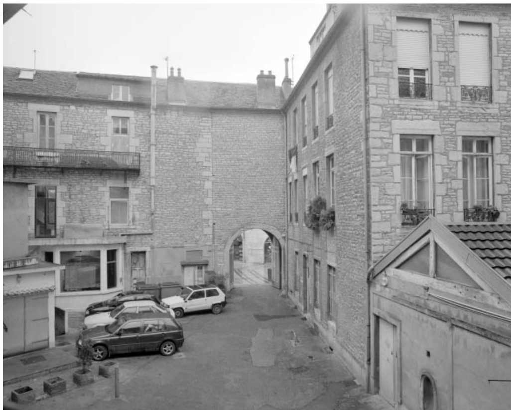
Vue de la cour antérieure depuis le logis sur cour, de trois quarts droit.
