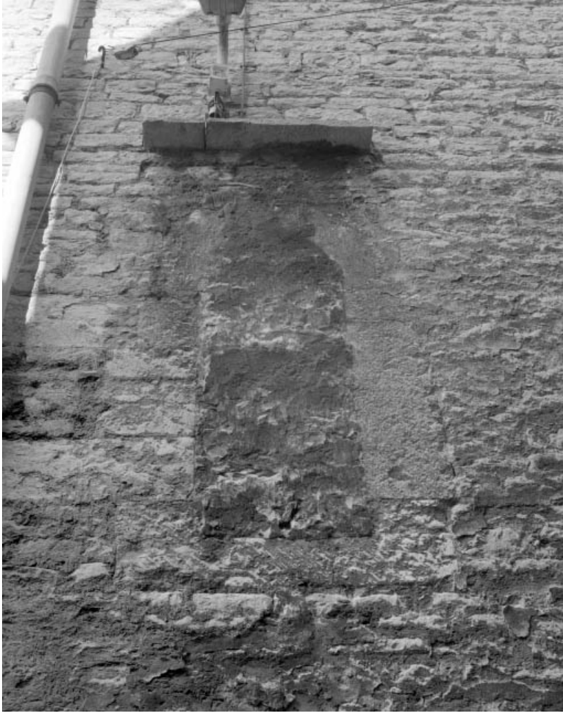
Façade latérale gauche : détail d'une baie murée.
