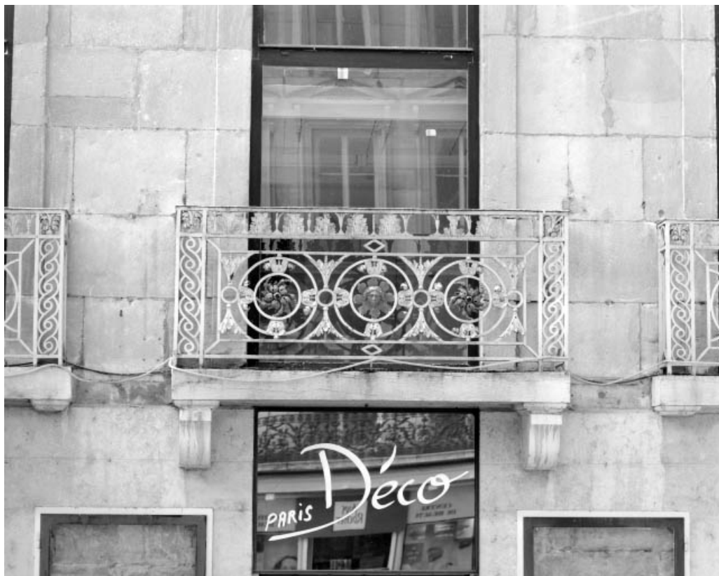
Façade sur rue, détail du balcon de la partie droite.
