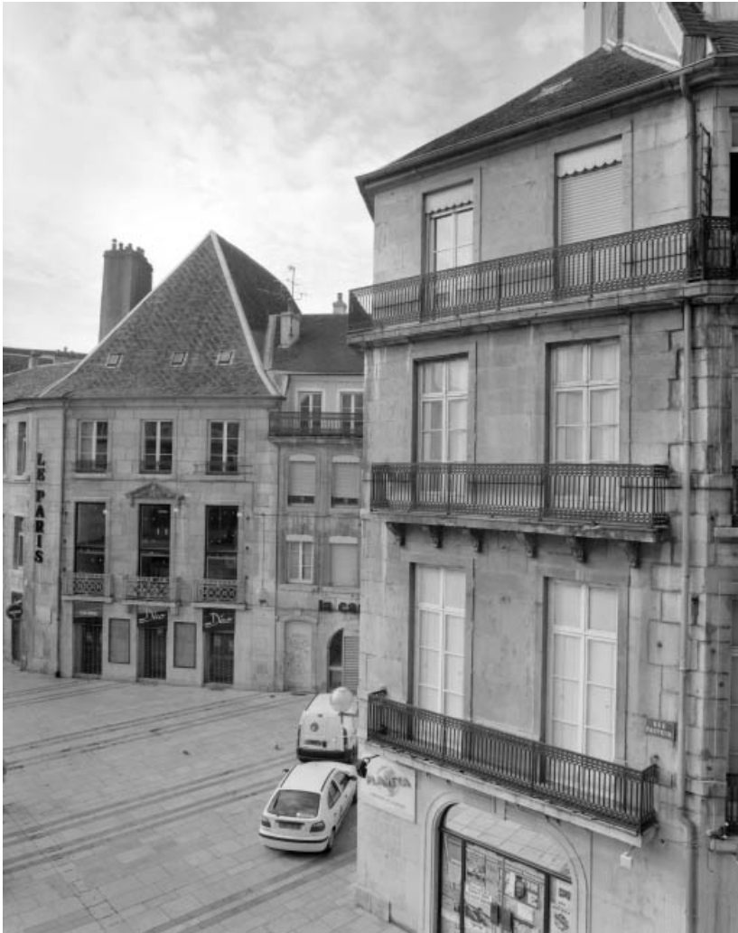
Façade sur rue, détail de la partie droite. 25, Besançon, 6 rue Pasteur, lieudit : îlot Pasteur
