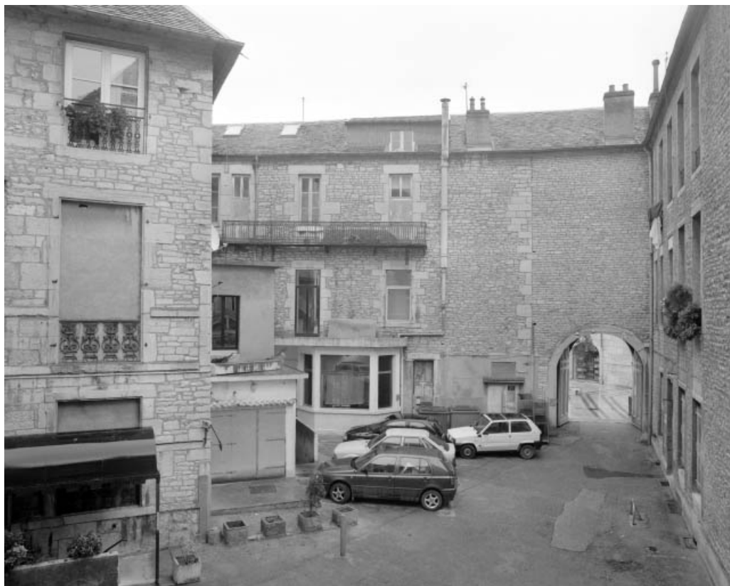
Vue de la cour antérieure depuis le logis sur cour, de trois-quart gauche.
