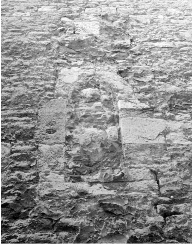
Détail d'une baie sur la façade latérale gauche.
