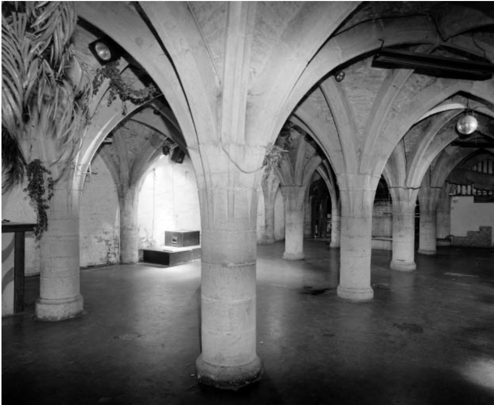
Sous-sol de l'aile droite : vue d'ensemble depuis l'entrée, de trois-quart gauche.
