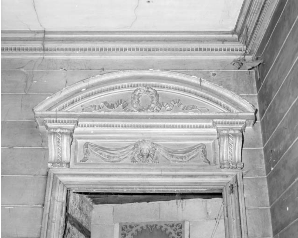
Intérieur : escalier d'honneur, porte gauche sur le palier, détail du fronton. 25, Besançon, 6 rue Pasteur, lieudit : îlot Pasteur
