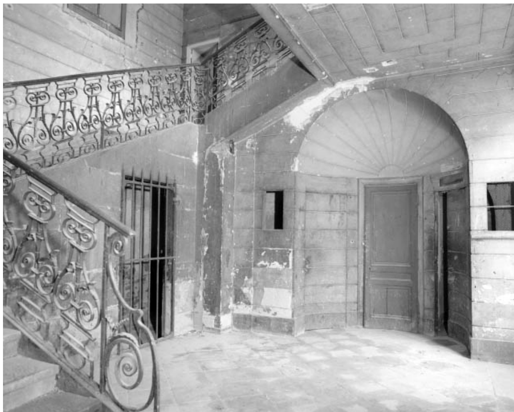
Intérieur : escalier d'honneur, vue d'ensemble en largeur.
