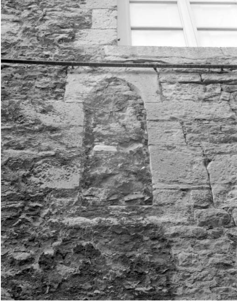
Façade latérale gauche : détail d'une baie murée.
