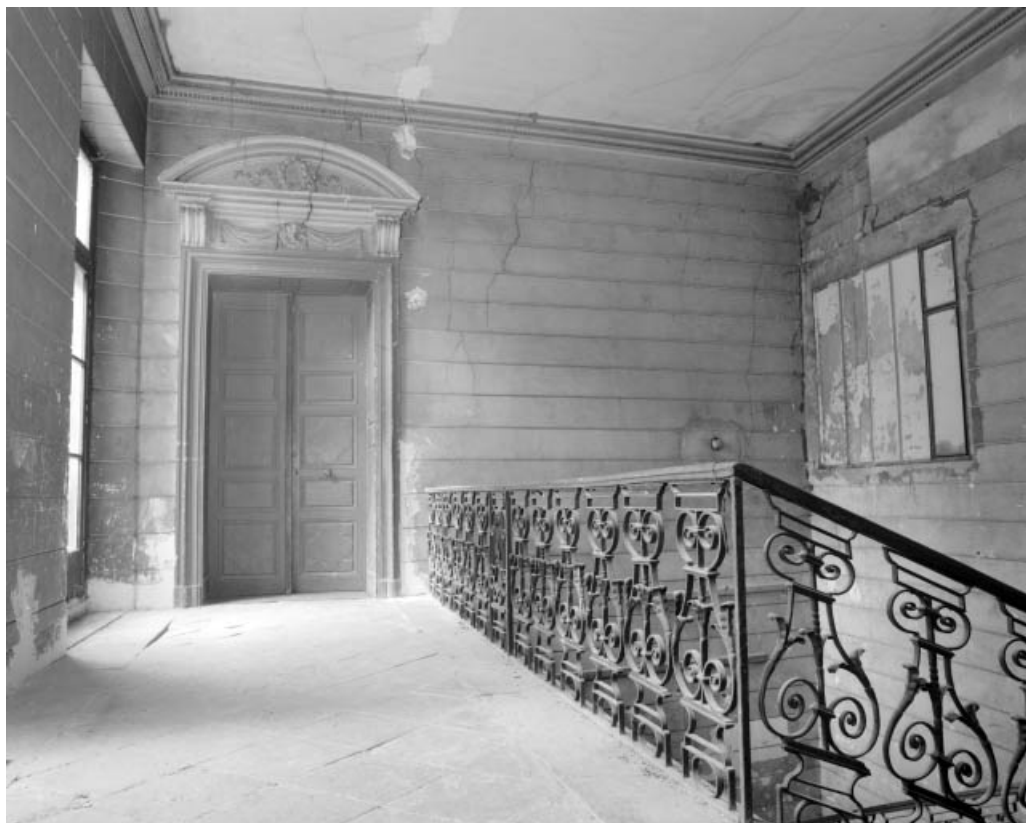
Intérieur : escalier d'honneur, vue d'ensemble du palier.
