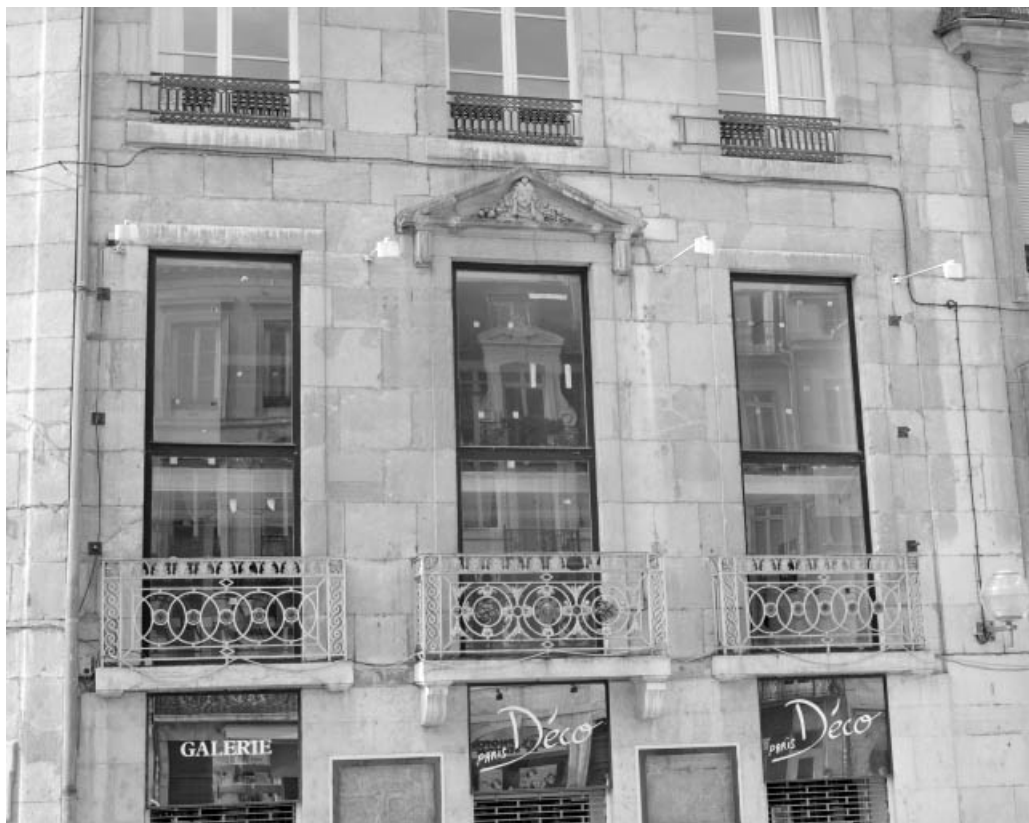
Façade sur rue, détail du premier étage de la partie droite.
