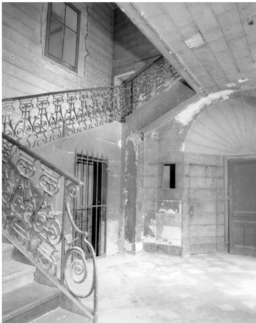
Intérieur : escalier d'honneur, vue d'ensemble en hauteur.
