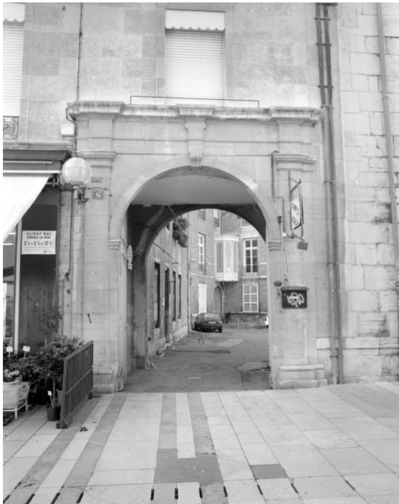
Façade sur rue : détail de l'entrée cochère.
