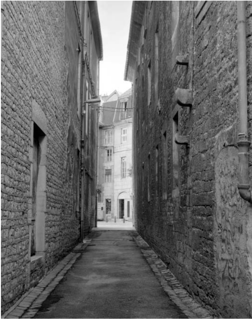
Façade latérale gauche : vue rapprochée.
