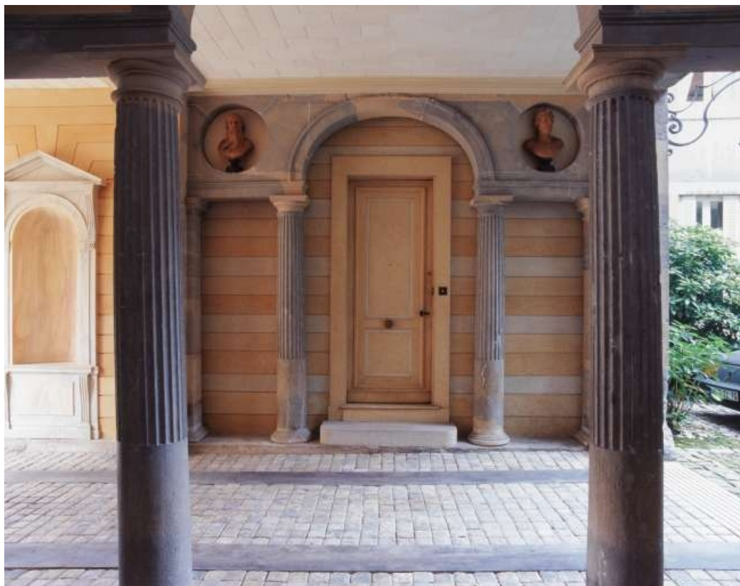
Passage d'entrée : détail de la partie gauche depuis le vestibule droit, de face. 25, Besançon, 3 rue du Lycée, lieudit : îlot Pasteur
