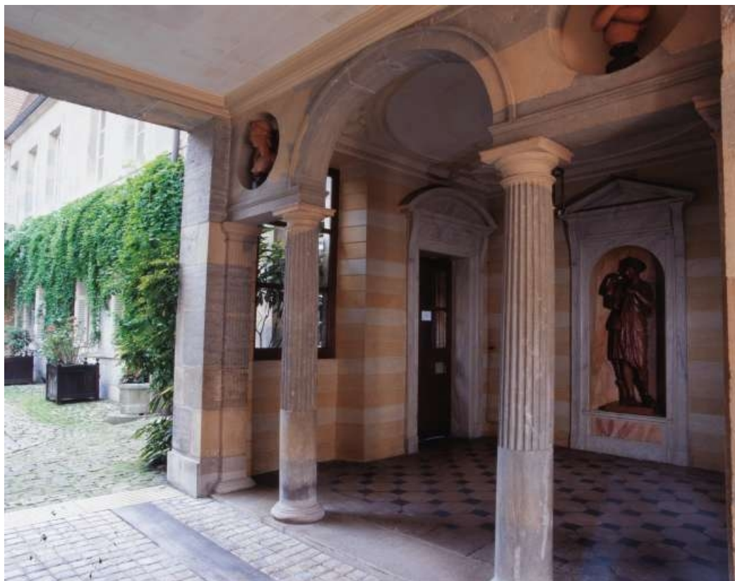
Passage d'entrée : détail de la partie droite.
