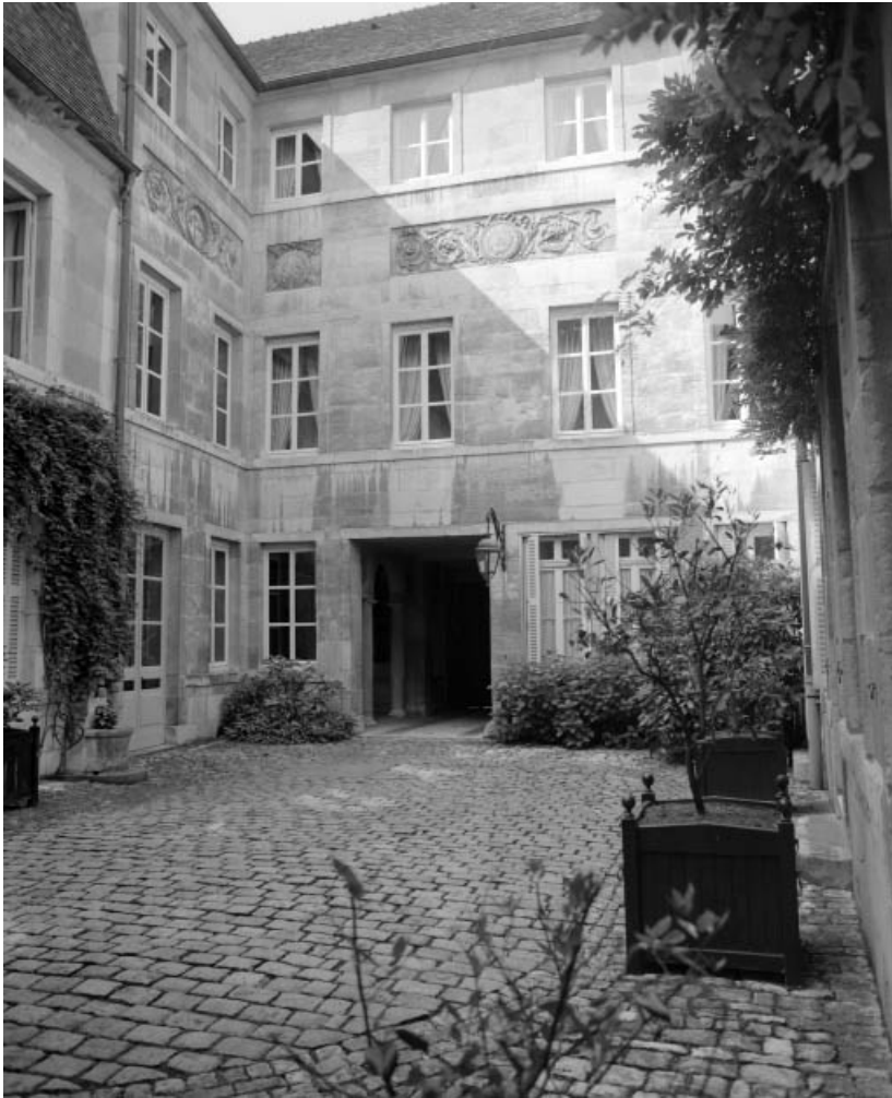
Vue d'ensemble la façade postérieure du logis principal.
