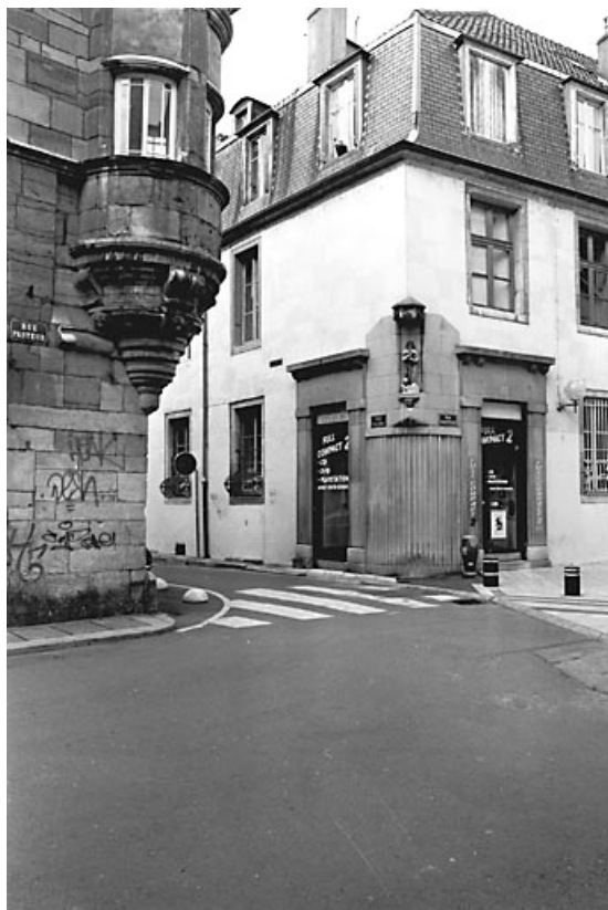
Vue éloignée de l'angle gauche de l'édifice, entre rue Pasteur et rue Emile Zola. 25, Besançon, 10 rue Pasteur, lieudit : îlot Pasteur
