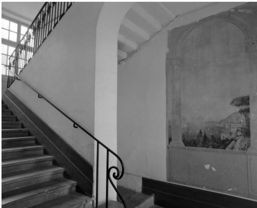
Vue d'ensemble de l'escalier : de trois quarts gauche.
