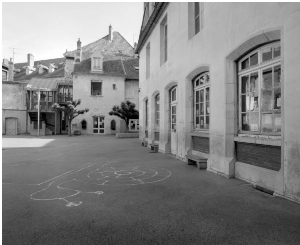
Vue d'ensemble éloignée de la partie gauche du bâtiment à droite de la deuxième cour. 25, Besançon, 8 rue Pasteur, lieu-dit : îlot Pasteur
