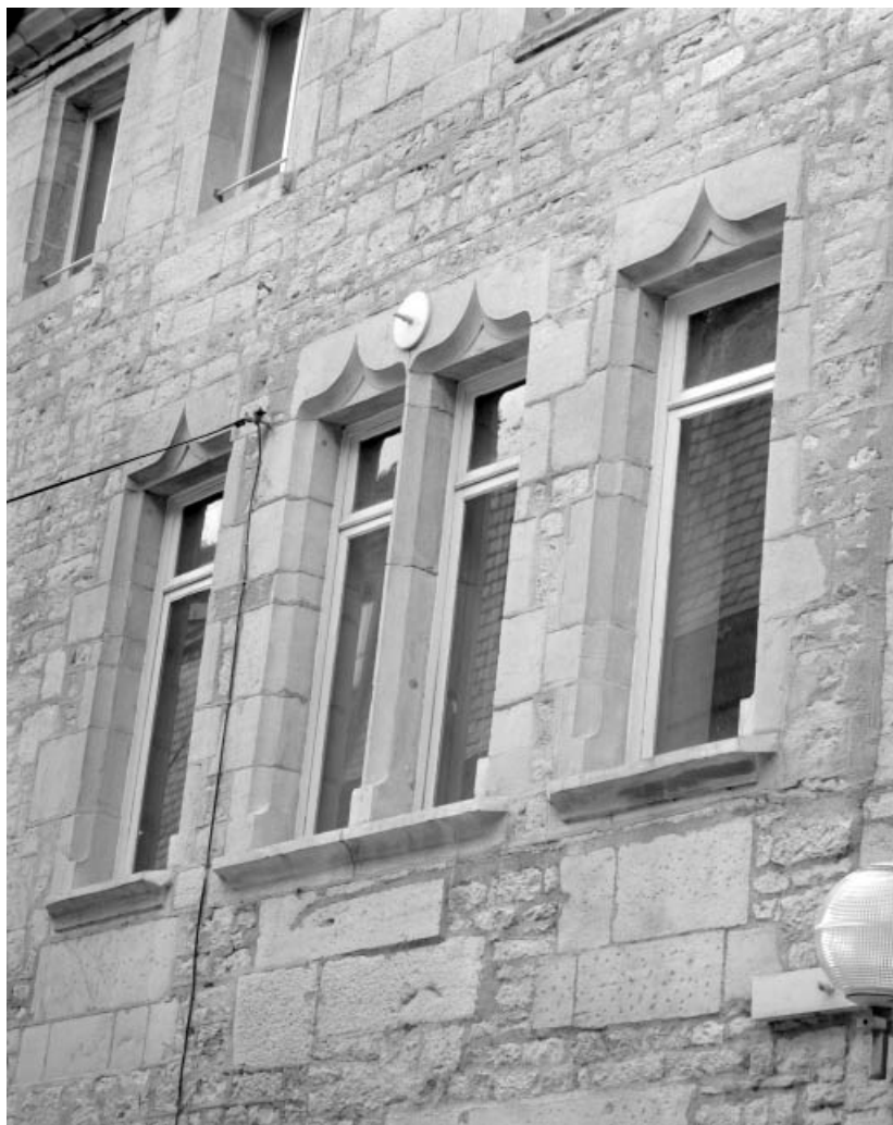
Façade sur rue, détail des baies du premier étage, vue rapprochée.
