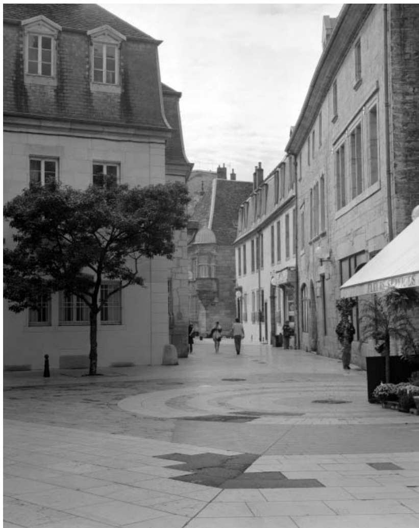
Façade sur rue de trois quarts droit, vue éloignée.
