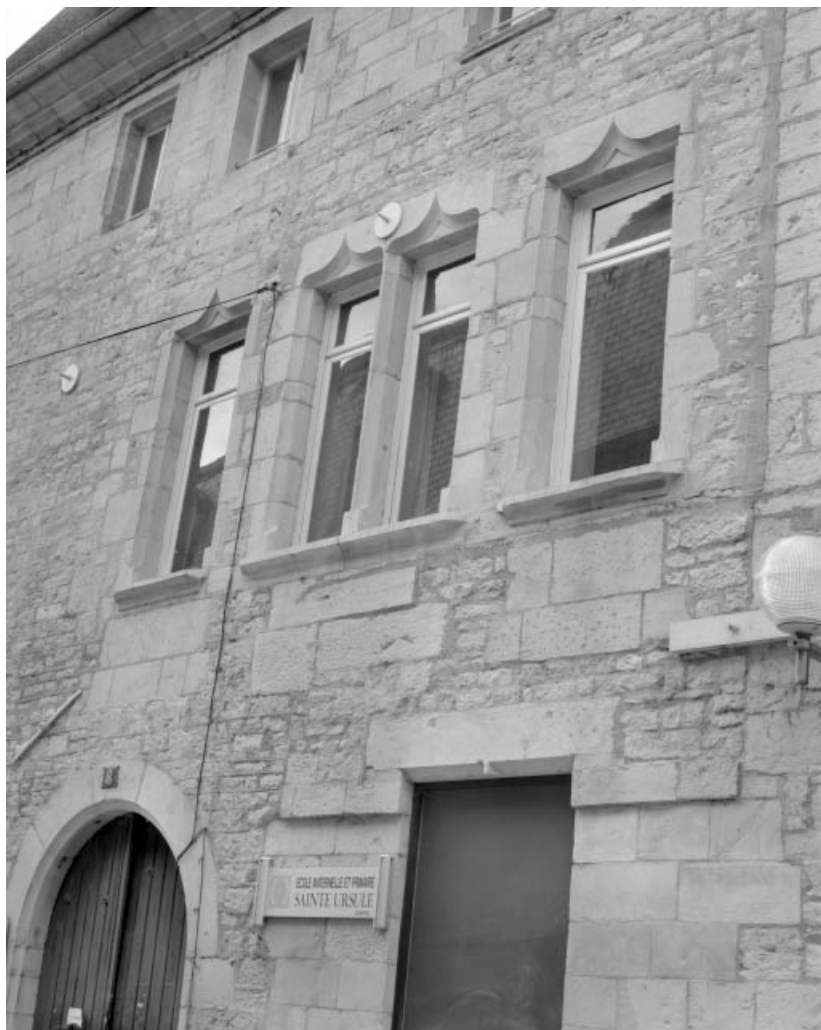
Façade sur rue, détail des baies du premier étage.
