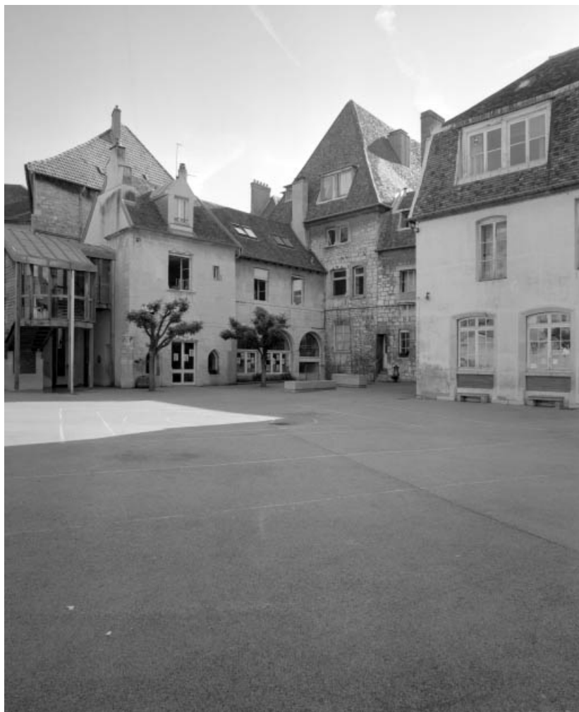
Vue d'ensemble des bâtiments dans la deuxième cour : vue éloignée.
