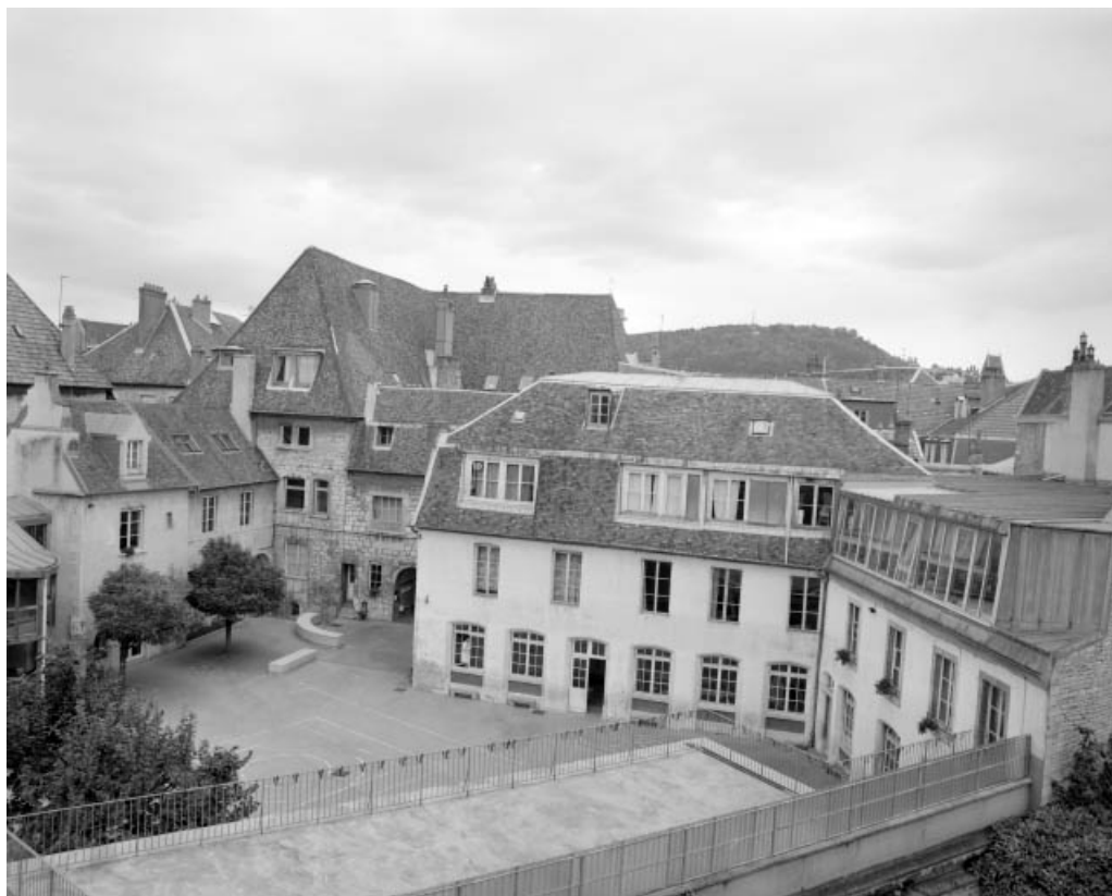
Vue d'ensemble des bâtiments situés dans la deuxième cour.
