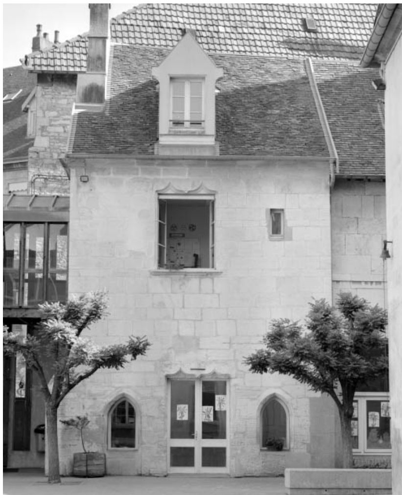
Bâtiment à droite de la deuxième cour, partie gauche : de face.
