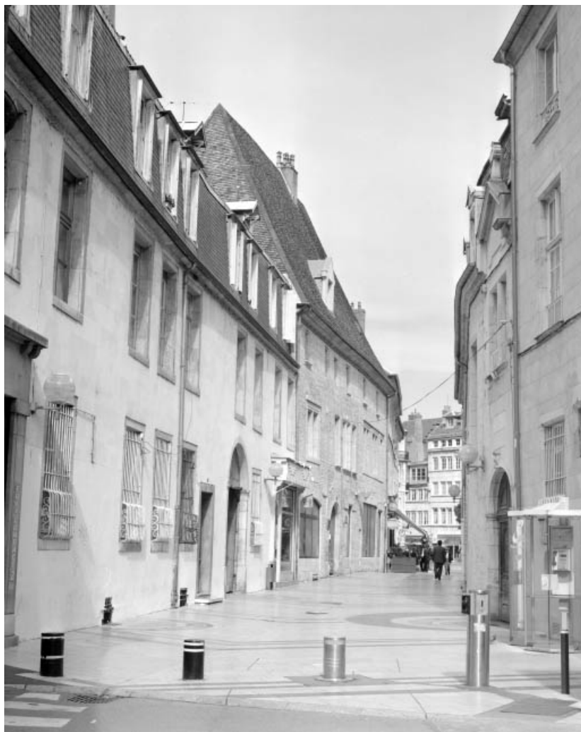
Façade sur rue de trois quarts gauche, vue éloignée.
