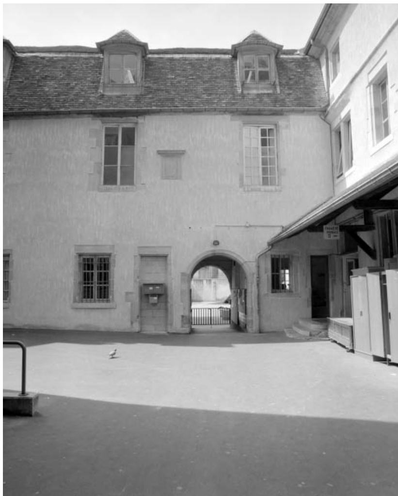
Vue d'ensemble de la façade antérieure du logis secondaire entre première et deuxième cour. 25, Besançon, 8 rue Pasteur, lieudit : îlot Pasteur
