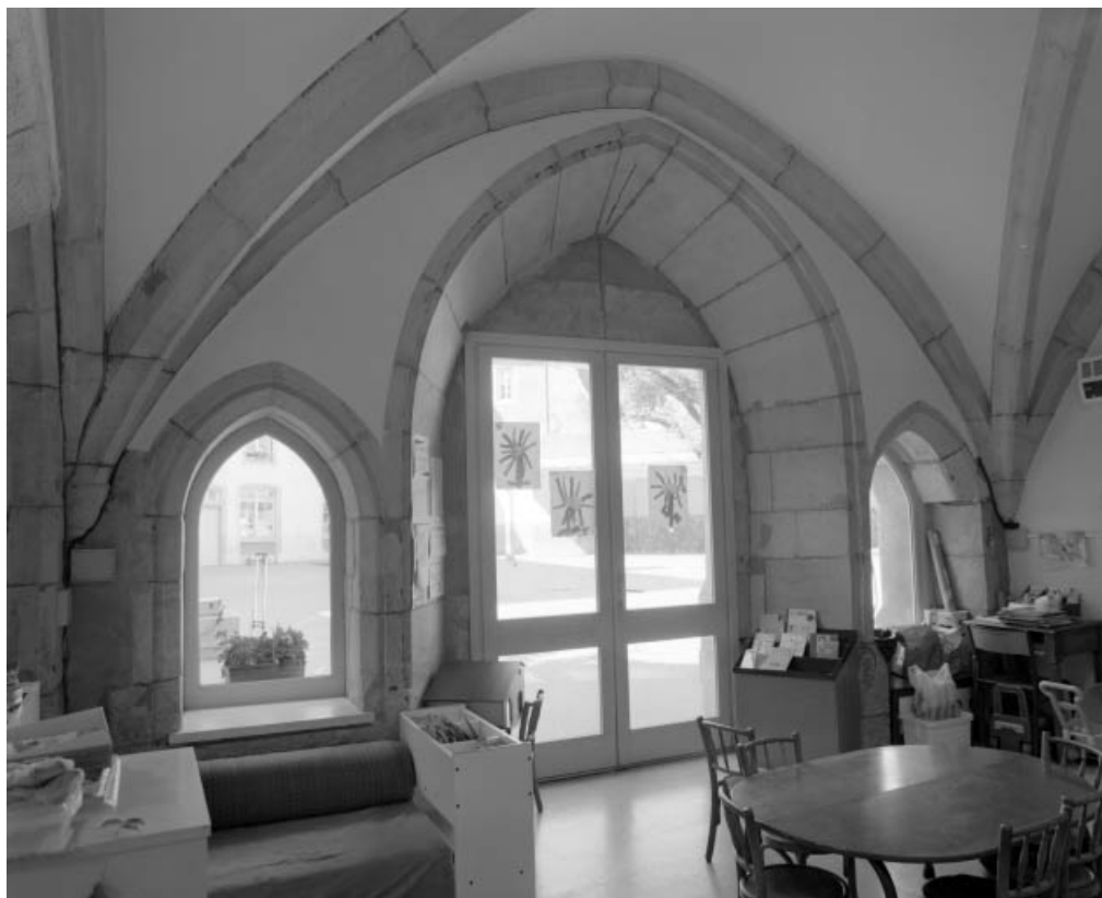
Intérieur : partie gauche du bâtiment à droite de la deuxième cour : vue des trois baies en arc brisé. 25, Besançon, 8 rue Pasteur, lieu-dit : îlot Pasteur
