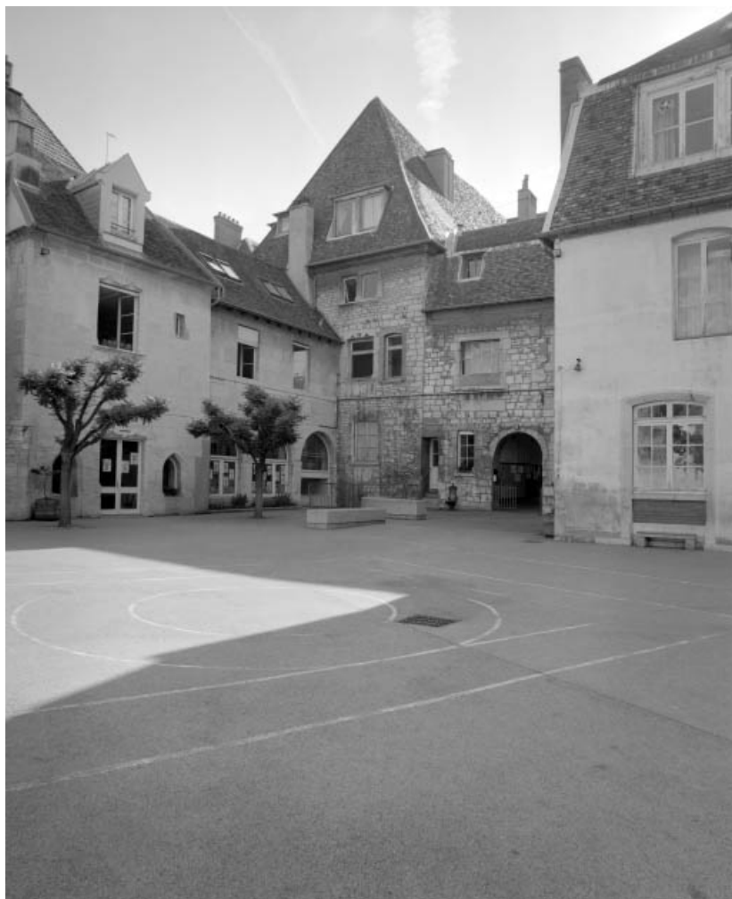
Vue d'ensemble des bâtiments dans la deuxième cour : vue rapprochée.
