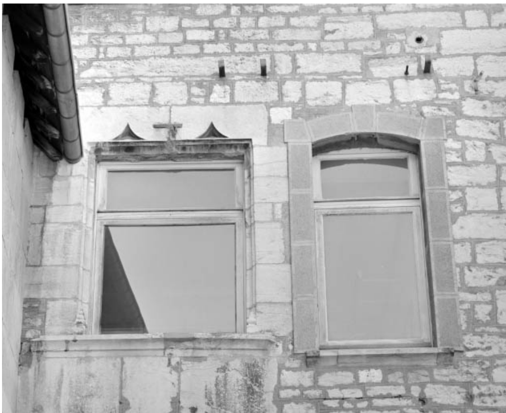
Logis principal : détail d'une baie de l'aile sur la deuxième cour.
