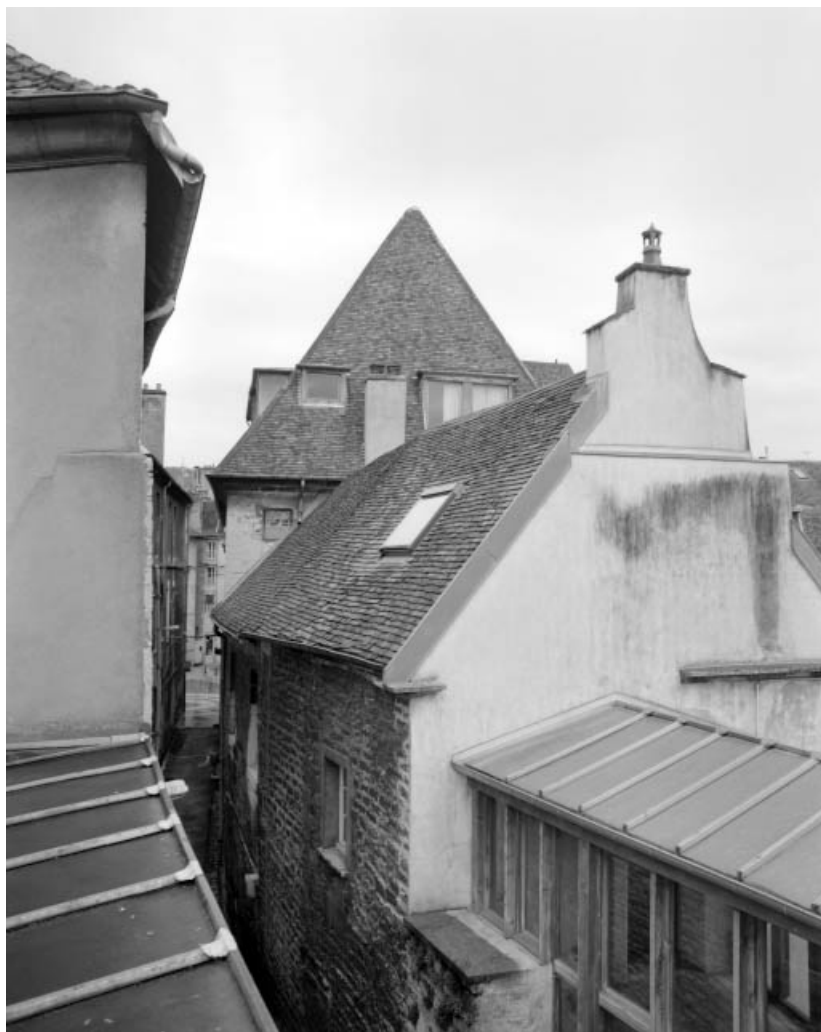
Détail des toitures des corps de bâtiments droits, depuis la rue du Loup.
