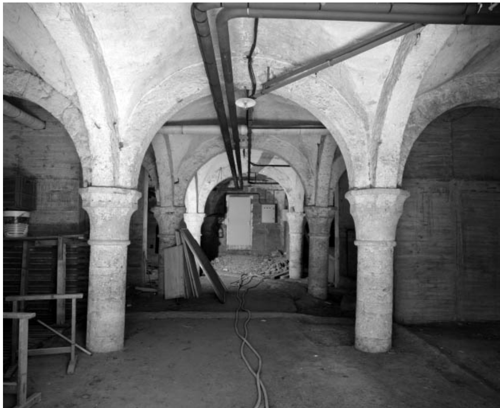
Sous-sol de la partie droite du corps de logis principal : vue de face.
