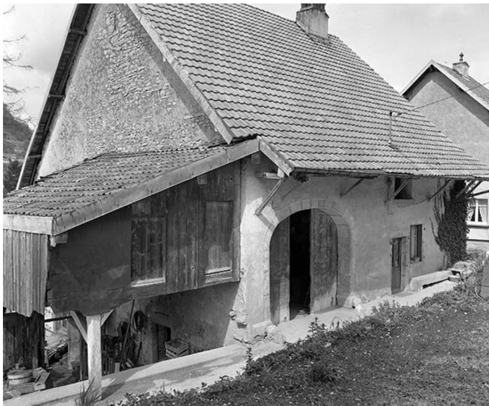
Façade antérieure et façade latérale gauche, vue rapprochée.
