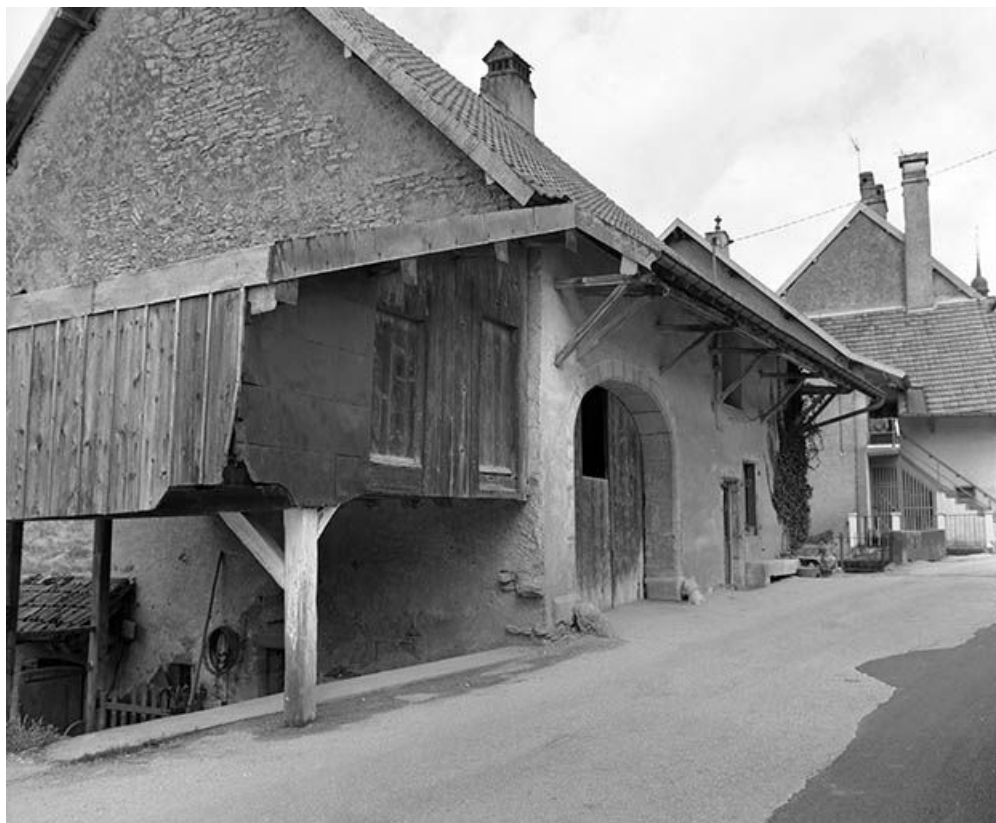
Façade antérieure et face latérale gauche. 25, Ornans, 24 rue du Champliman
