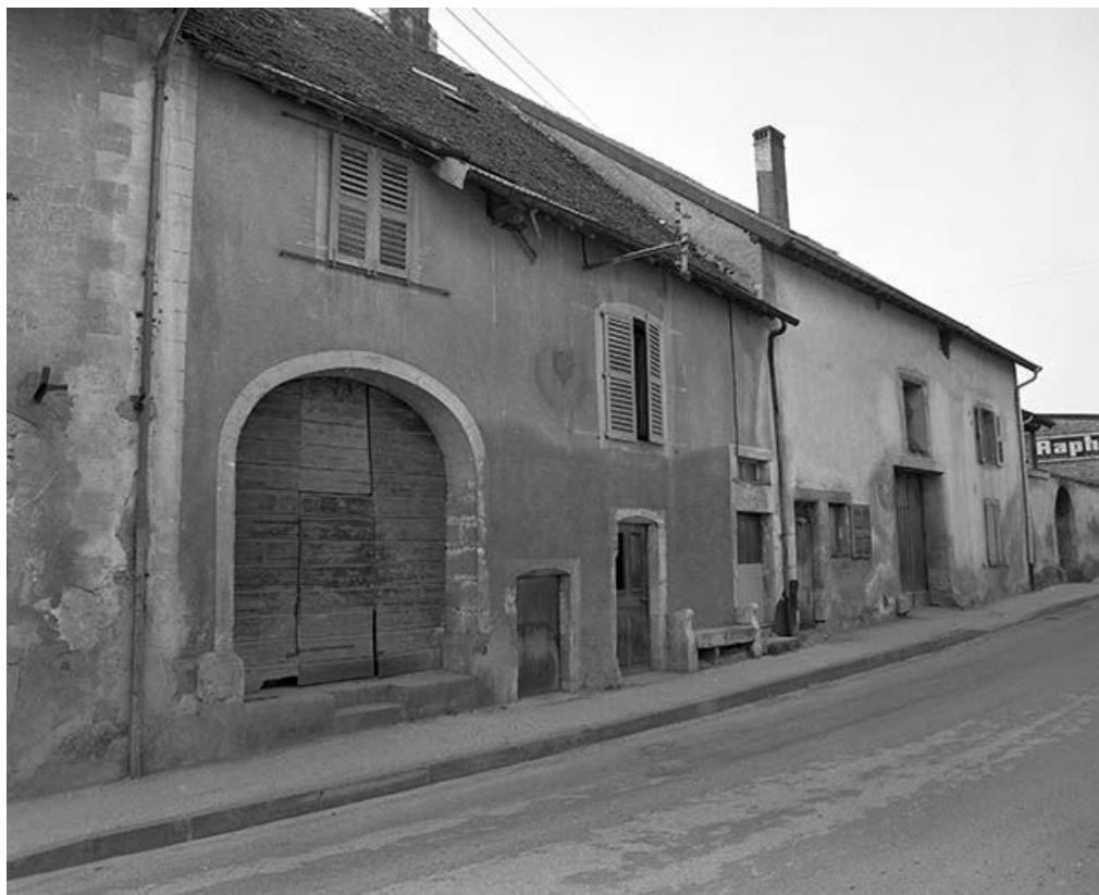
Façade antérieure de trois quarts gauche. 25, Ornans, 19 rue Edouard Bastide
