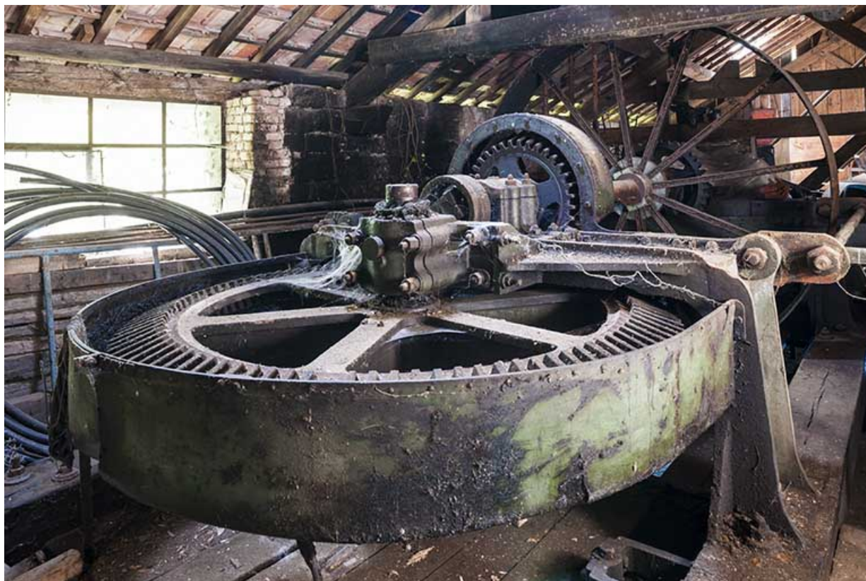
Bâtiment d'eau. Vestiges de la transmission de la centrale hydroélectrique.
