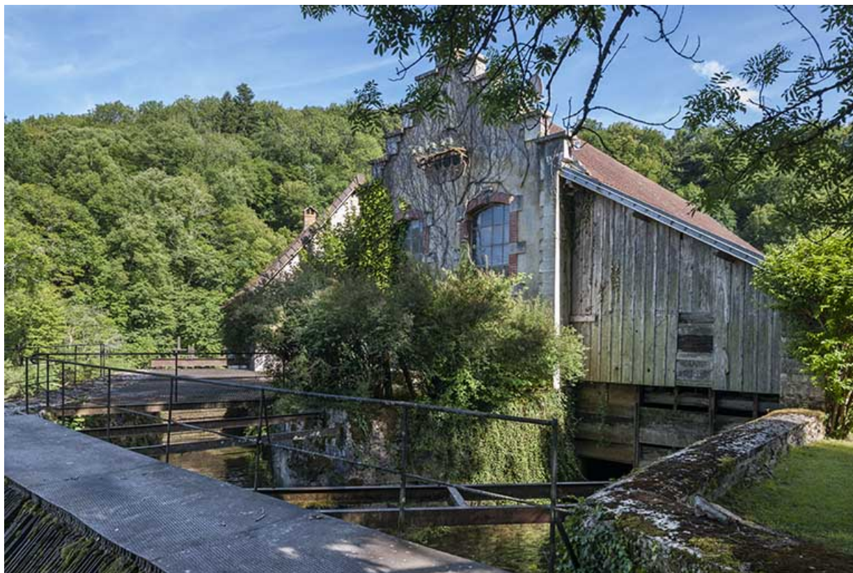
Prise d'eau, centrale hydroélectrique et bâtiment d'eau.
