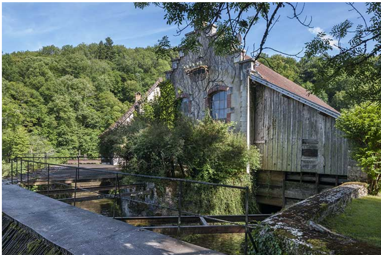
Prise d'eau, centrale hydroélectrique et bâtiment d'eau.
