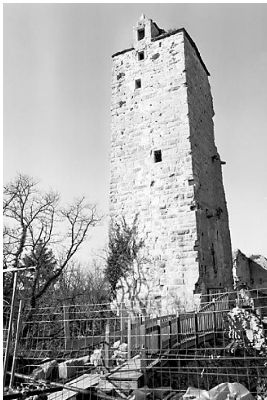
Angle nord-est de la tour Saint-Denis.
