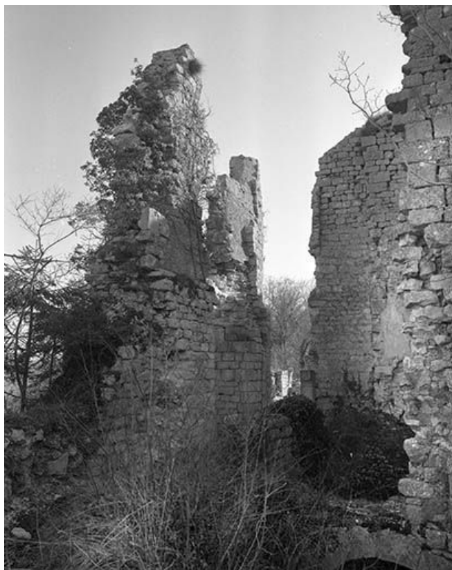
Vue du logis à l'extrémité ouest de l'éperon.
