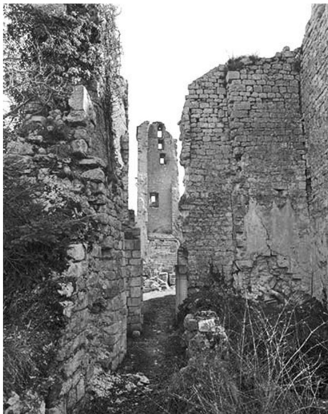
Logis et élévation ouest de la tour Saint-Denis.
