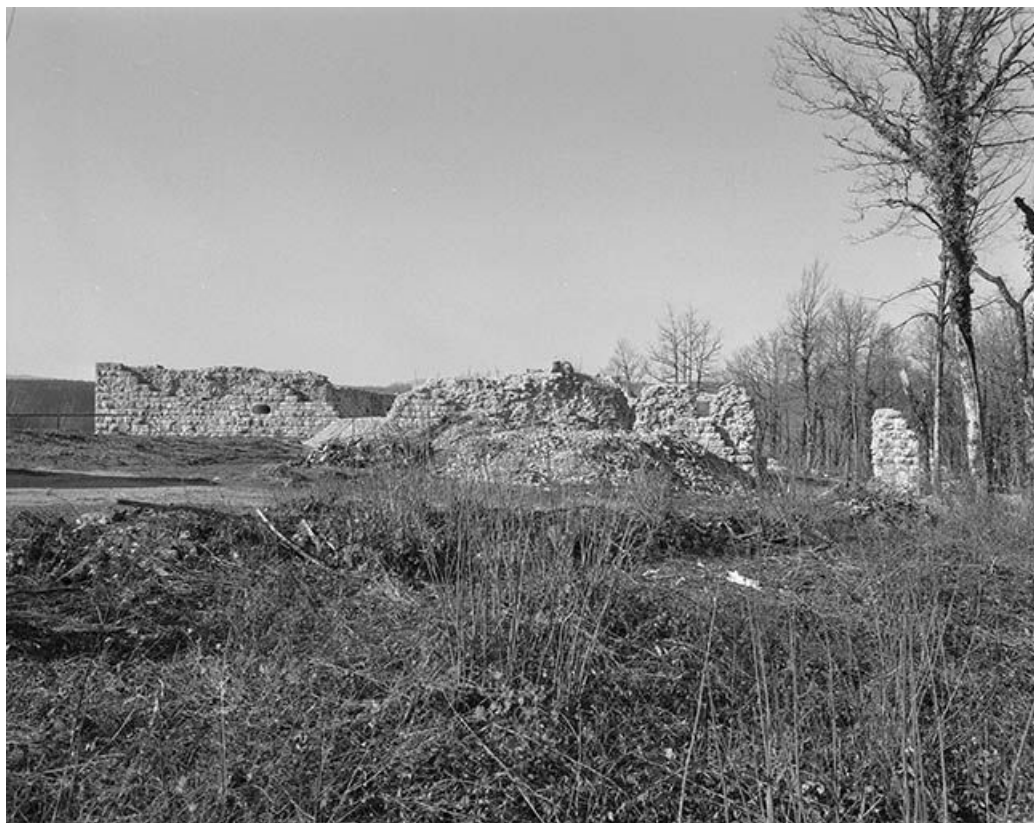
Vue générale du mur d'enceinte depuis l'est.
