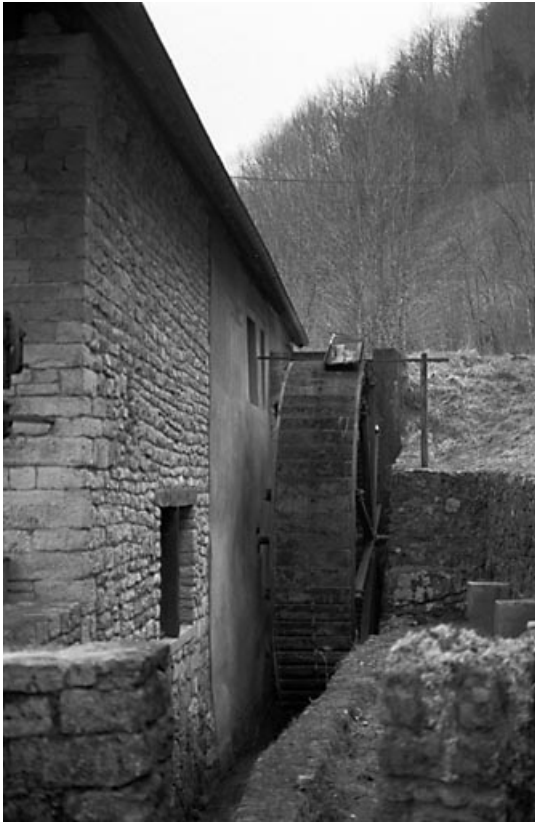
Façade latérale droite : la roue hydraulique verticale.
