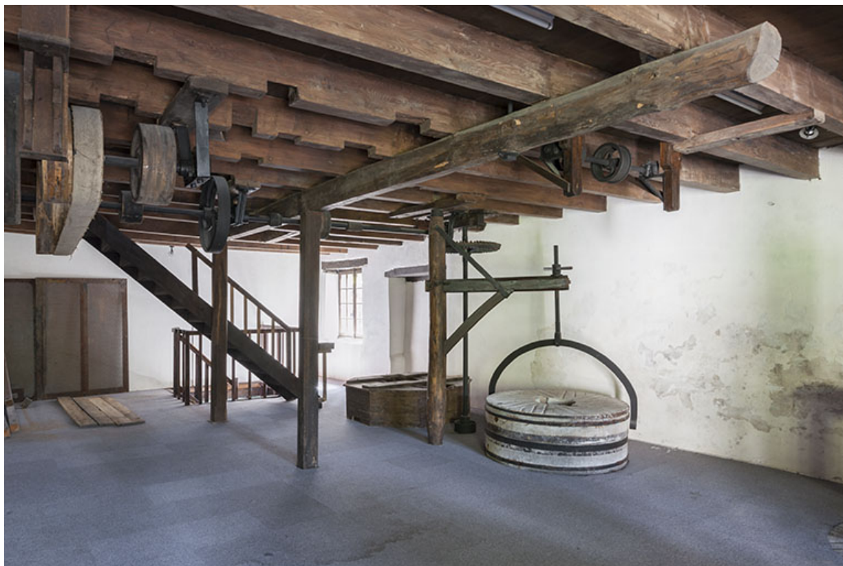
Premier étage. Vue d'ensemble depuis l'ouest.
