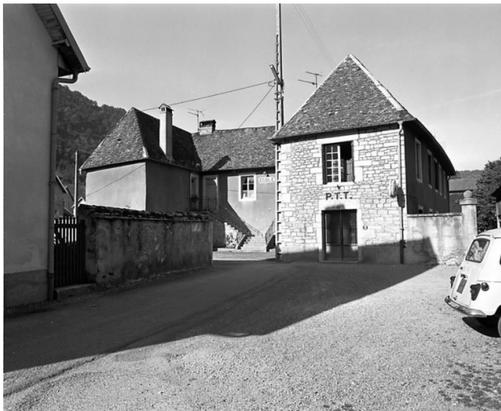
Façade antérieure vue de trois quarts droit. 25, Vuillafans
