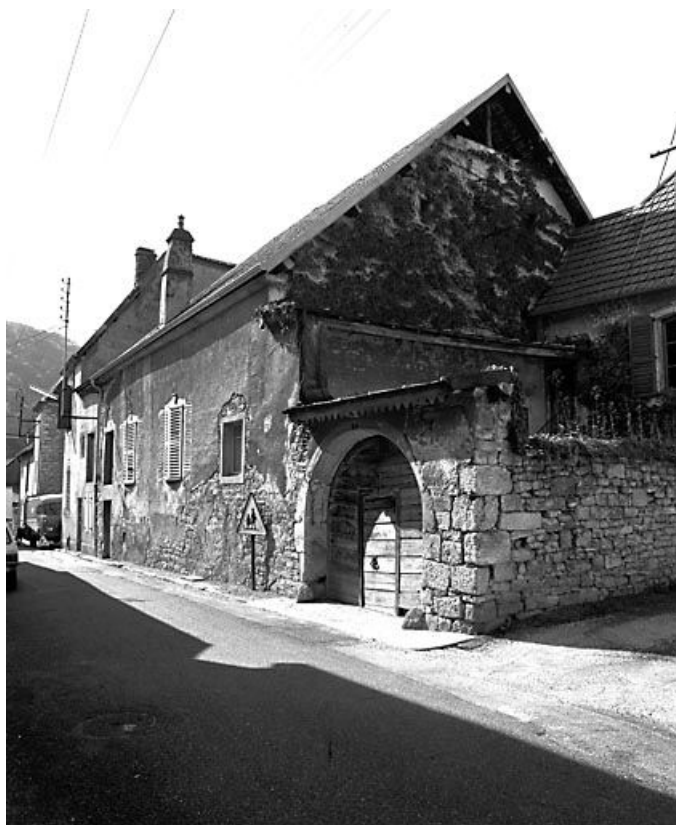
Façade antérieure vue de trois quarts droit. 25, Vuillafans
