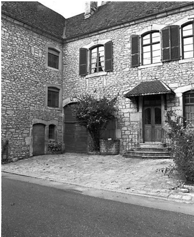
Façade antérieure : vue de trois quarts gauche. 25, Vuillafans
