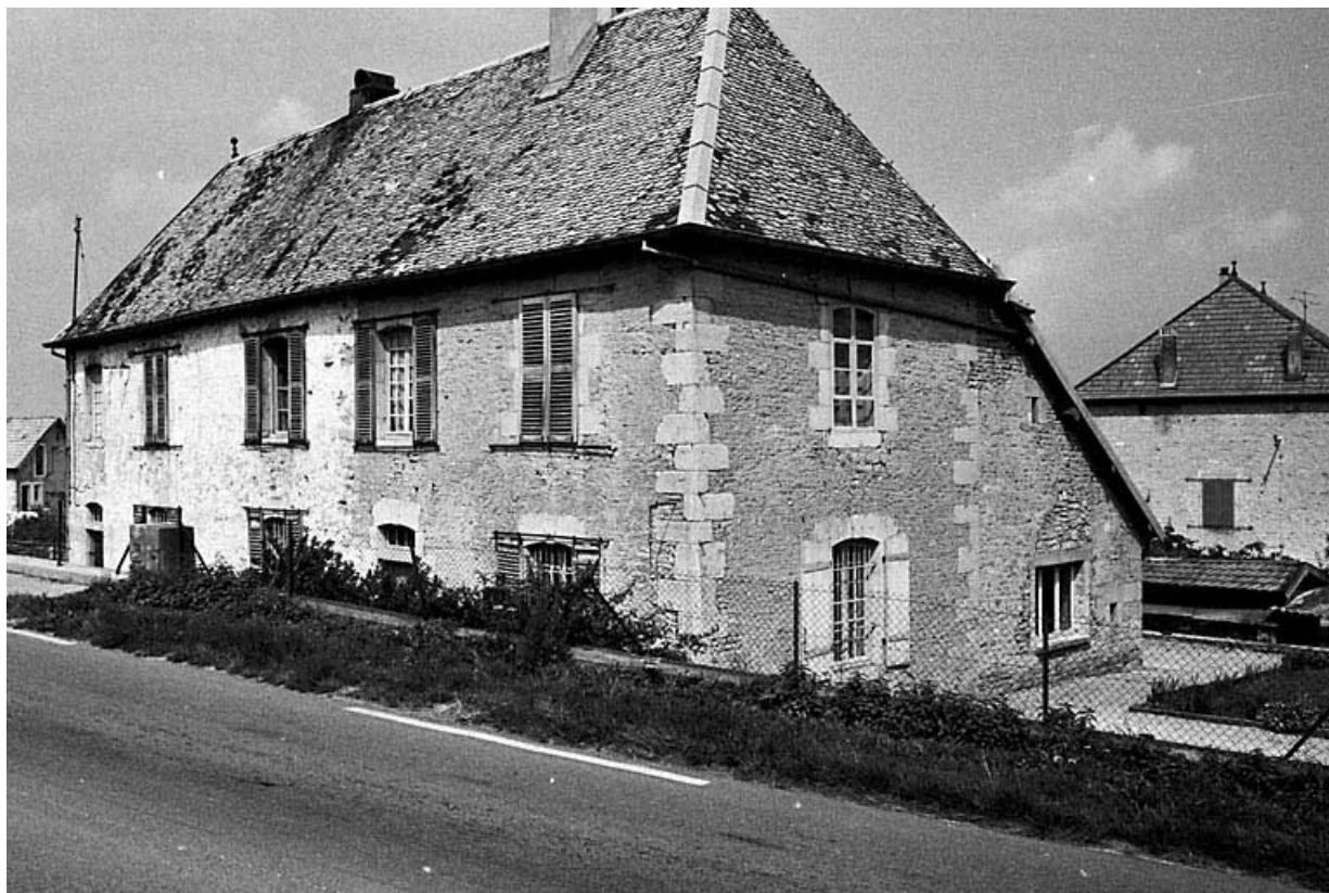
Façade antérieure et face latérale droite. 25, Tarcenay
