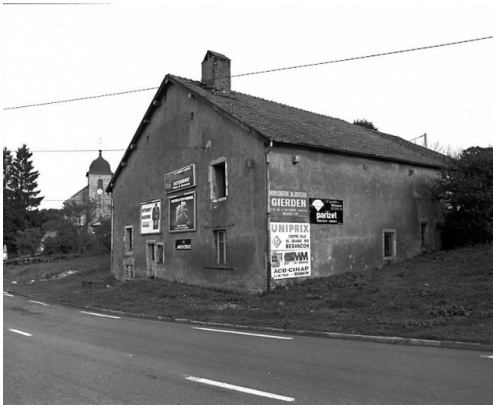
Façade antérieure et face latérale droite. 25, Tarcenay
