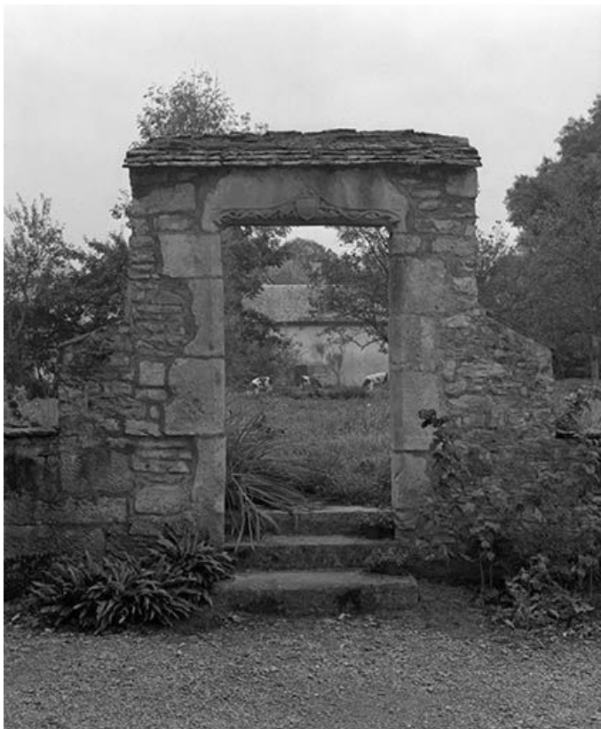
Maison située à Maisières-Notre-Dame : vestiges d'une porte piétonne au linteau décoré. 25, Scey-Maisières
