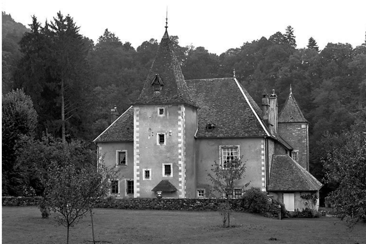
Façade antérieure. 25, Scey-Maisières
