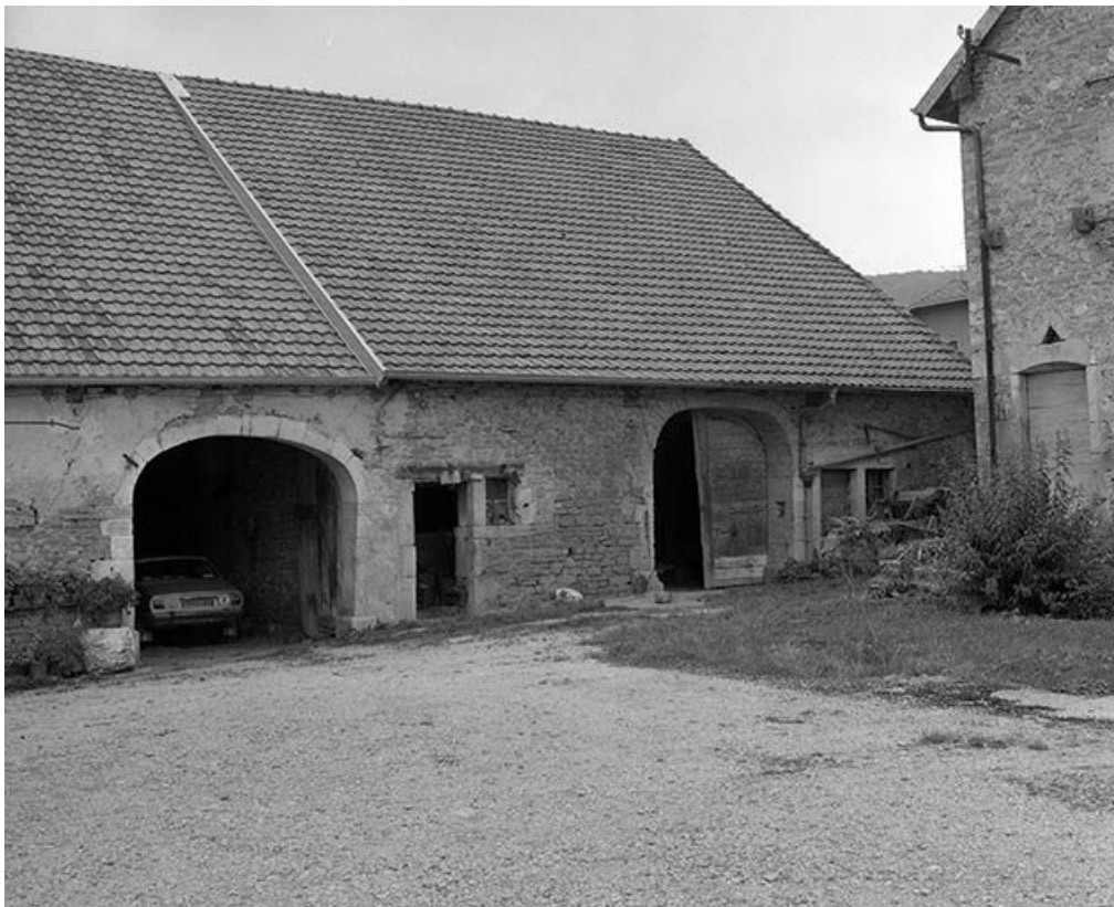
Ferme située à Scey-en-Varais, rue de l'Eglise. 25, Scey-Maisières
