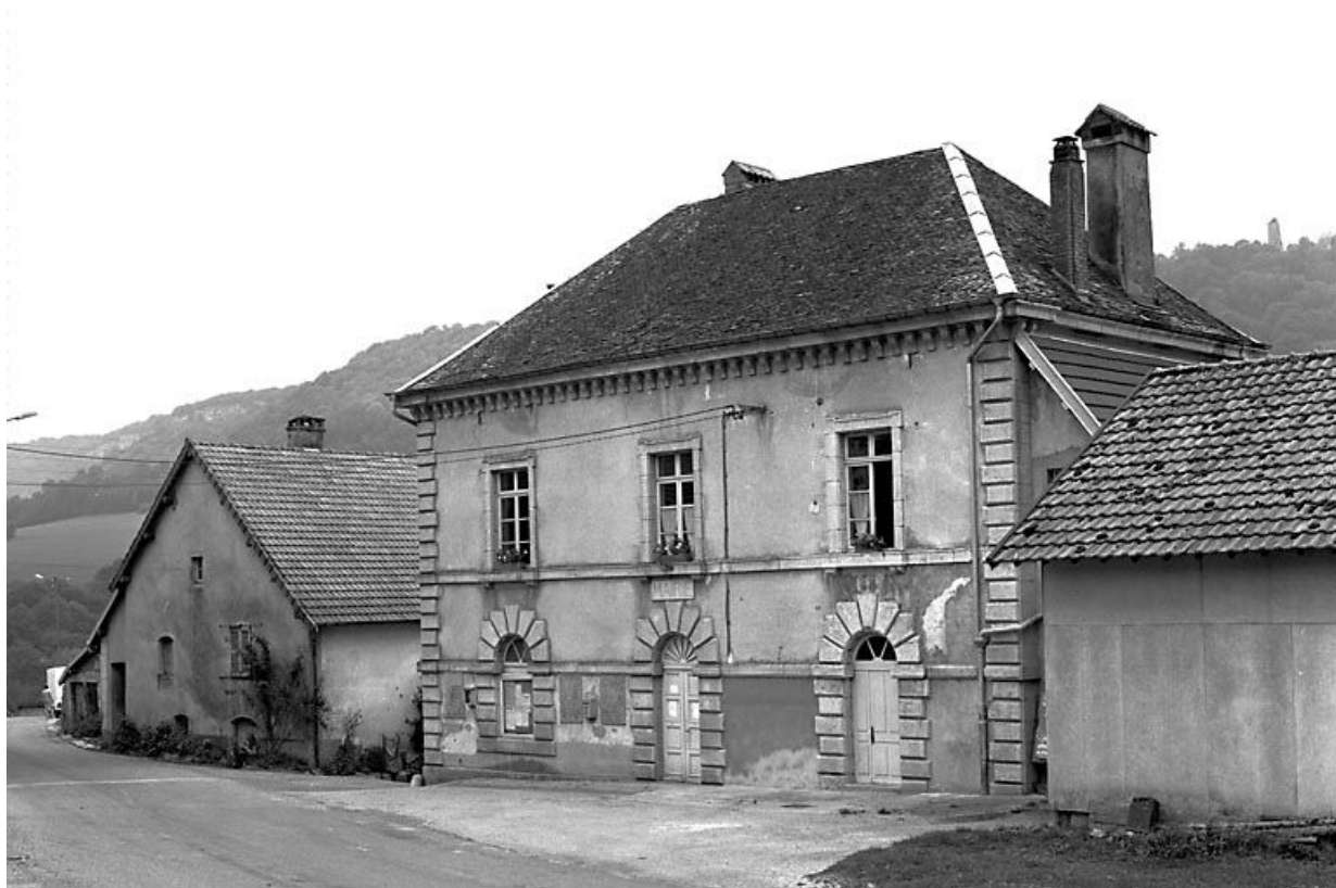
Façade antérieure. 25, Scey-Maisières
