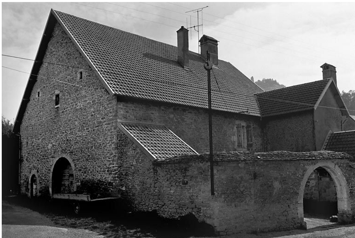
Façade antérieure et face latérale gauche. 25, Scey-Maisières
