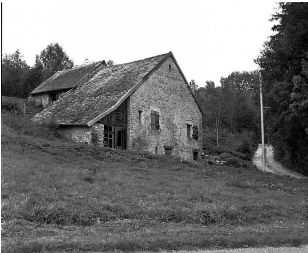
Vue générale de trois quarts gauche. 25, Scey-Maisières
