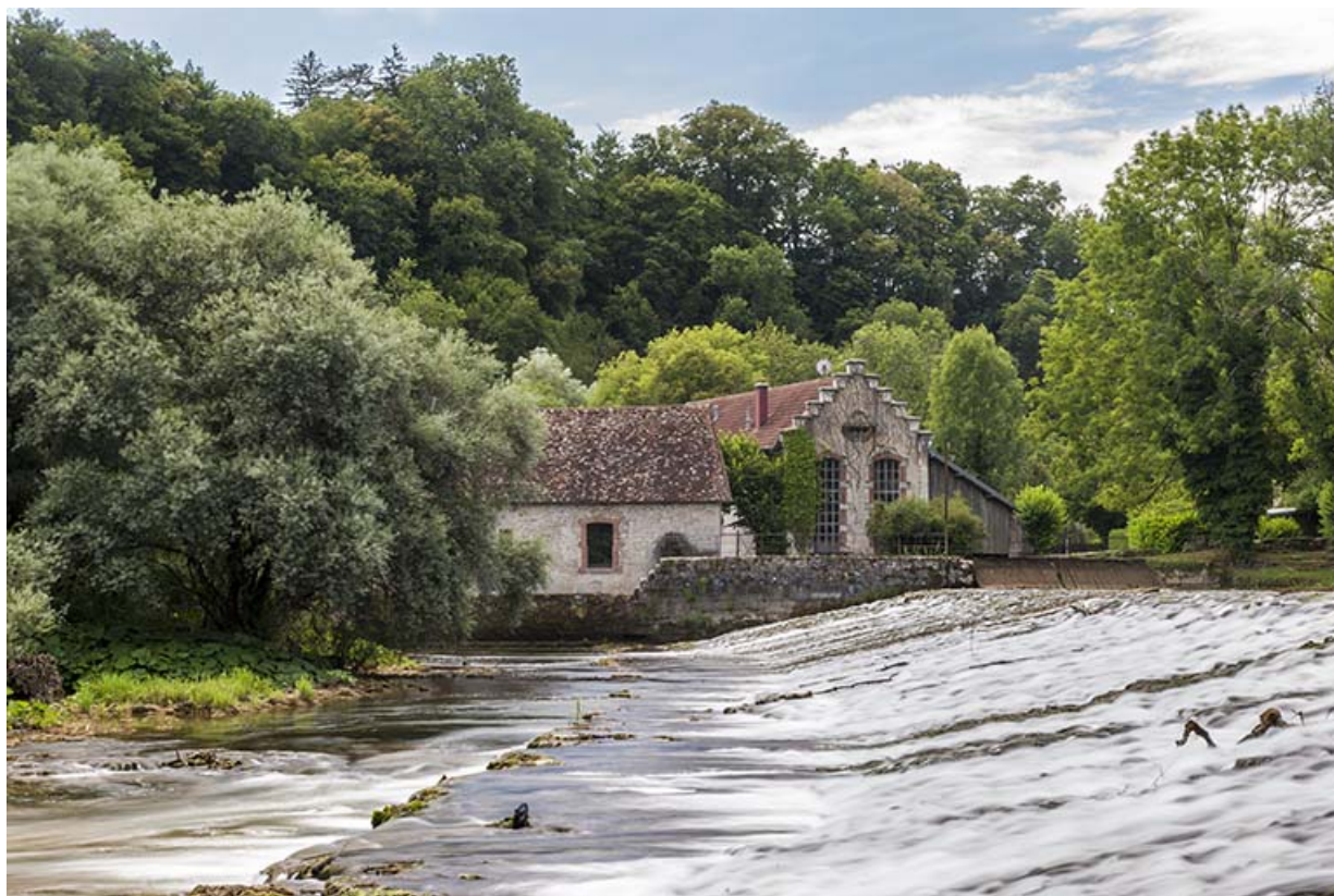
Vue d'ensemble depuis l'extrémité du barrage, au nord.
