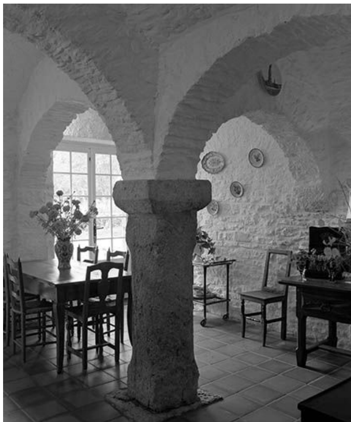
Maison située à Maisières-Notre-Dame : cuisine voûtée avec pilier central. 25, Scey-Maisières
