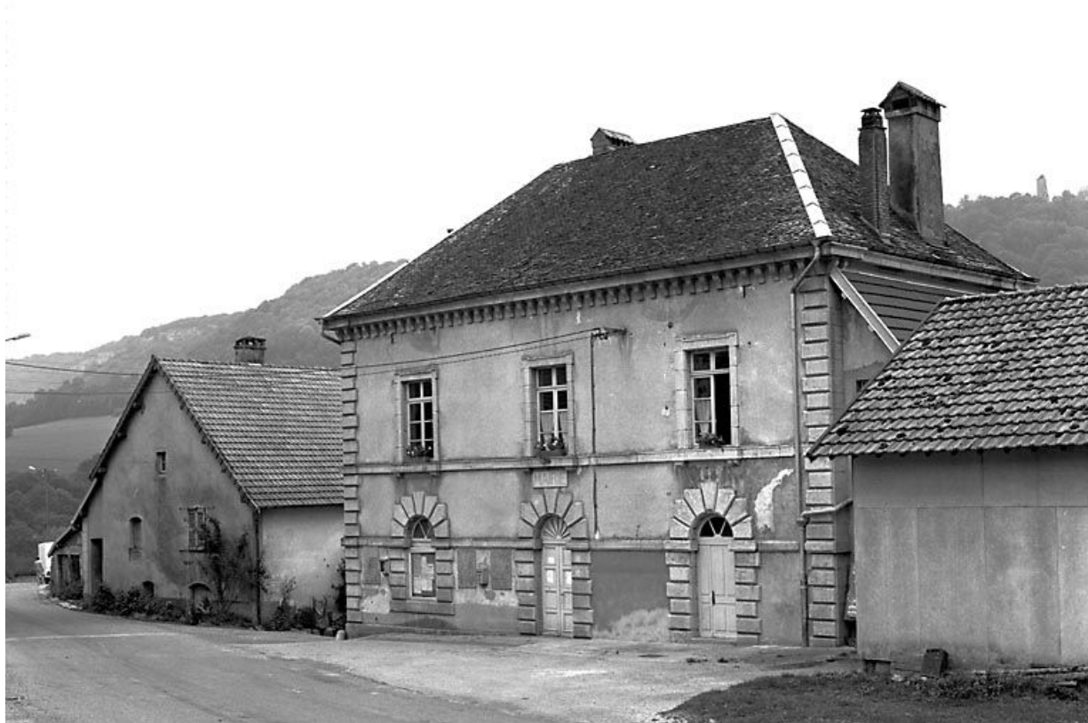
Façade antérieure. 25, Scey-Maisières
