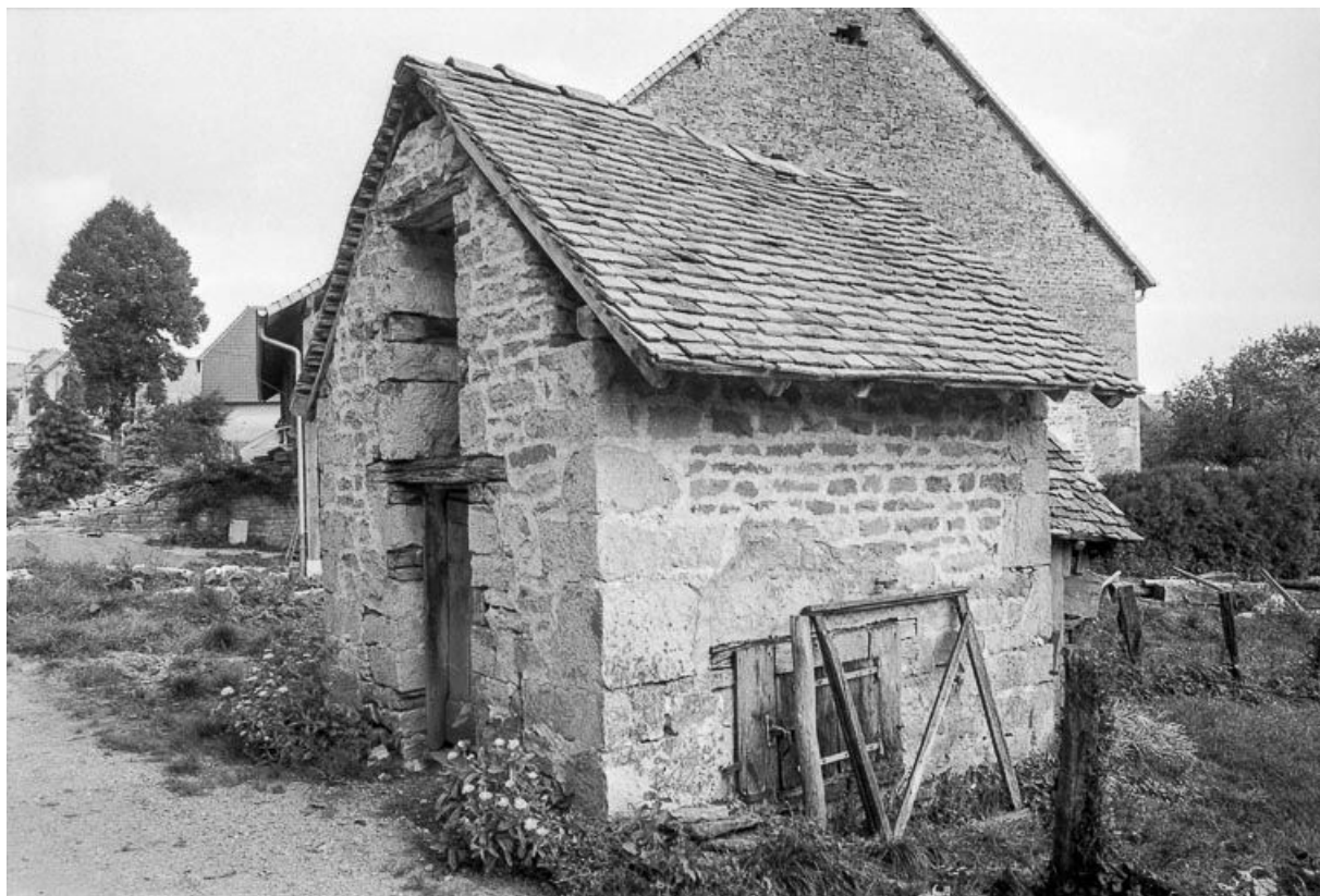
Toit à porc (soue) vu de trois quarts droit.
