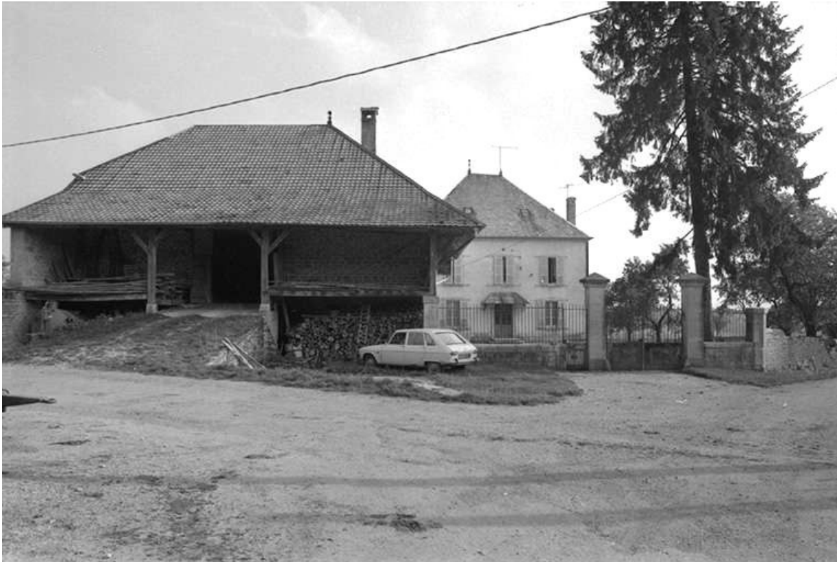
Vue d'ensemble depuis la rue.
