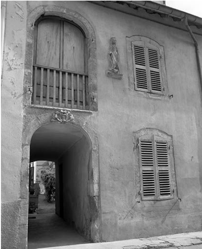
Détail de la façade antérieure : le passage voûté.
