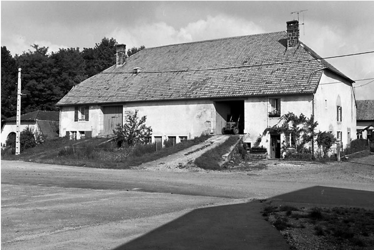
Façade antérieure et face latérale droite.
