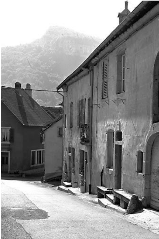
Façade antérieure vue de trois quarts droit. 25, Mouthier-Haute-Pierre
