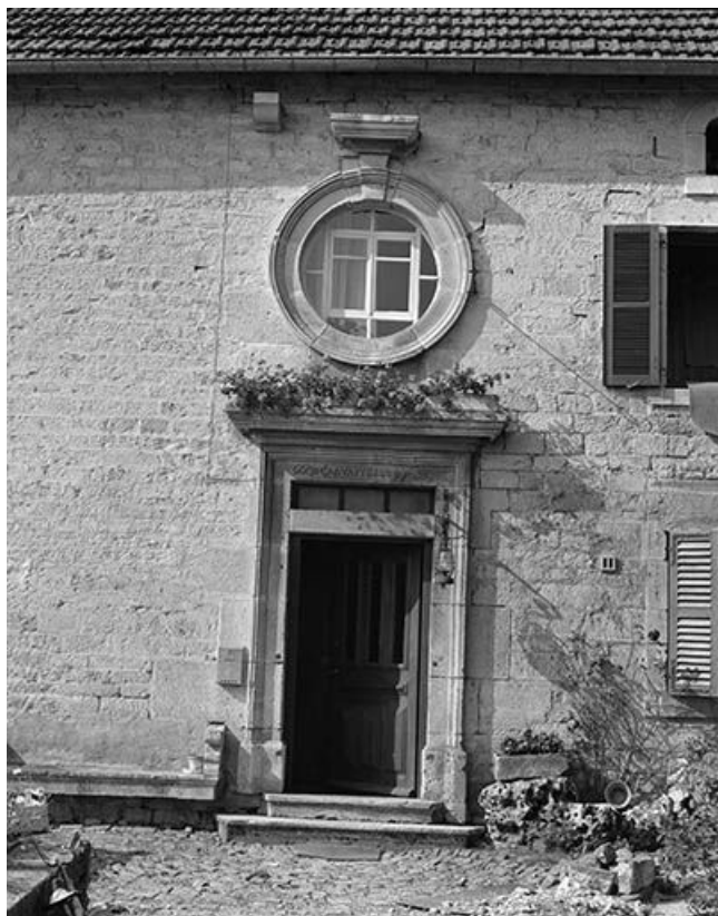
Porte d'entrée du logis.
