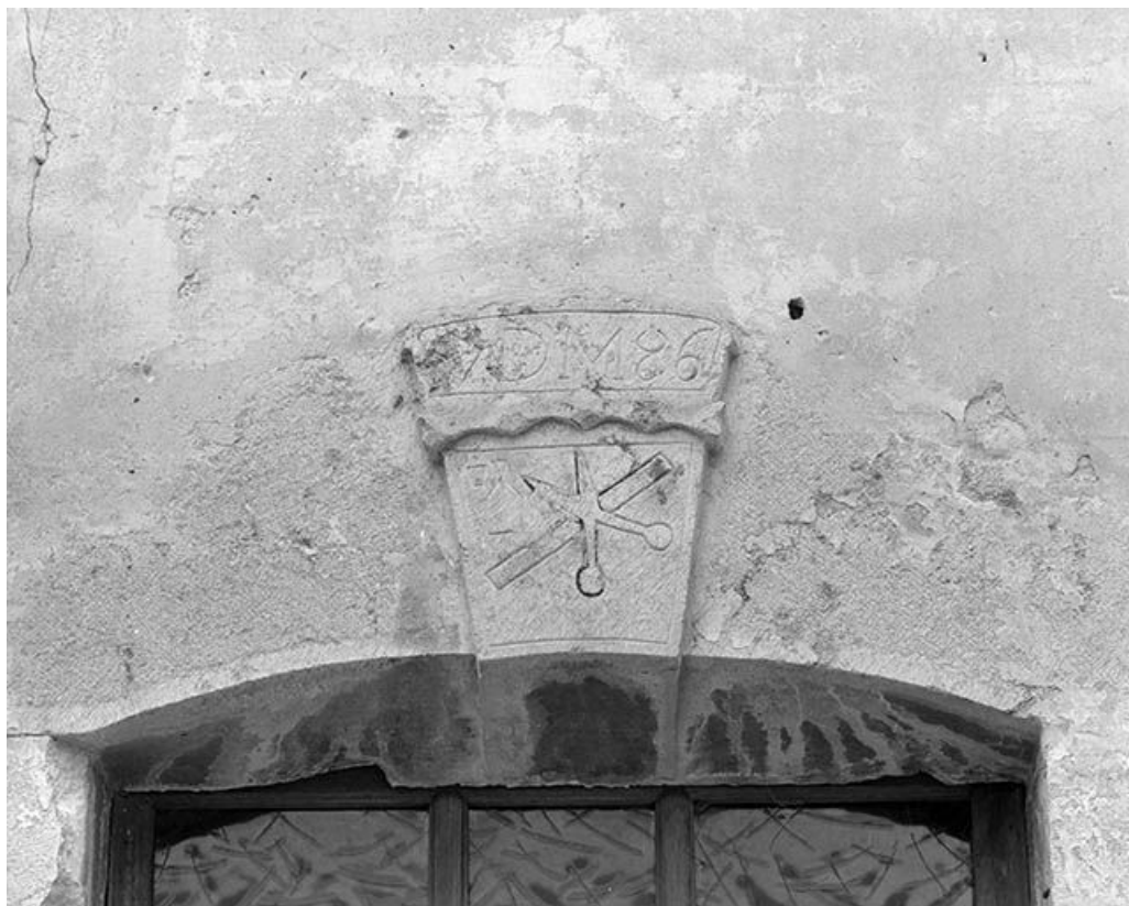
Détail de la façade antérieure : clef de la porte piétonne.
