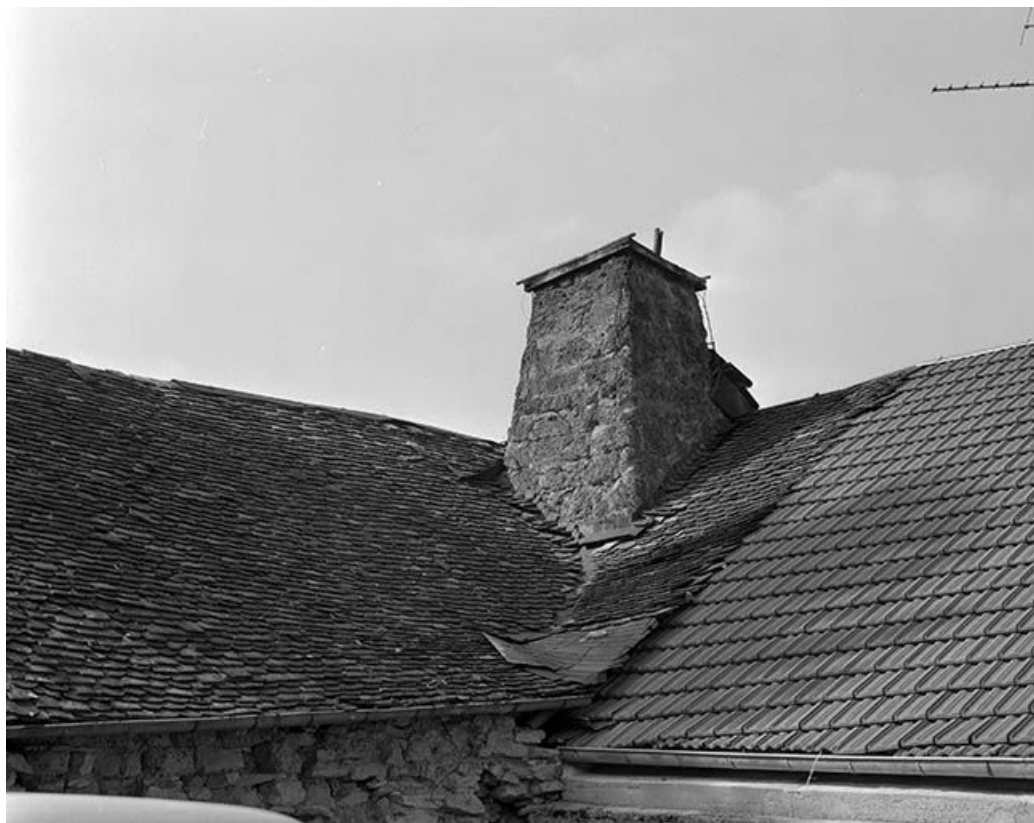
Maison située rue de Jaubourg, cadastrée 1971 AC 66 : cheminée. 25, Lods
