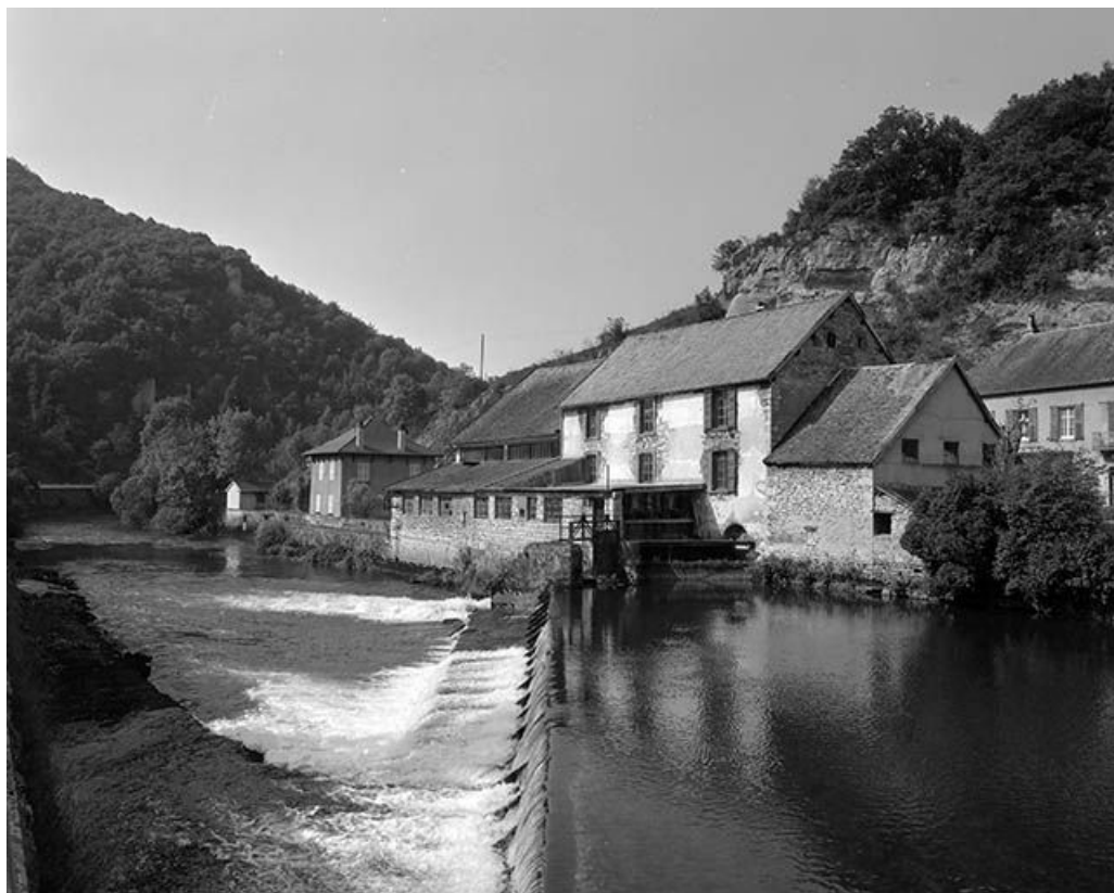
Vue générale, depuis la rive gauche de la Loue, de la minoterie Hanriot, cadastré 1971 AB 15. 25, Lods
