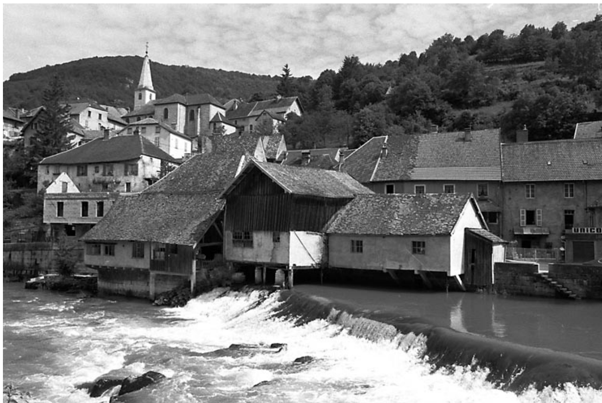
Vue générale depuis la rive gauche de la Loue. 25, Lods
