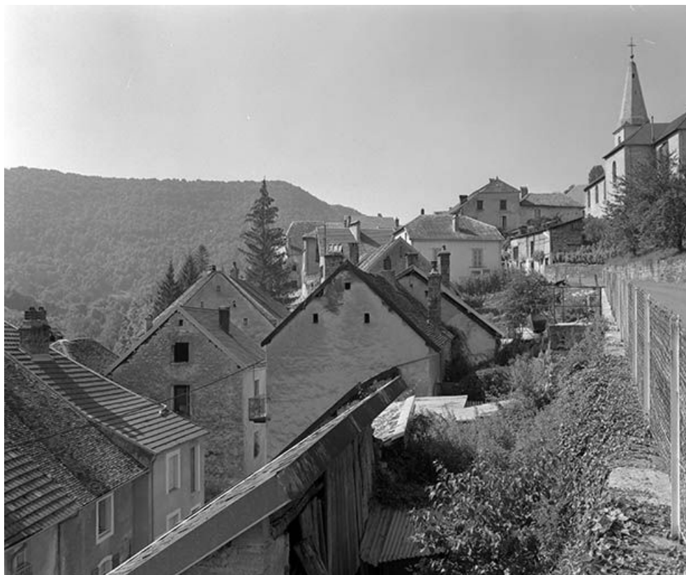
La rue de Reine depuis la route d'Athose. 25, Lods
