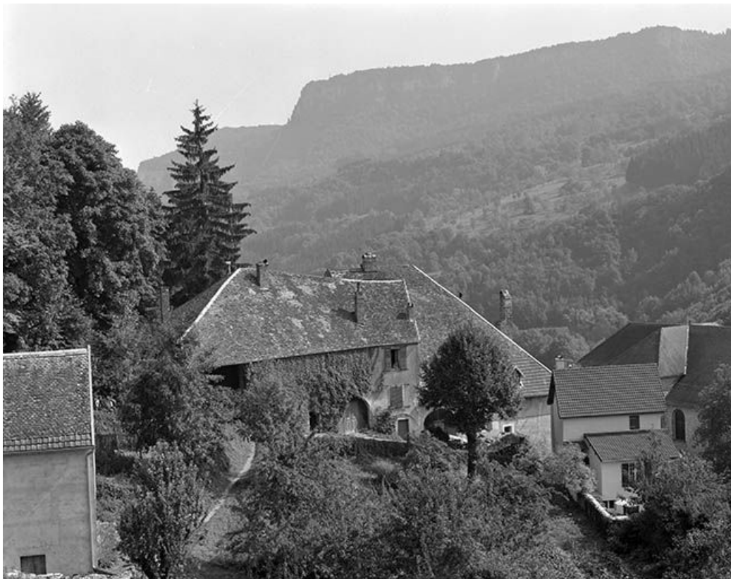
Maison située rue de l'Eglise, cadastrée 1971 AC 99 : vue depuis le sentier de la Planche. 25, Lods
