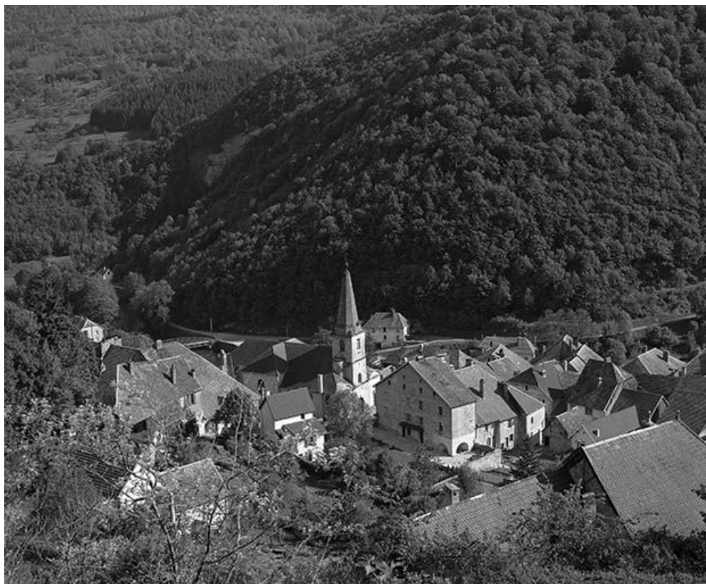
Vue générale depuis le nord-ouest.
