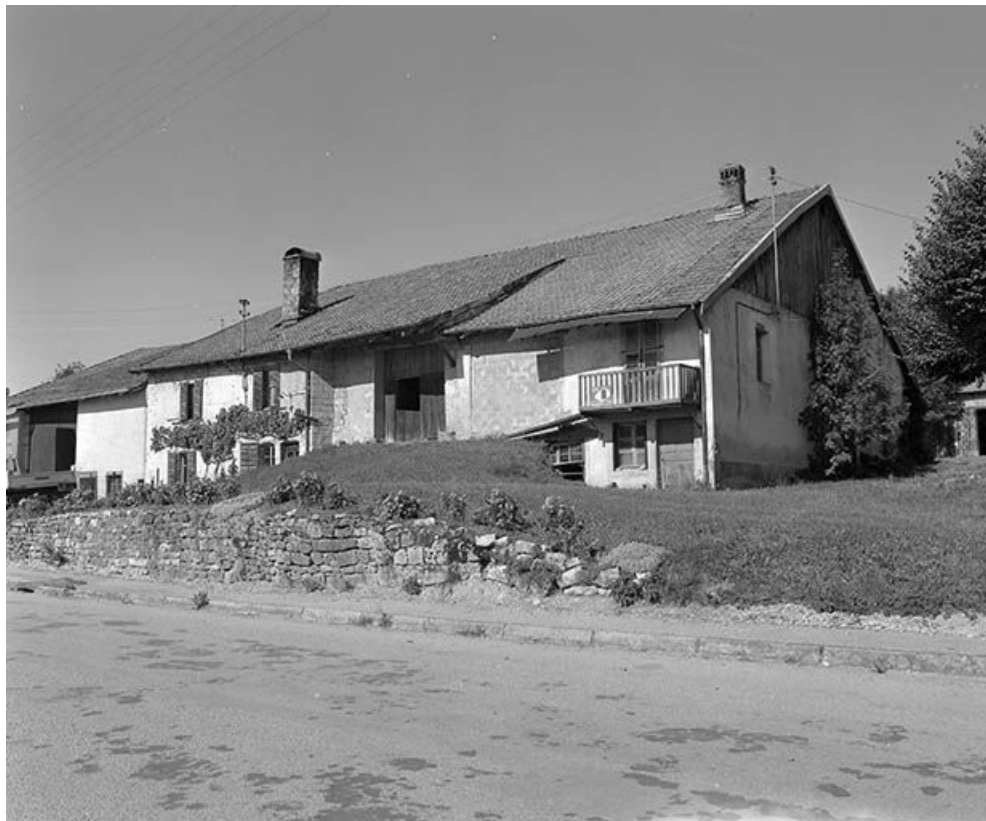
Façade antérieure et face latérale droite.
