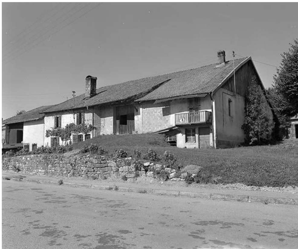
Façade antérieure et face latérale droite.
