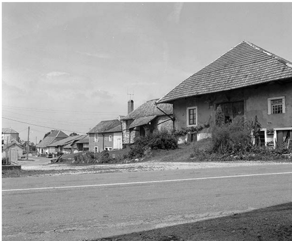
Vue générale des maisons bordant la rue conduisant à l'église paroissiale. 25, Foucherans
