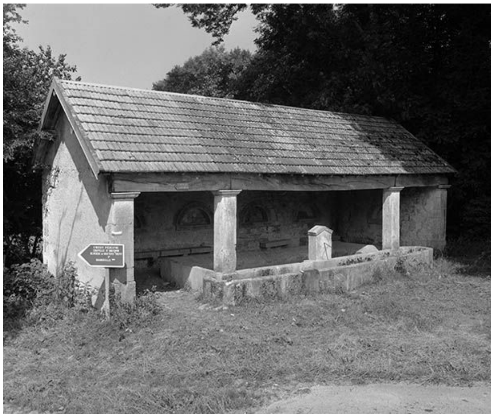
Vue générale de trois quarts gauche. 25, Foucherans
