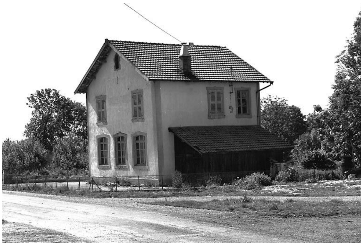
Façade postérieure et face latérale droite. 25, Échevannes
