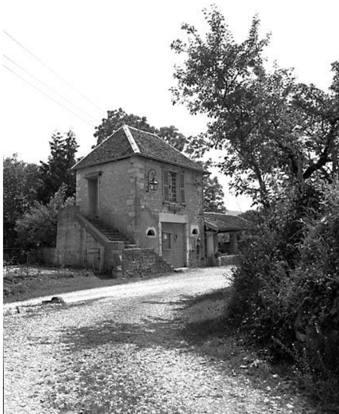
Façade antérieure et face latérale gauche. 25, Châteauvieux-les-Fossés
