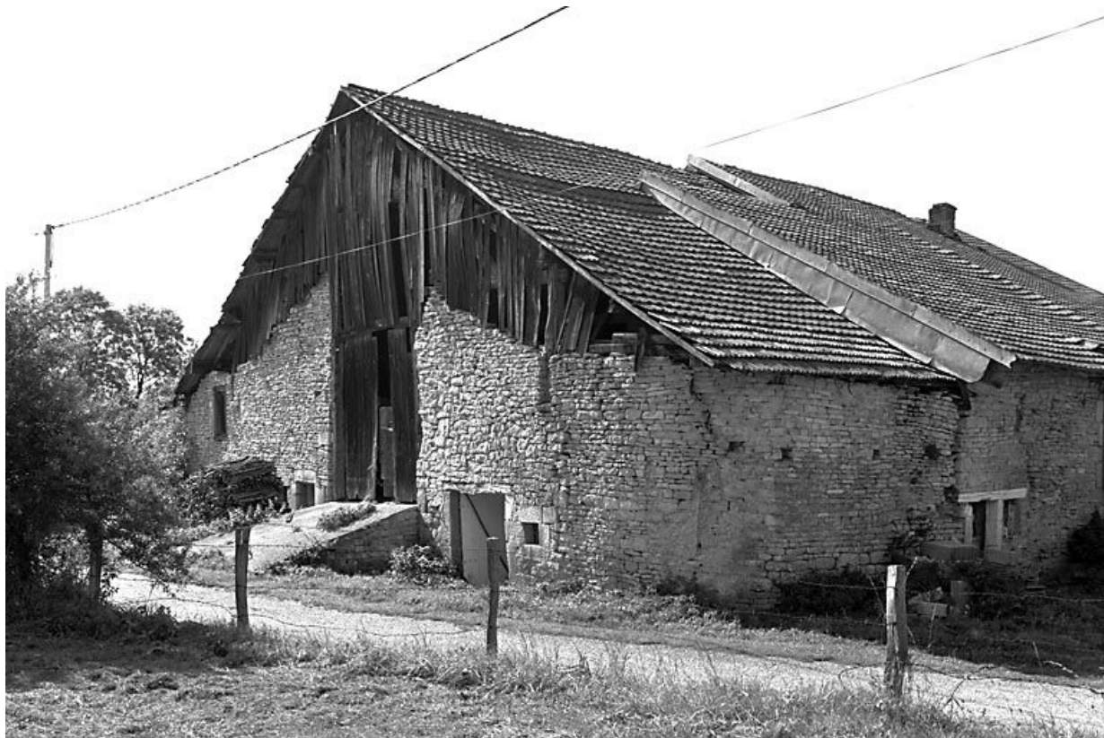
Vue générale depuis la rue. 25, Chassagne-Saint-Denis
