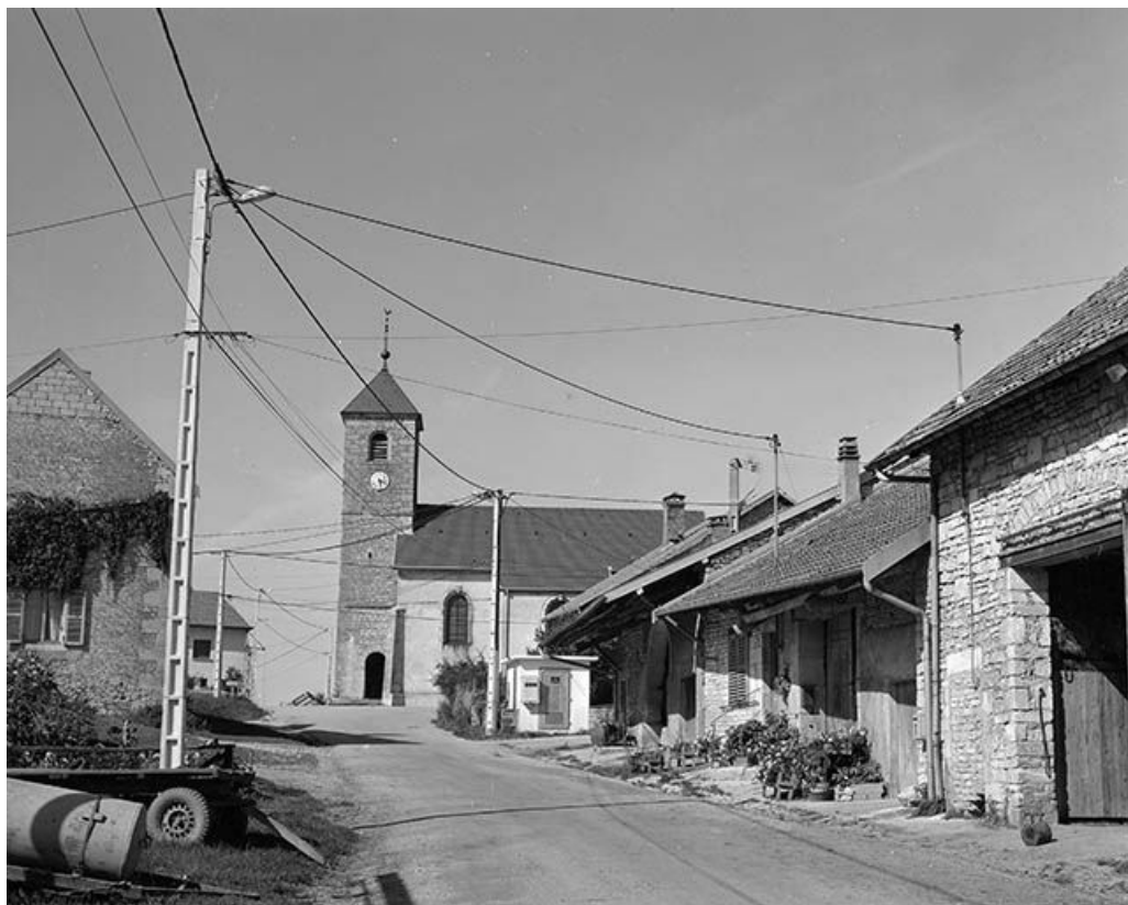
Maisons et fermes de la Grande Rue. 25, Chassagne-Saint-Denis
