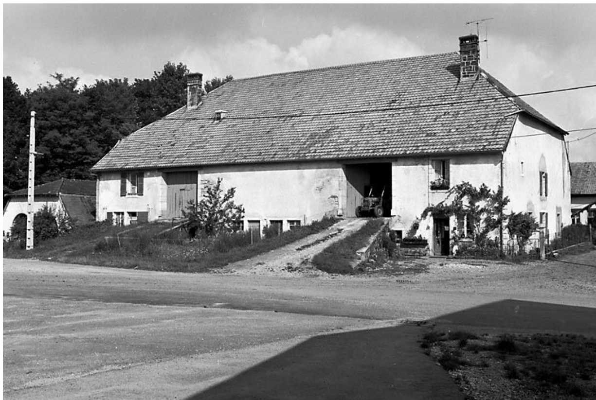
Façade antérieure et face latérale droite.
