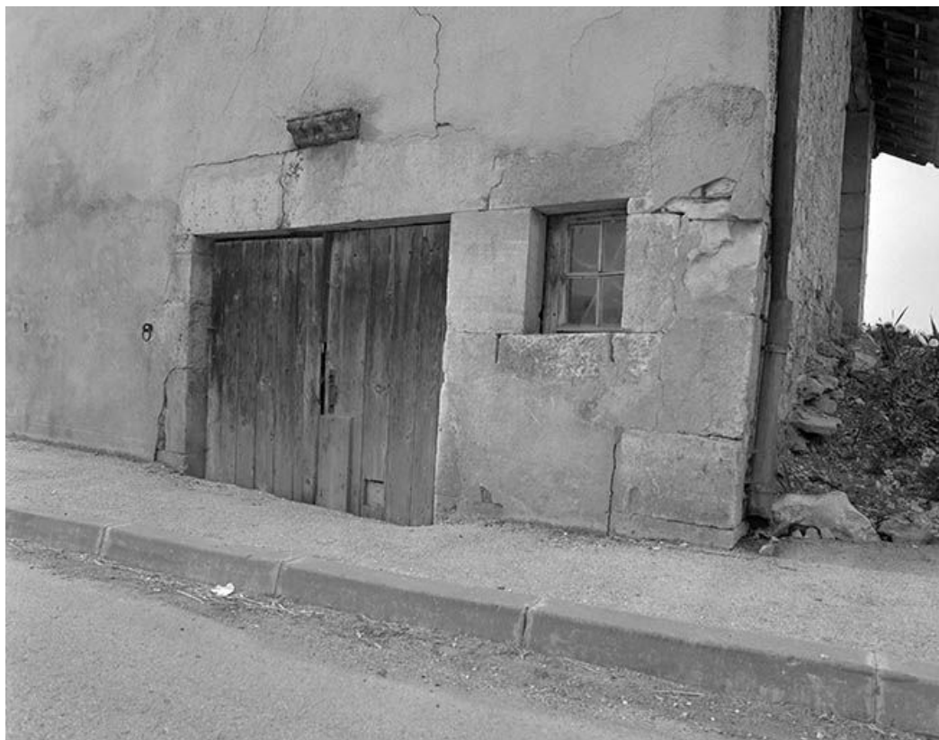
Ferme cadastrée 1968 AC 69, située route de Salins : décor d'architecture placé au-dessus du linteau de la porte des écuries. 25, Chantrains
