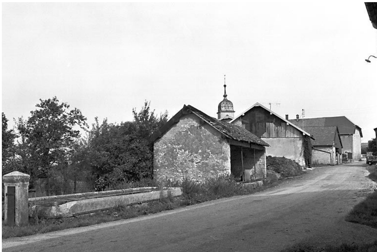
Vue générale. 25, Chantrains
