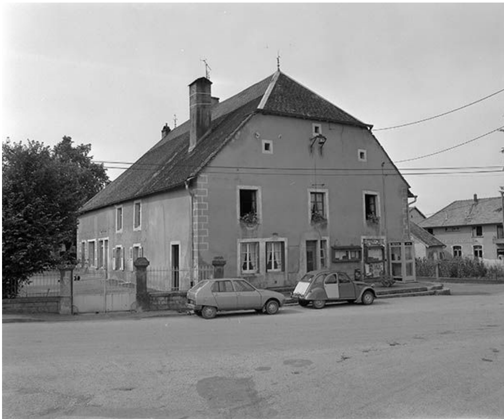
Façade antérieure et face latérale gauche. 25, Chantrains
