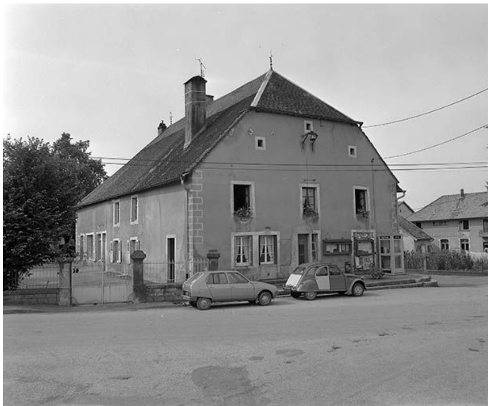
Façade antérieure et face latérale gauche. 25, Chantrains
