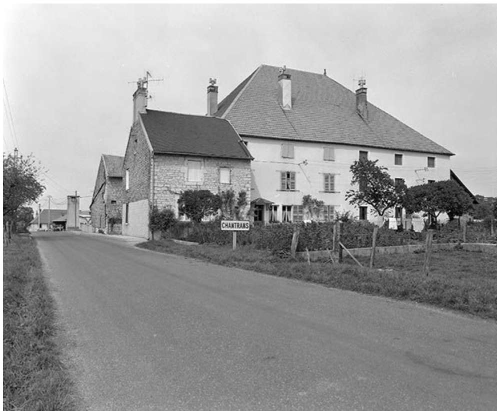
Vue d'ensemble depuis la RN 492. 25, Chantrons
