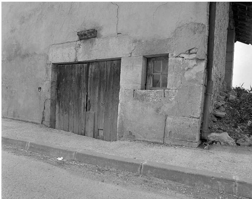
Ferme cadastrée 1968 AC 69, située route de Salins : décor d'architecture placé au-dessus du linteau de la porte des écuries. 25, Chantrains
