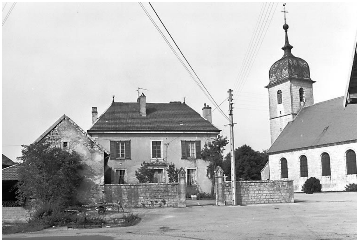
Vue générale. 25, Chantrains
