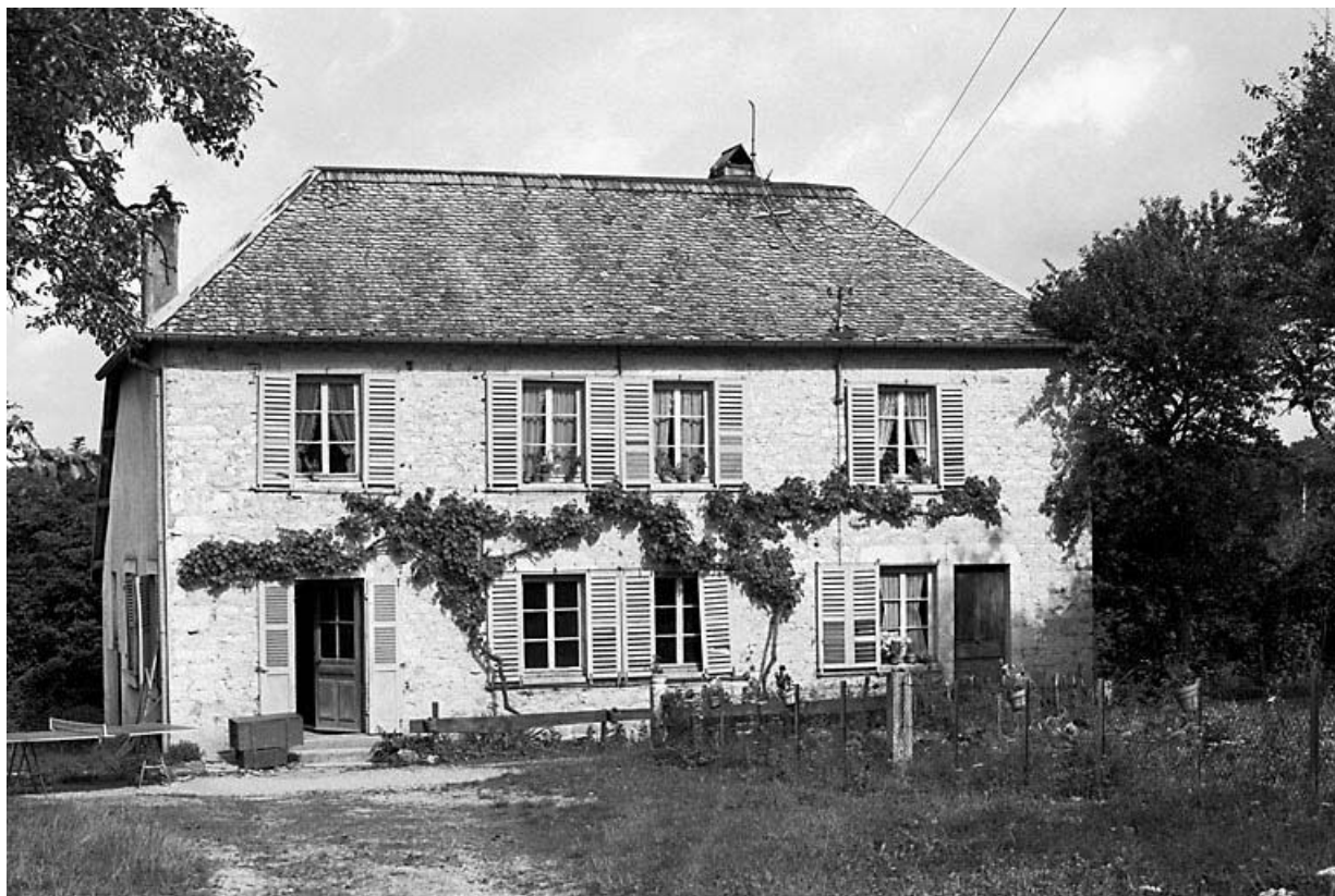
Façade antérieure et face latérale gauche. 25, Bonnevaux-le-Prieuré
