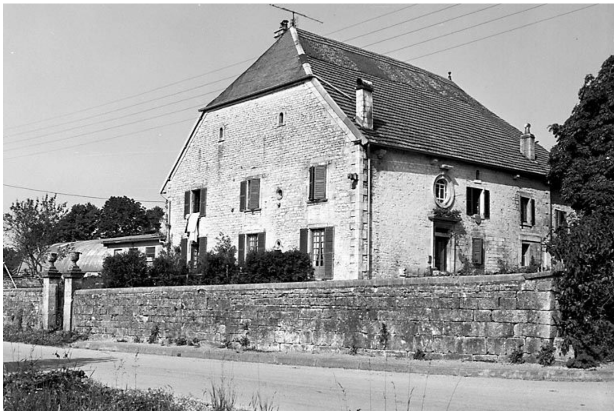
Façade antérieure et face latérale gauche depuis la rue. 25, Amathay-Vésigneux
