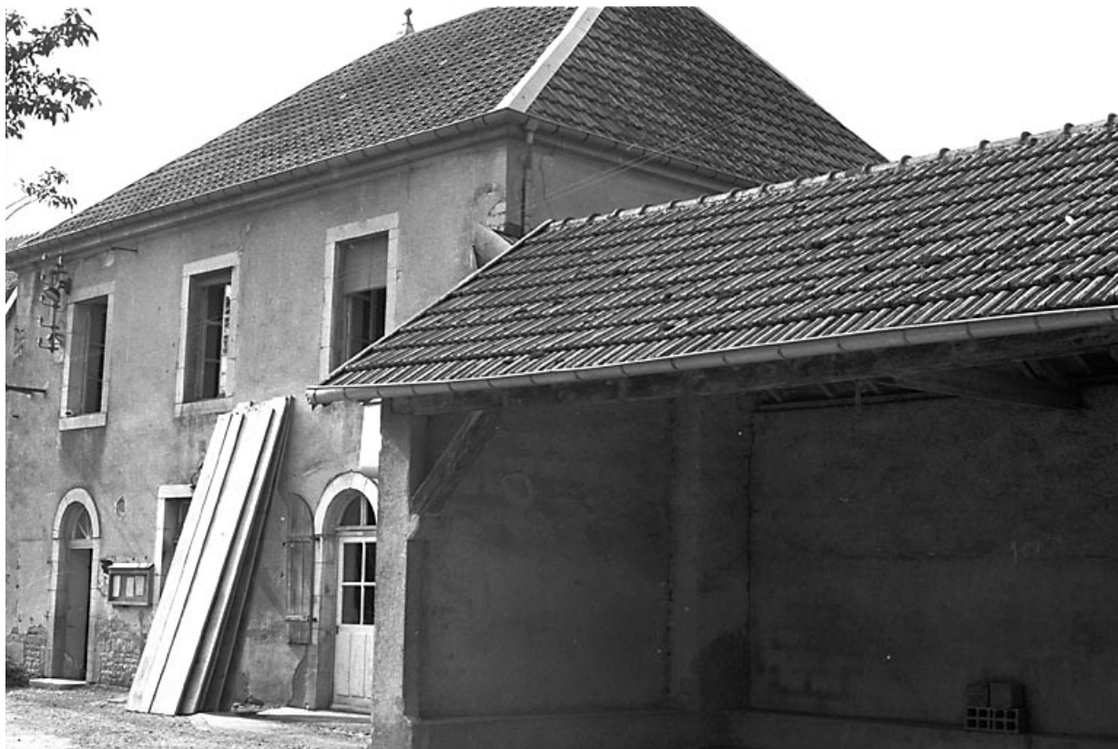
Façade antérieure vue de trois quarts droit. 25, Villers-sous-Montrond
