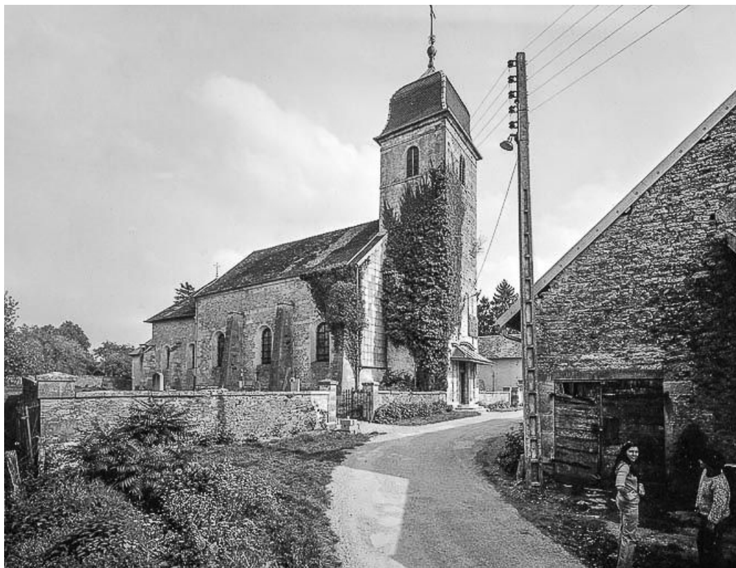
Façade antérieure et face latérale gauche. 25, Villers-sous-Montrond
