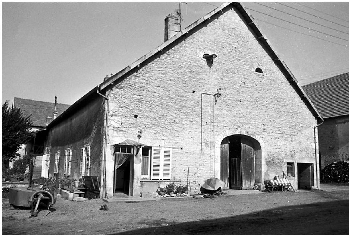
Façade antérieure et face latérale gauche. 25, Villers-sous-Montrond
