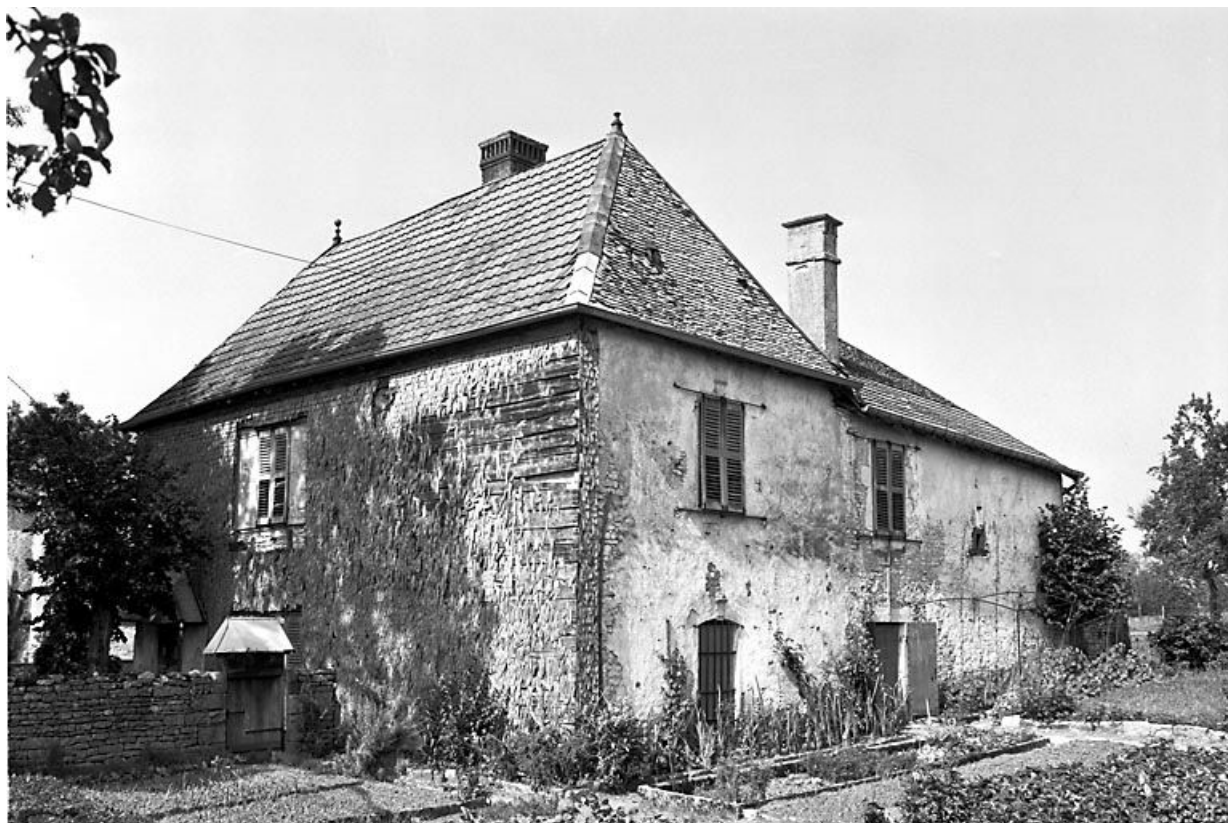
Façade antérieure et face latérale droite. 25, Saules
