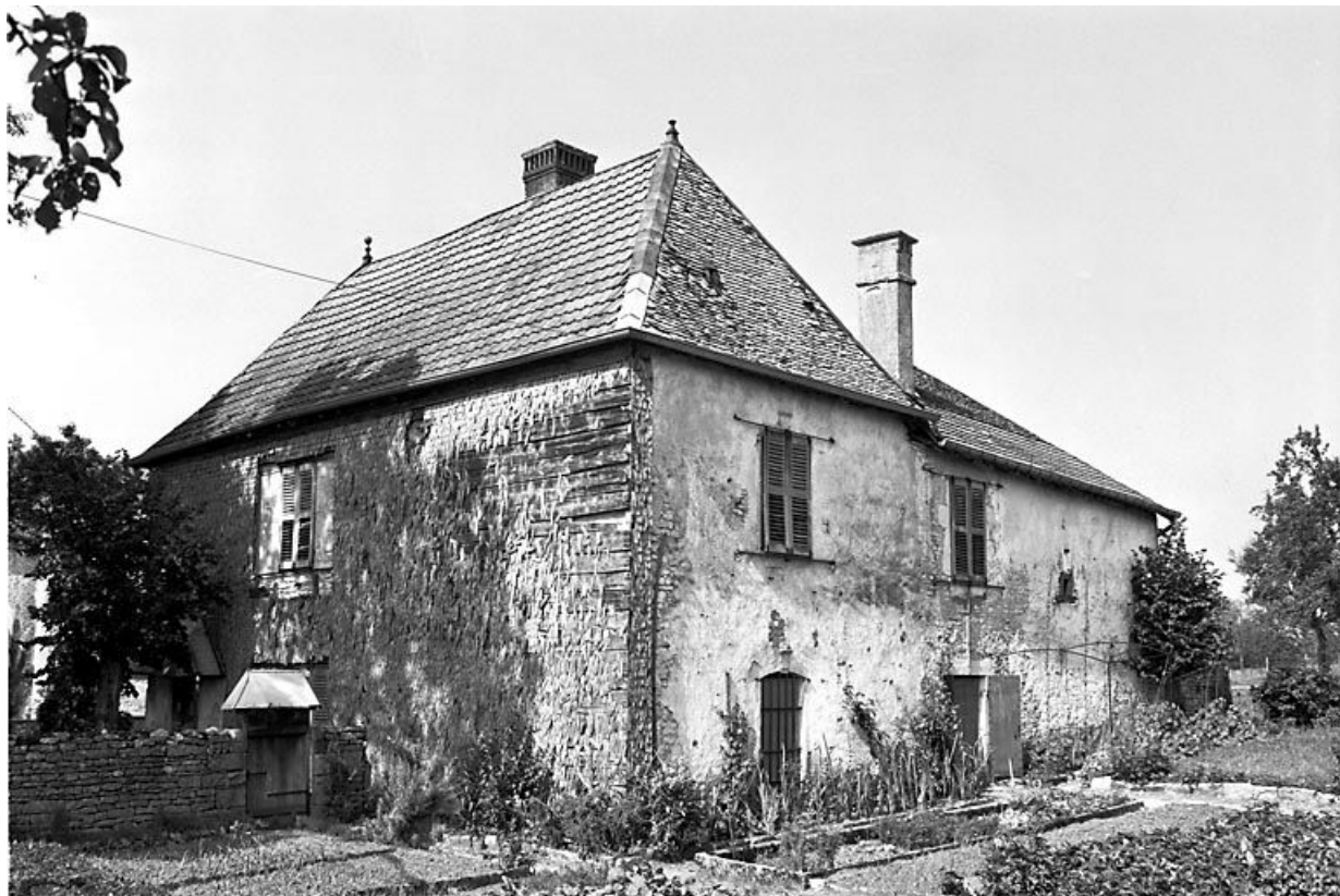
Façade antérieure et face latérale droite. 25, Saules
