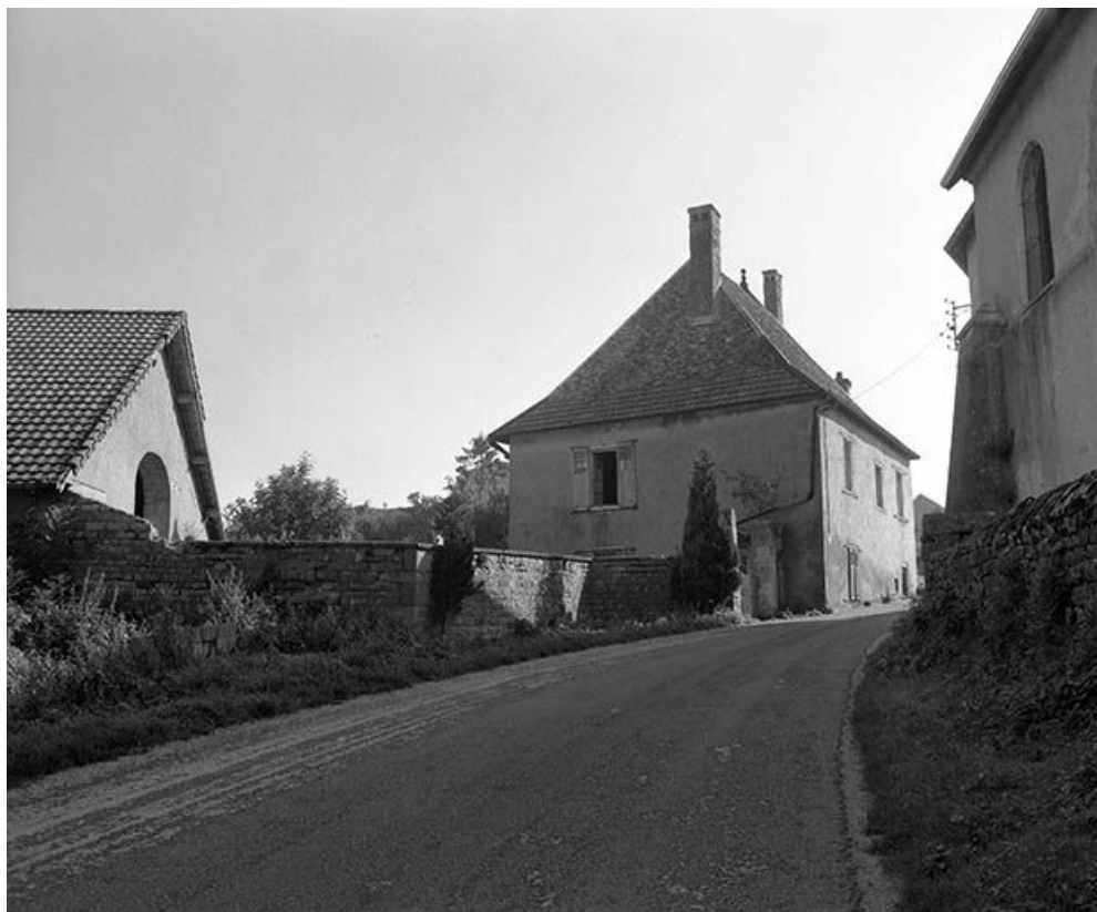
Vue d'ensemble depuis la rue. 25, Trépot
