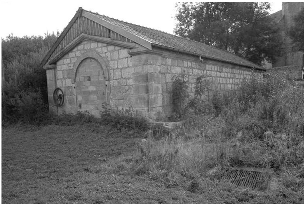
Fontaine, abreuvoir cadastrée 1972 AB 15 : vue générale. 25, Trépot
