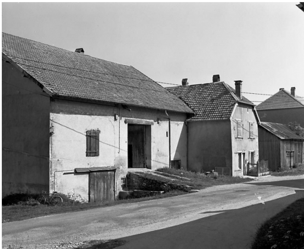
Vue d'ensemble depuis la rue. 25, Trépot
