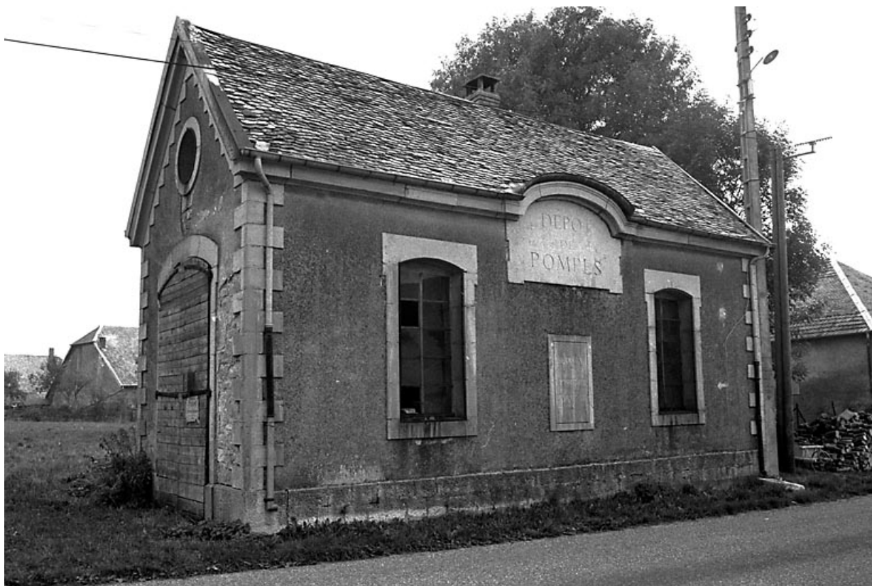
Façade antérieure vue de trois quarts gauche. 25, Trépot
