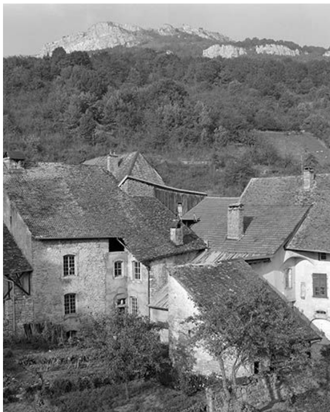
Façades postérieures des maisons cadastrées 1971 AB 376 à 380 de la rue Robert Dame. 25, Mouthier-Haute-Pierre
