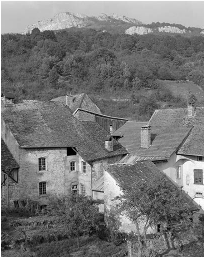
Façades postérieures des maisons cadastrées 1971 AB 376 à 380 de la rue Robert Dame. 25, Mouthier-Haute-Pierre
