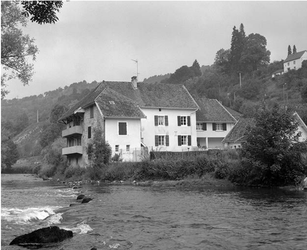
Vue générale de l'ancienne tannerie transformée en logement. 25, Mouthier-Haute-Pierre
