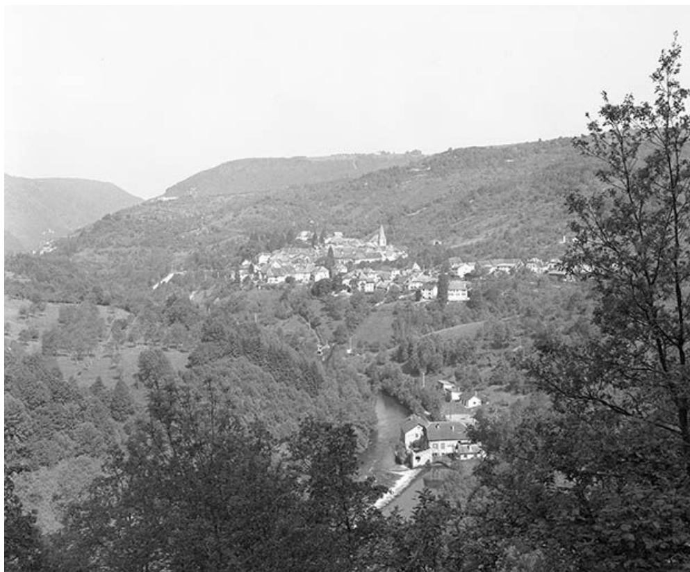
Vue générale depuis le point de vue en bordure de la N67 en amont du village. 25, Mouthier-Haute-Pierre
