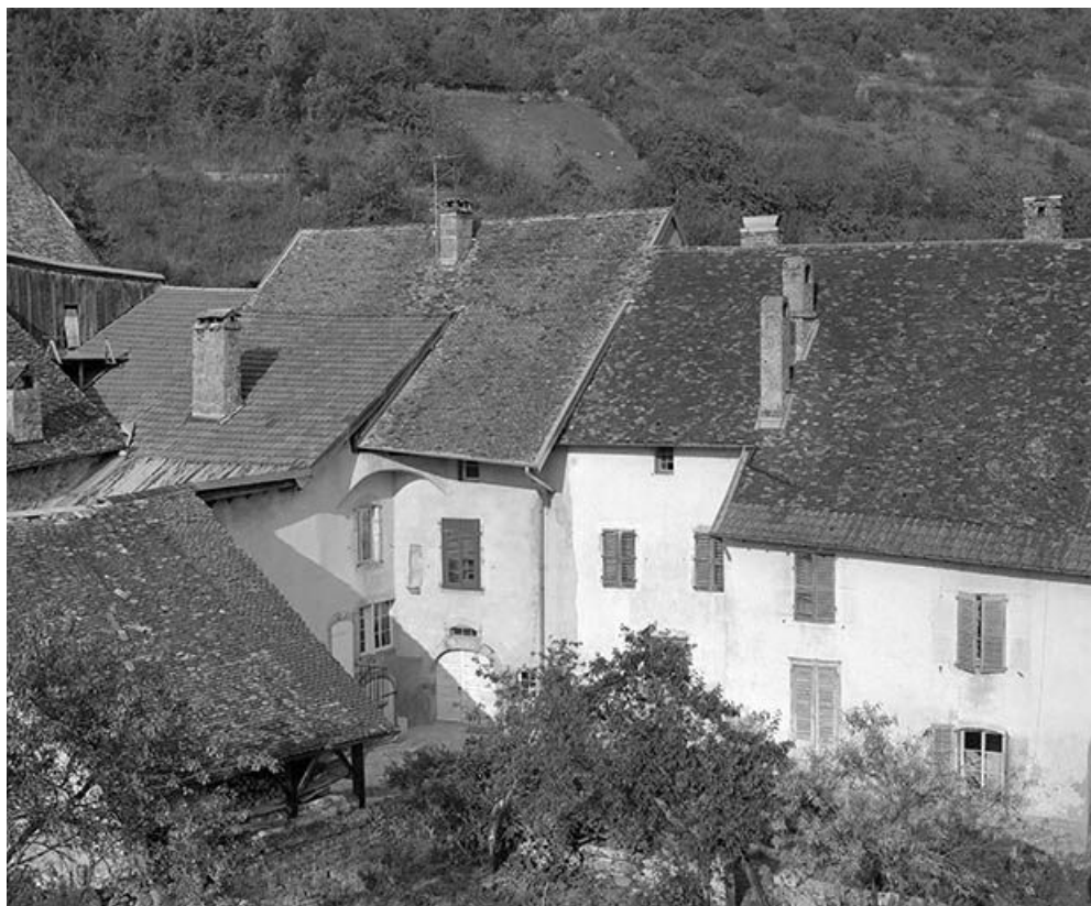
Façades postérieures des maisons cadastrées 1971 AB 380 à 381 de la rue Robert Dame. 25, Mouthier-Haute-Pierre
