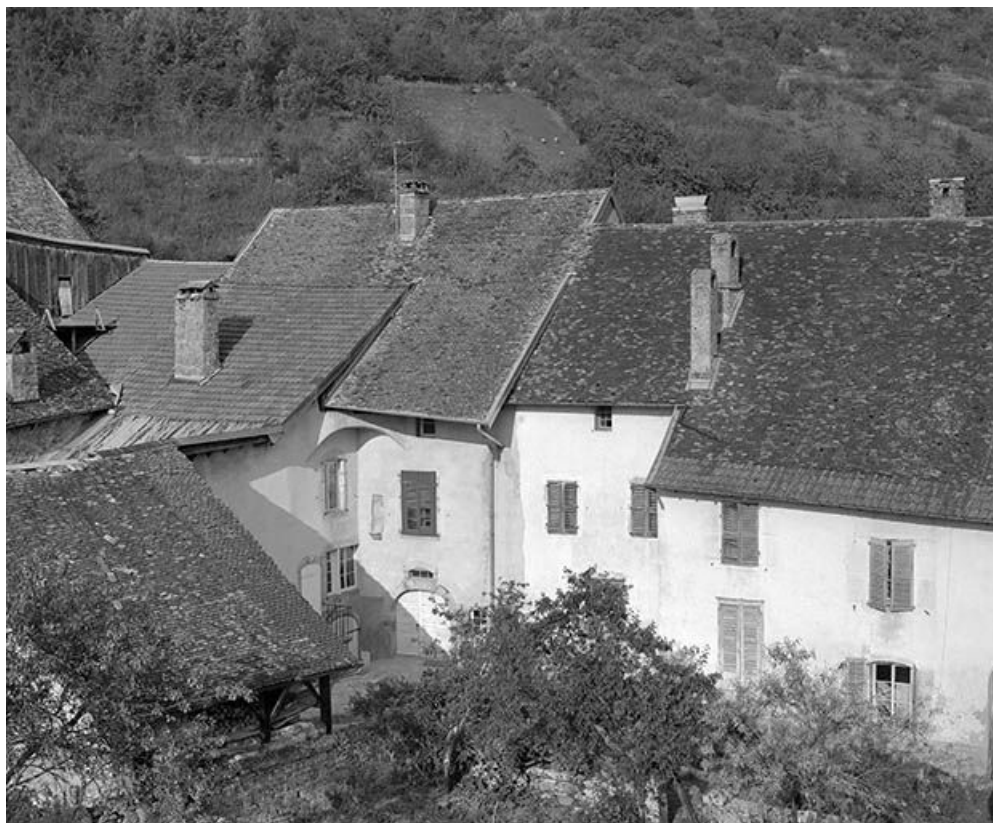
Façades postérieures des maisons cadastrées 1971 AB 380 à 381 de la rue Robert Dame. 25, Mouthier-Haute-Pierre
