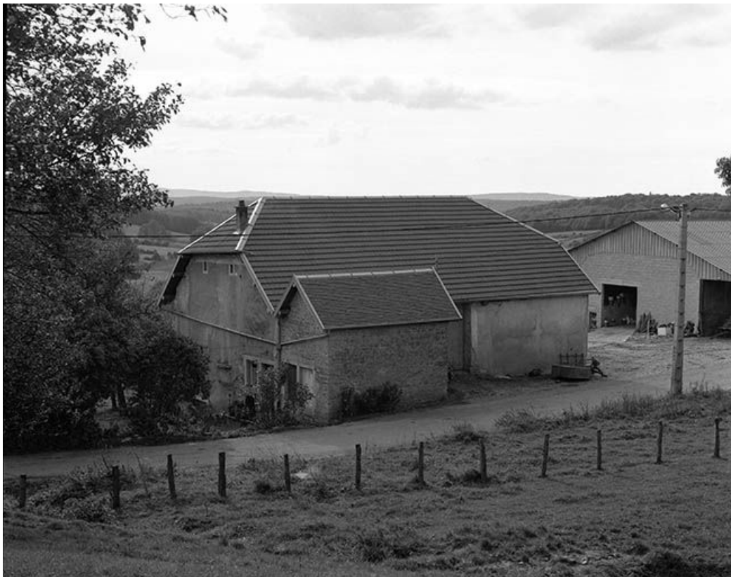
Façade antérieure et face latérale droite. 25, Malbrans
