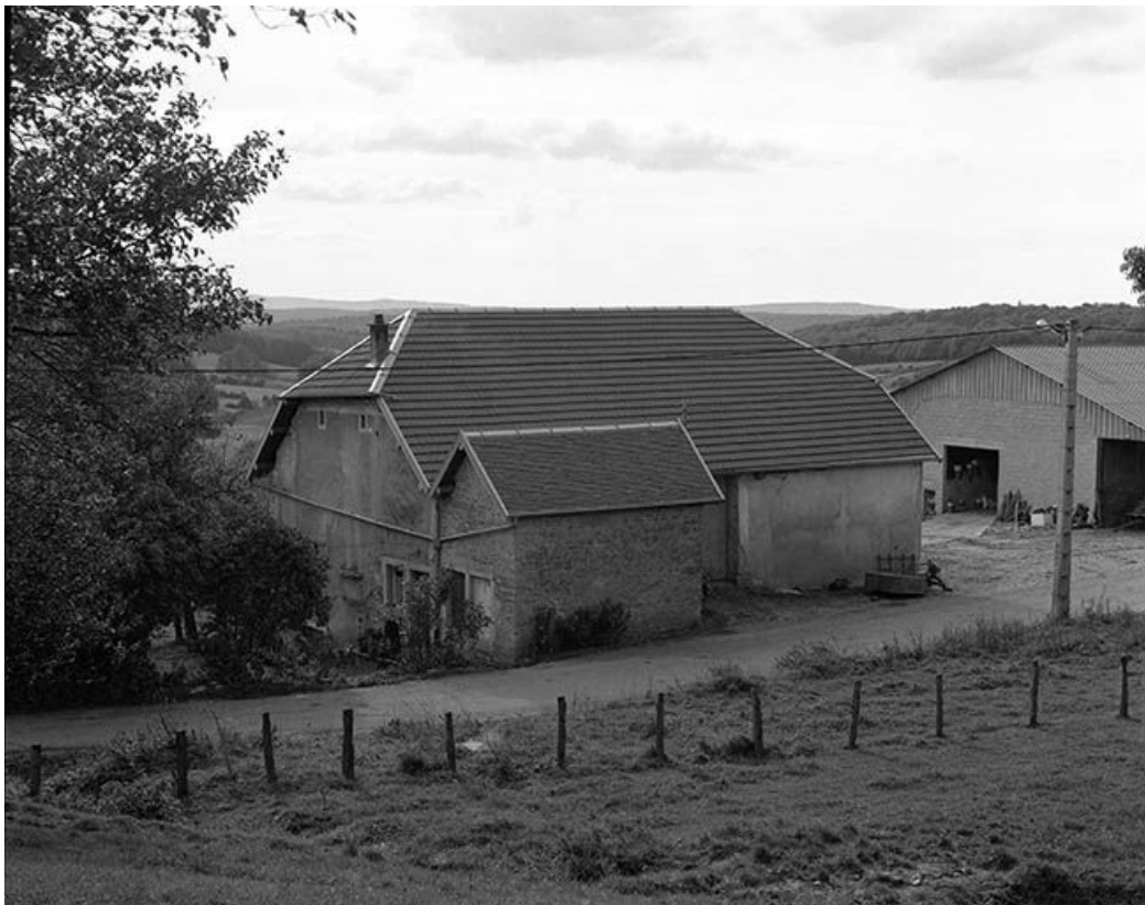
Façade antérieure et face latérale droite. 25, Malbrans
