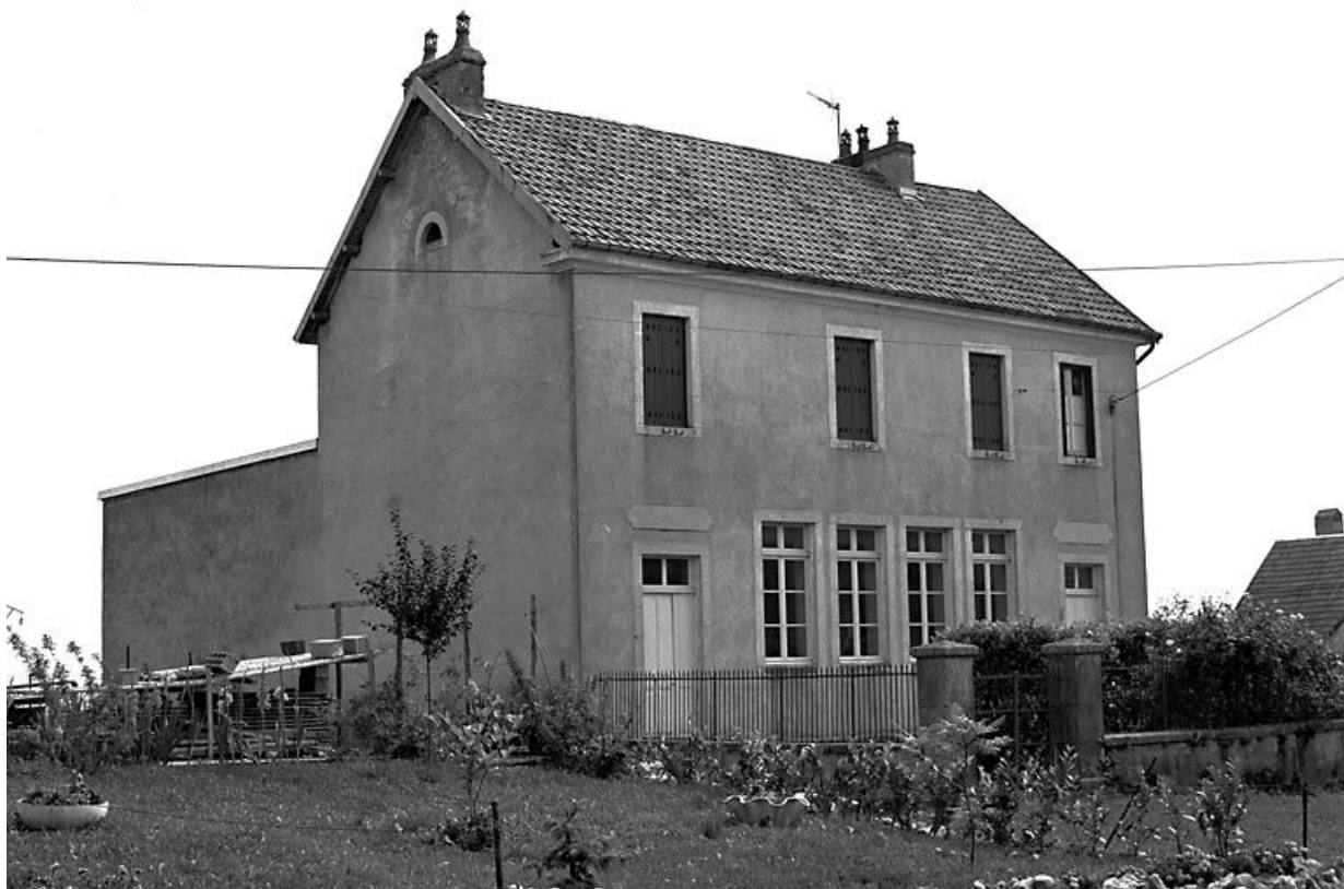
Façade antérieure et face latérale gauche. 25, Malbrans
