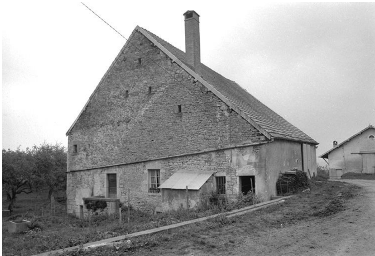
Façade antérieure et face latérale droite. 25, Malbrans
