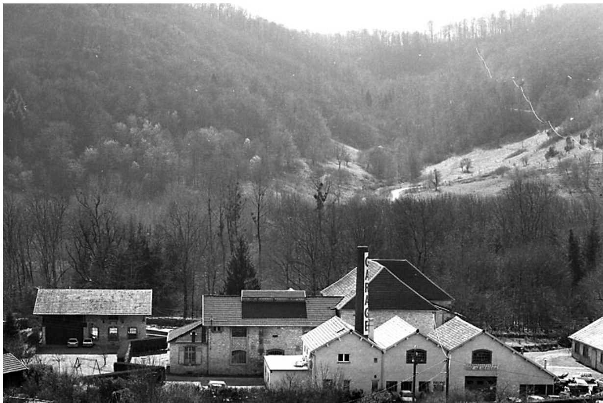
Vue d'ensemble. 25, Montgesoye
