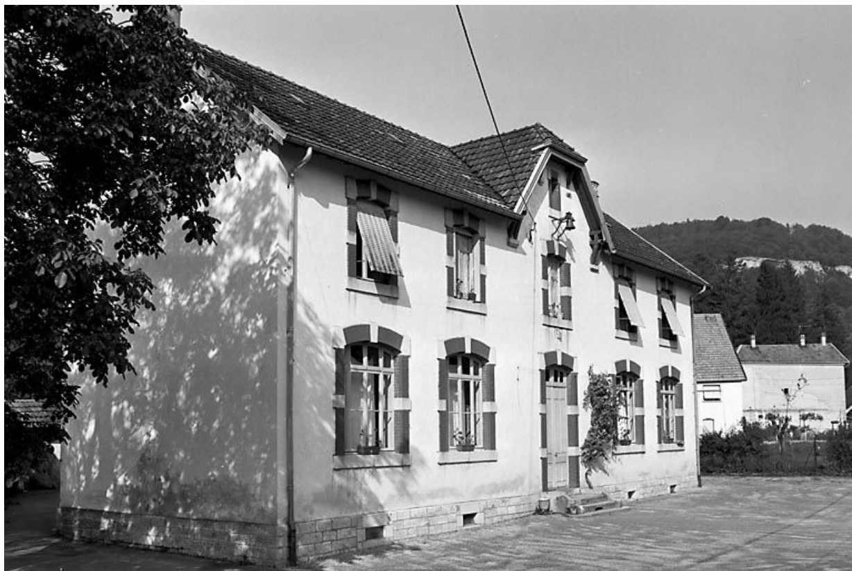
Façade antérieure de trois quarts gauche. 25, Montgesoye
