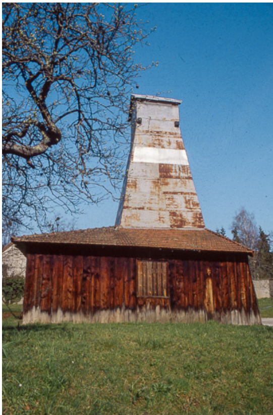
Puits de sondage nord : vue de côté.
