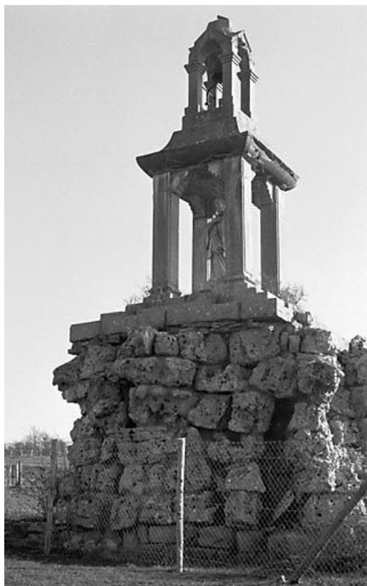
Vue générale. 25, Échevannes
