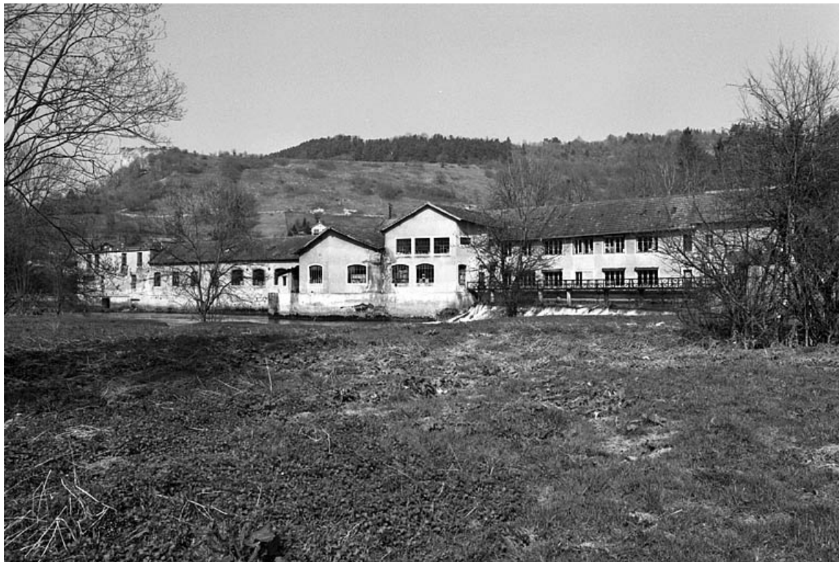
Façade sud de la bonneterie primitive et de l'ancien moulin. 25, Ornans, 1 route de Saules
