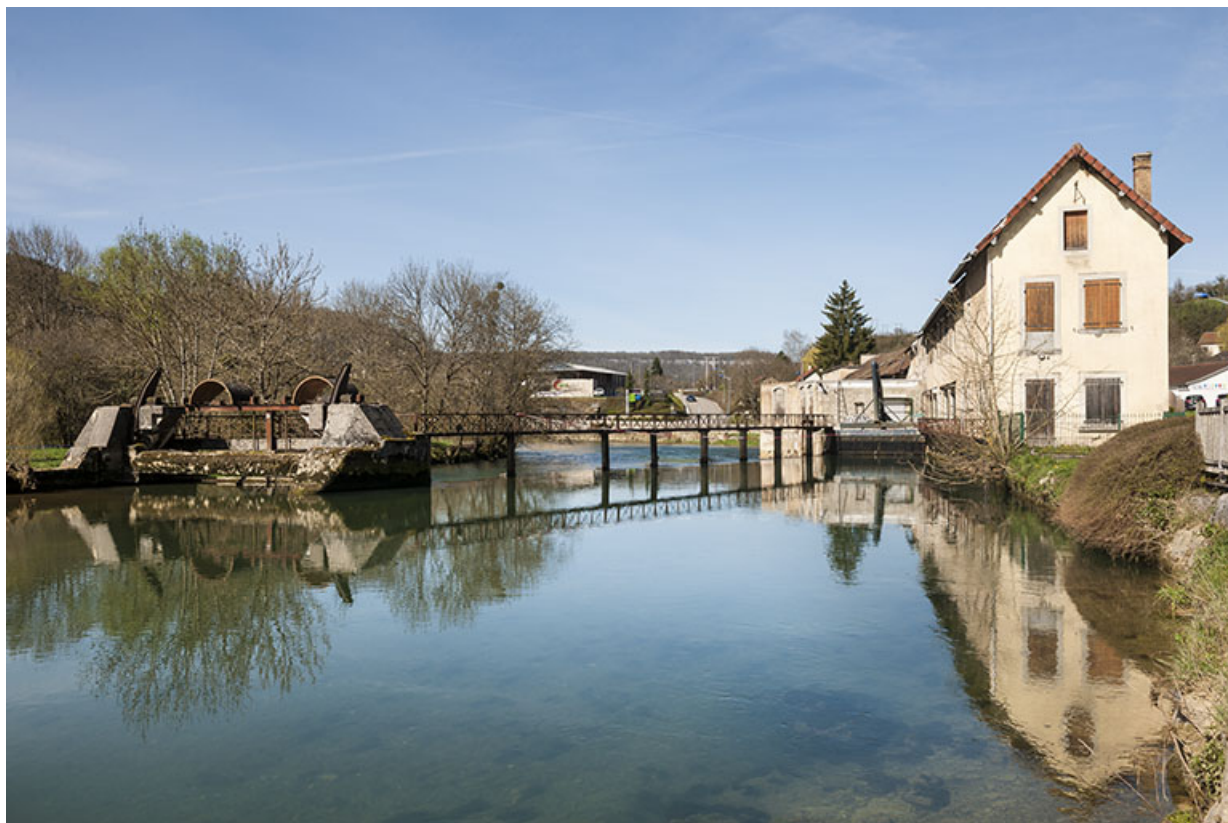
Vue depuis l'amont.
