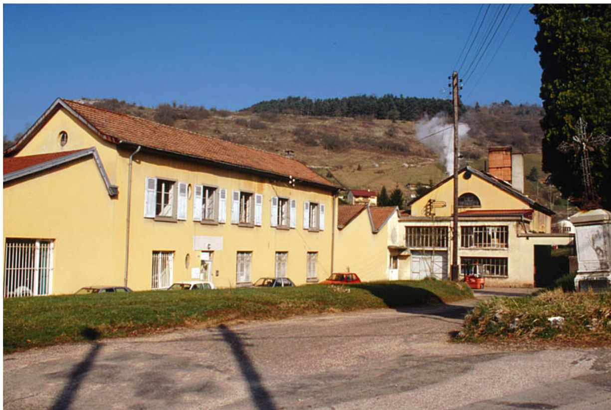
Façade est de la nouvelle usine de bonneterie.
