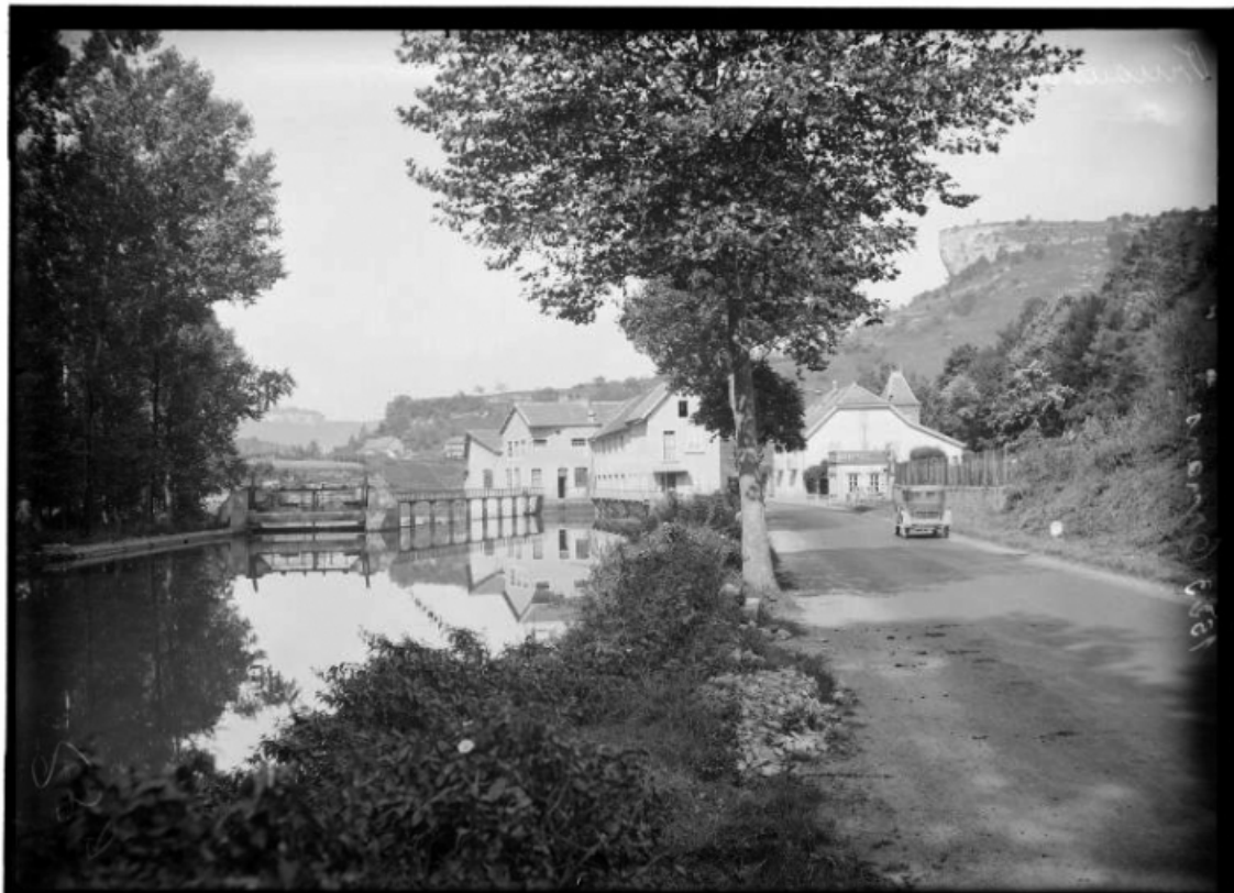
Vue d'ensemble depuis la route de Montgesoye, phot., s.d. [vers 1935]. 25, Ornans, 1 route de Saules
