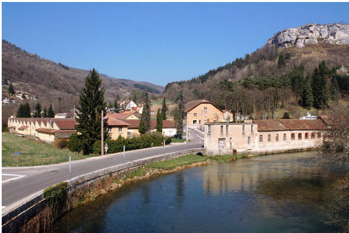
Vue générale depuis le sud. 25, Ornans, 1 route de Saules
