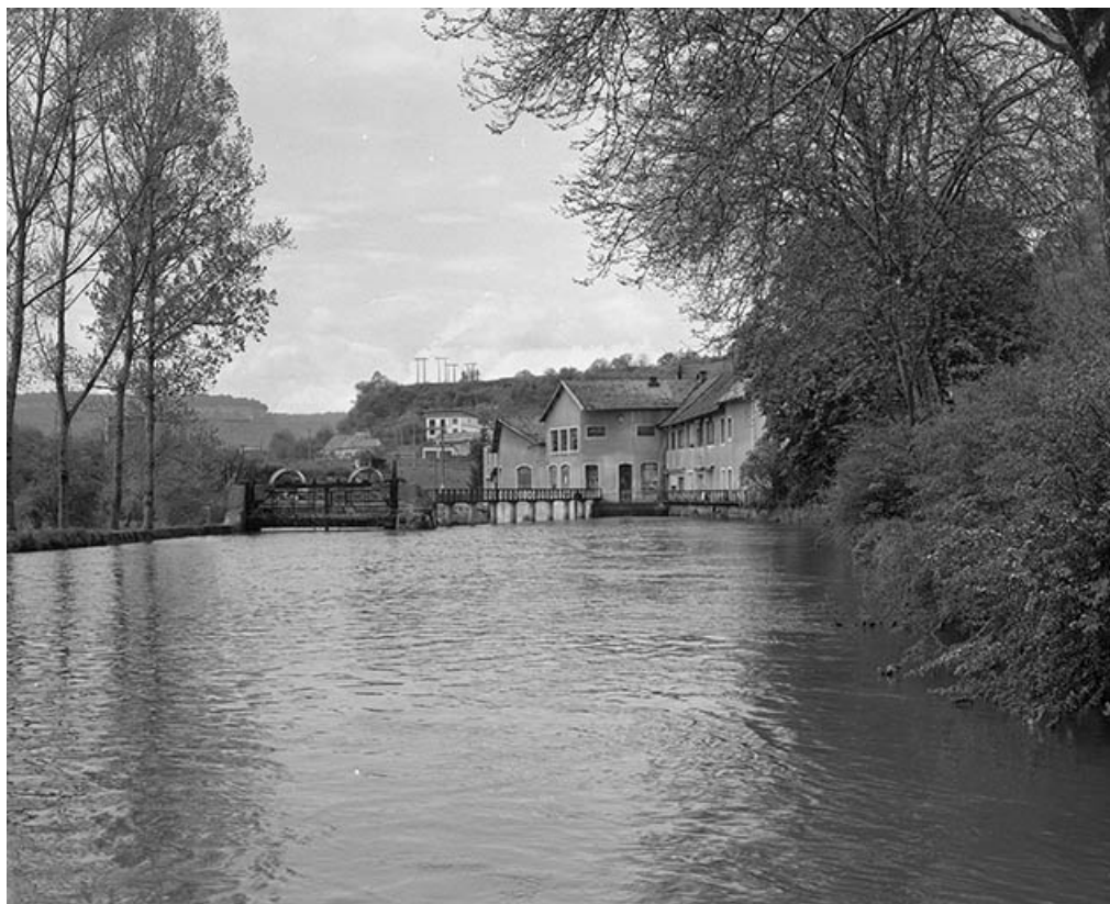
Vue d'ensemble en amont de la Loue en 1977.
