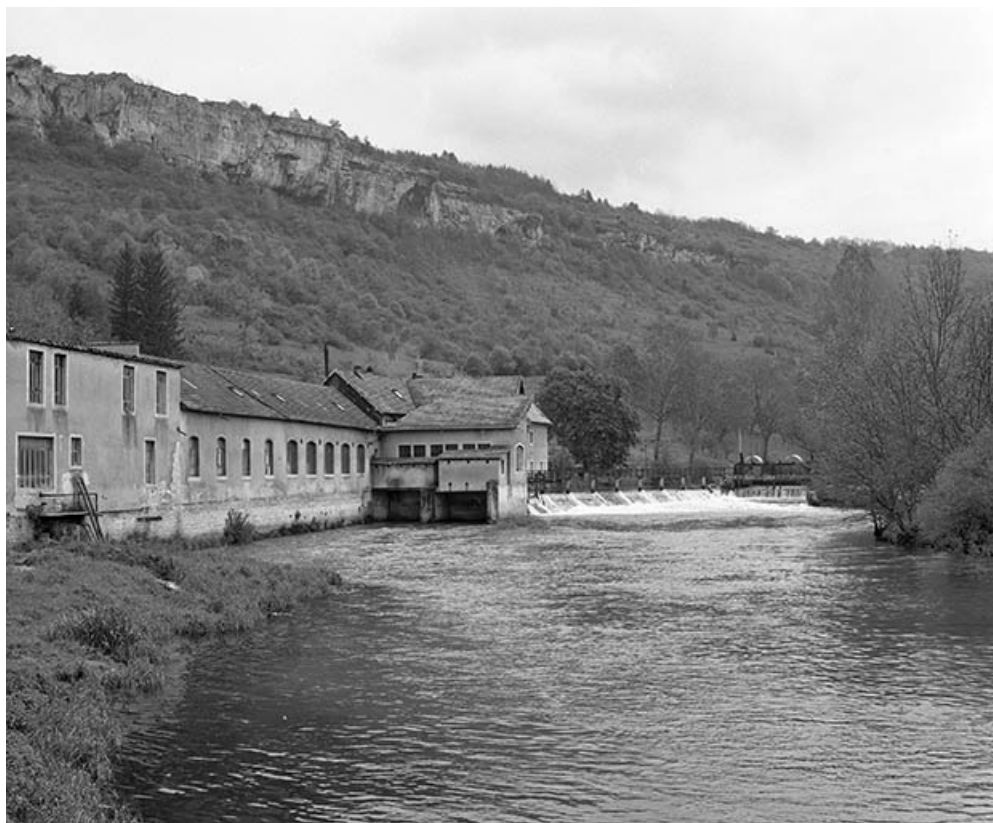
Vue d'ensemble depuis l'ouest en 1977.
