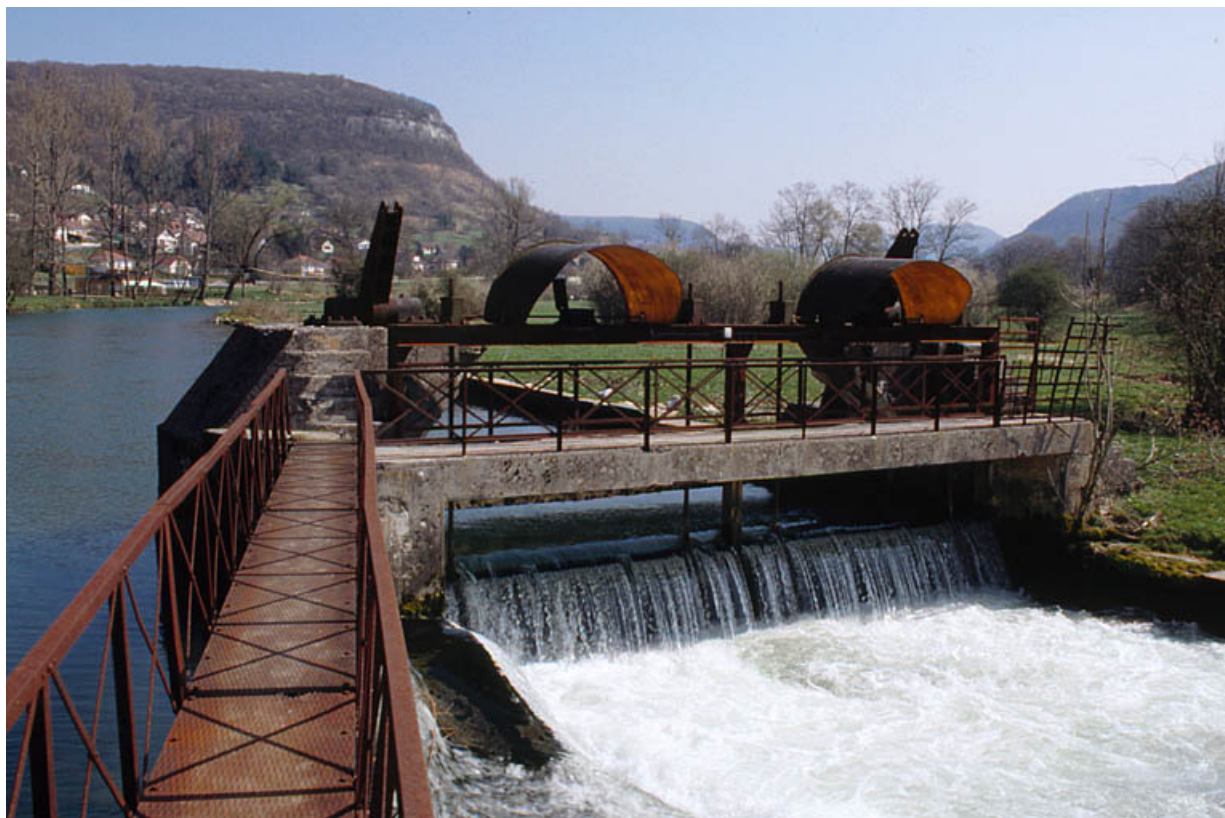
Passerelle et vannage de décharge du barrage.
