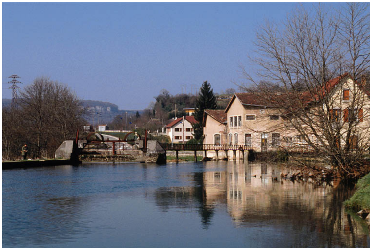
Vue d'ensemble de l'ancien moulin depuis l'est.
