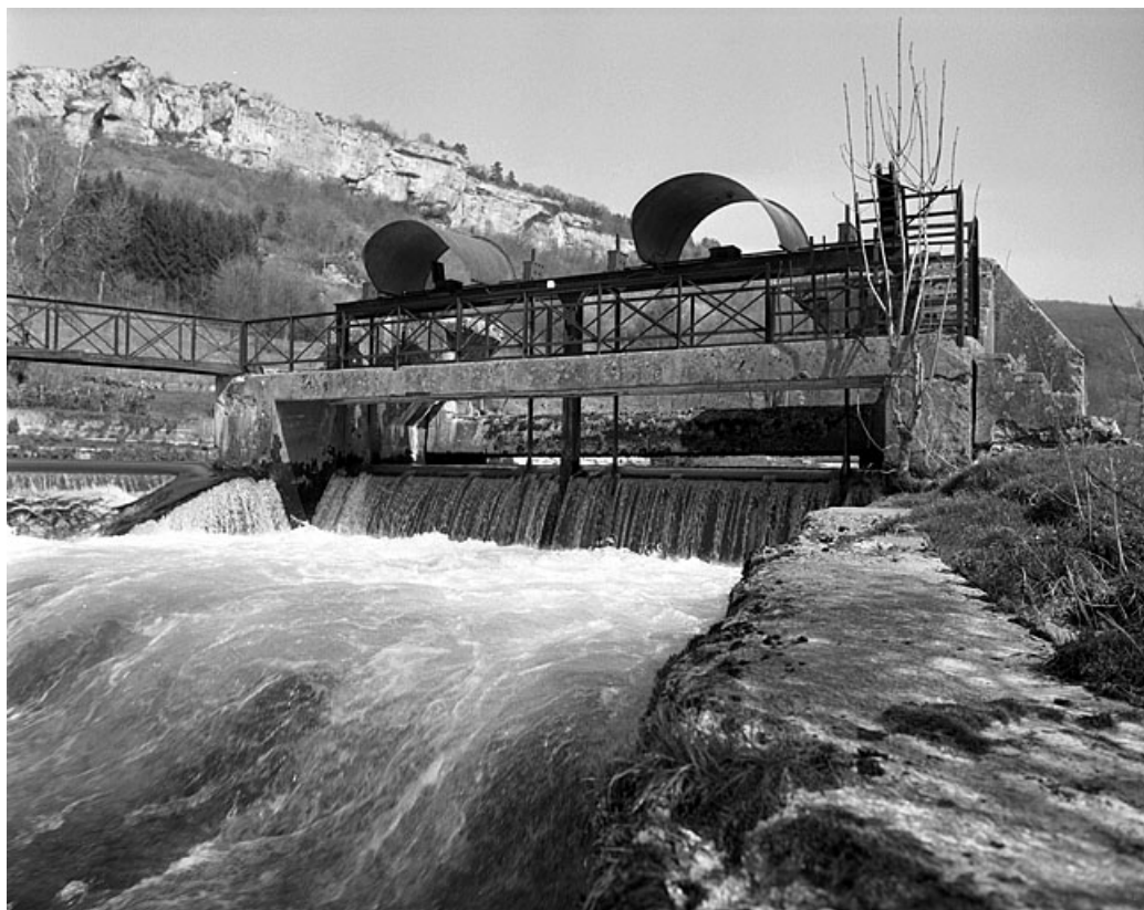
Vannage de décharge du barrage.
