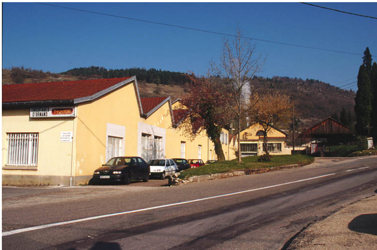
Vue d'ensemble de la nouvelle usine de bonneterie depuis le sud.
