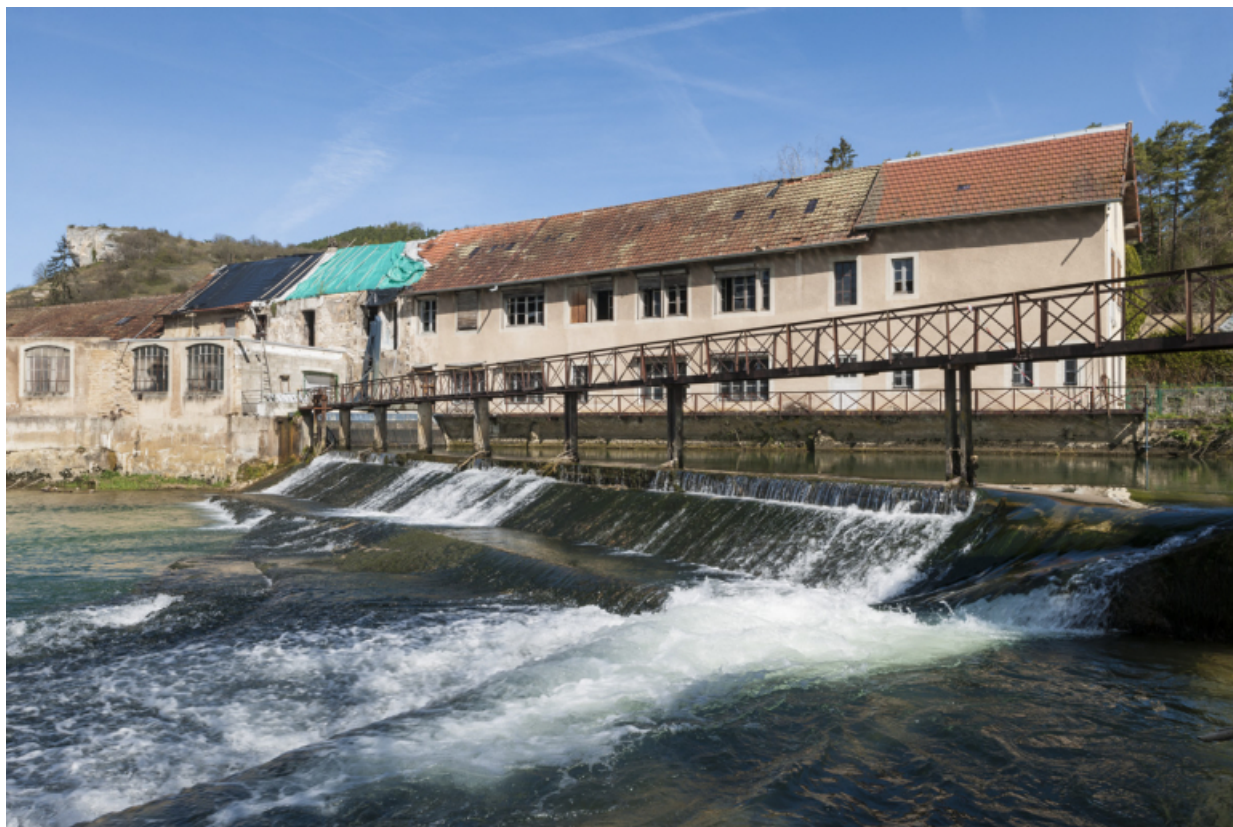
Façades sud des bâtiments du moulin.
