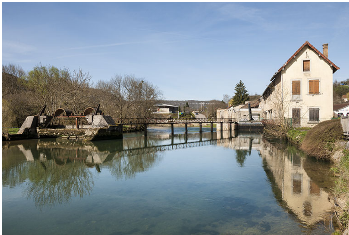
Vue depuis l'amont.
