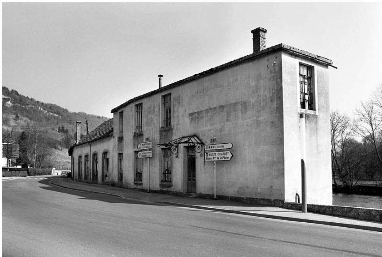
Logement et bureau (?) de l'atelier de bonneterie primitif.
