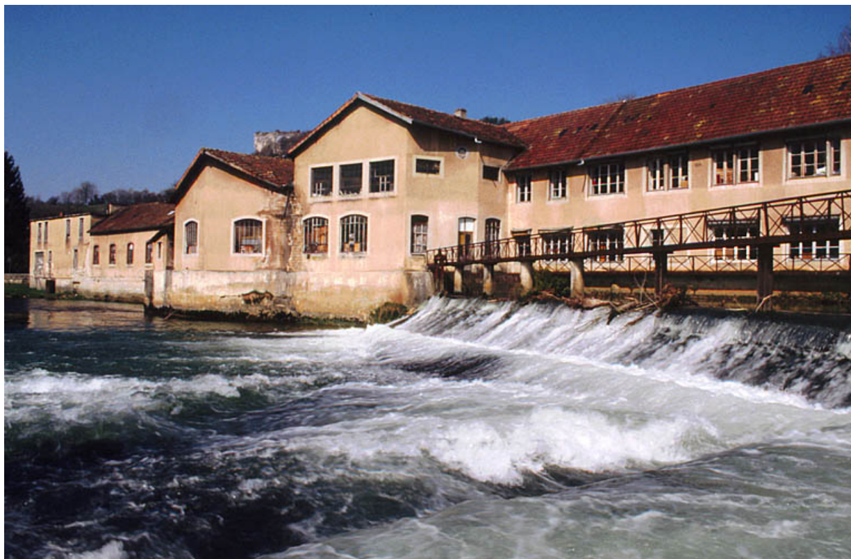
Façade sud de la bonneterie primitive et de l'ancien moulin.
