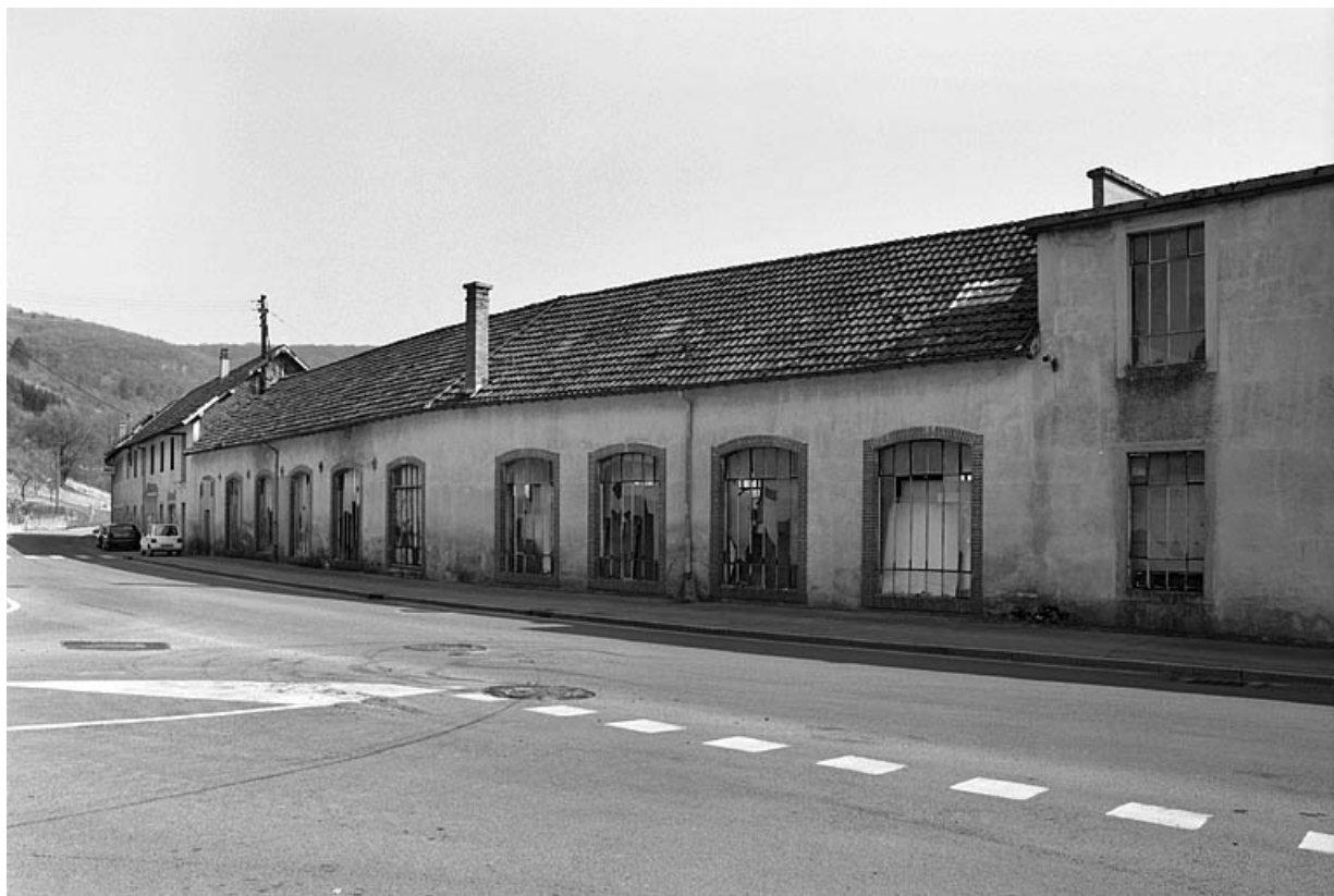
Façade sur rue de l'atelier de bonneterie primitif.
