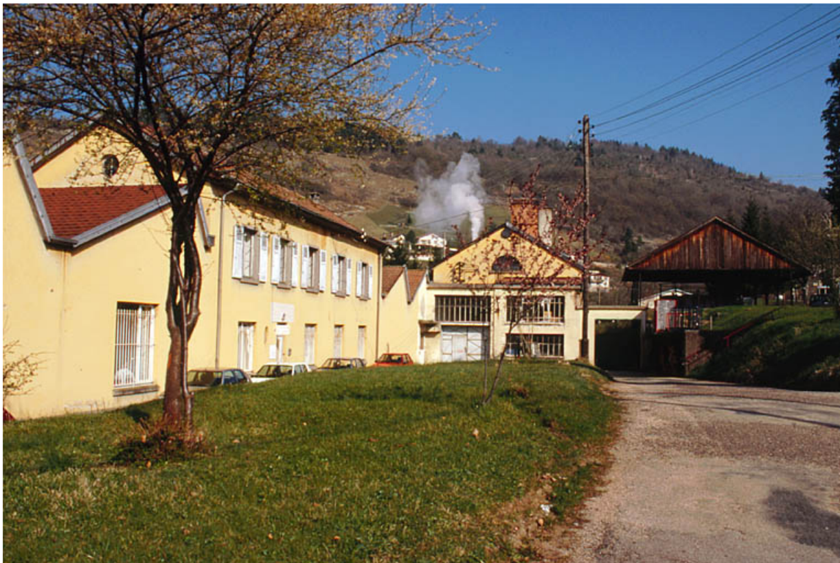
Bureau, boutique et chaufferie de la nouvelle usine de bonneterie. 25, Ornans, 1 route de Saules
