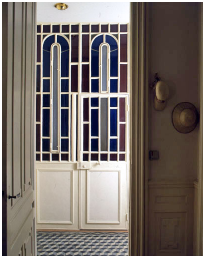
Porte ouvrant sur l'ascenseur au 4ème étage.
