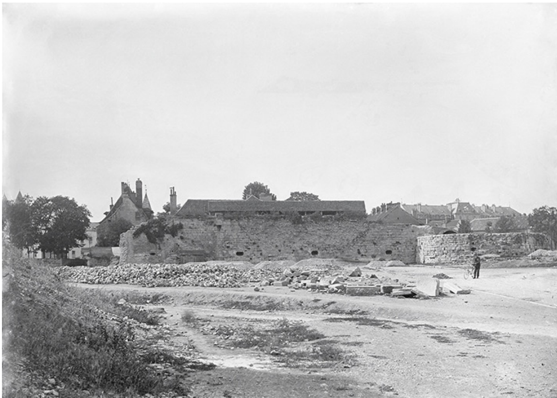
Démolition du château. [1890-1897].
