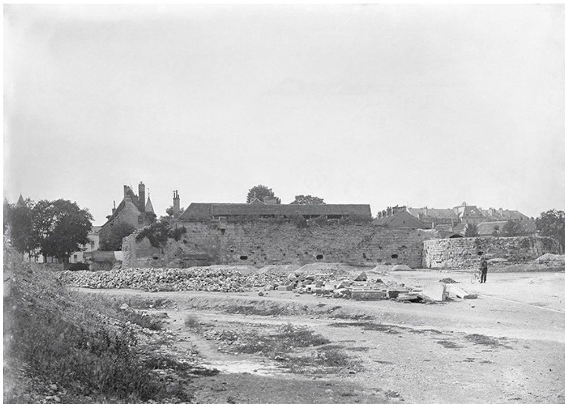
Démolition du château. [1890-1897].
