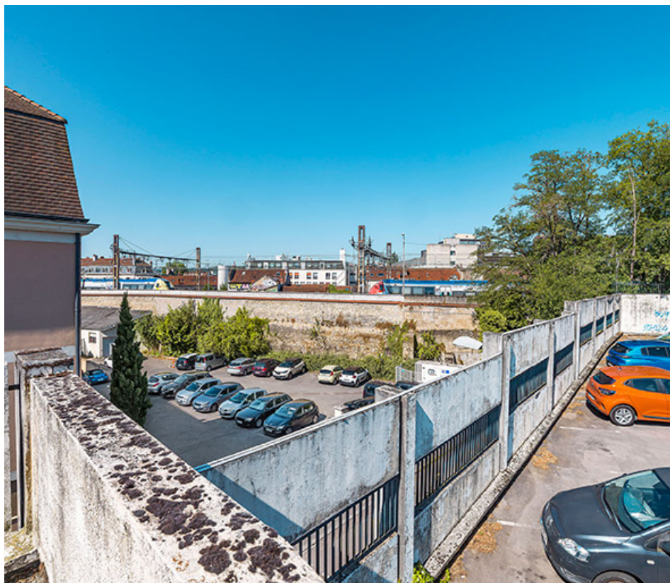
Rempart de la Miséricorde, vu depuis le parking aérien. 21, Dijon
