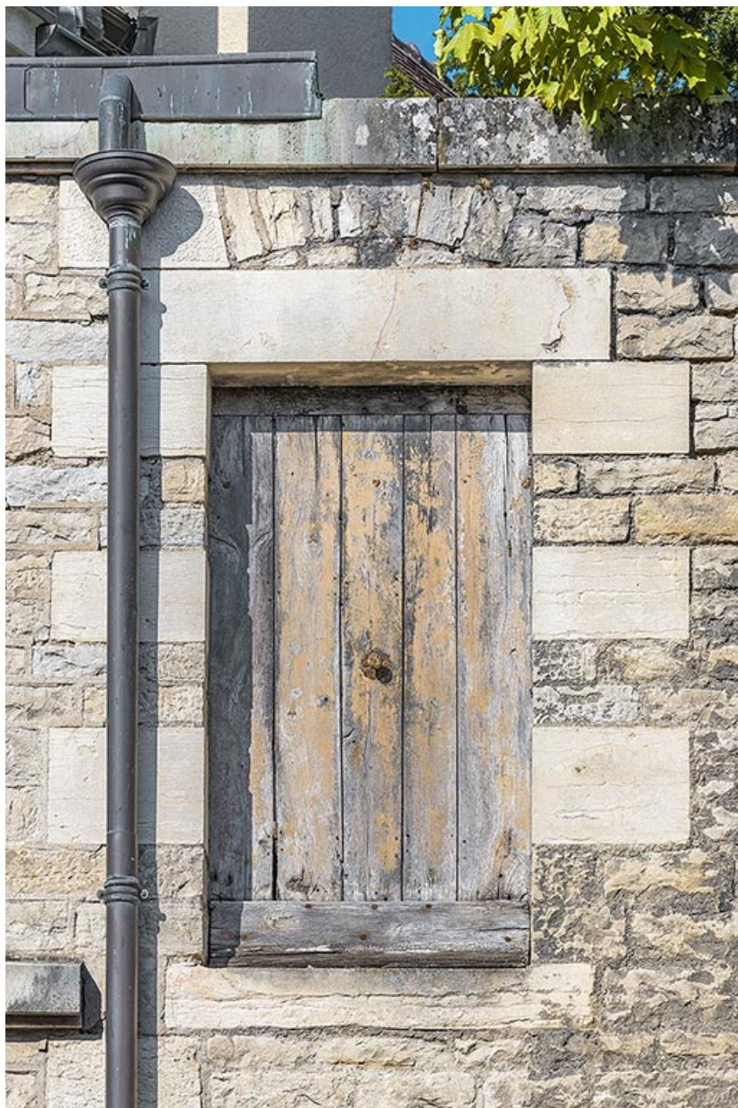
Détail d'une des portes, rue Diderot.
