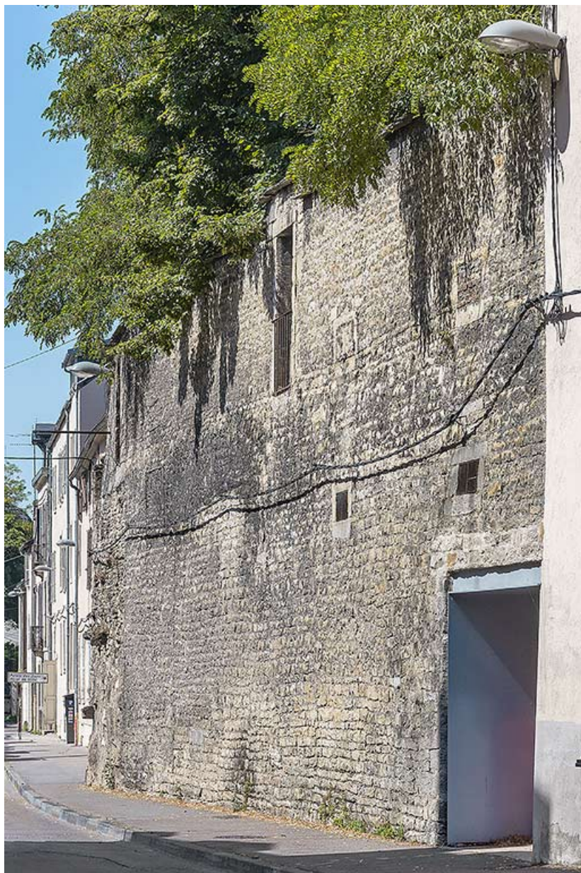
Détail de la maçonnerie du rempart, rue Berlier. 21, Dijon
