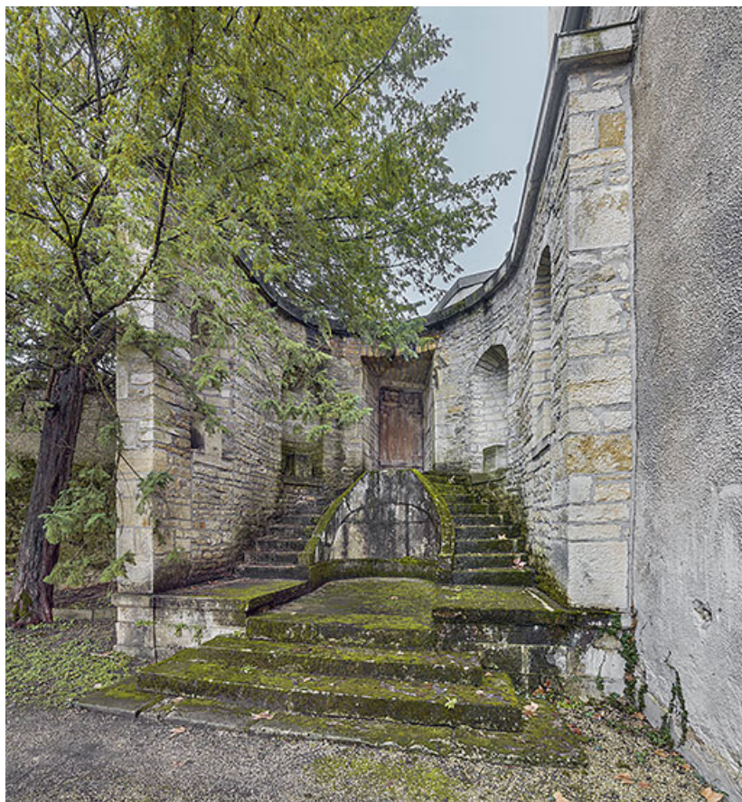
Escalier aménagé pour accéder aux promenades des remparts (accès à la rue Diderot). 21, Dijon
