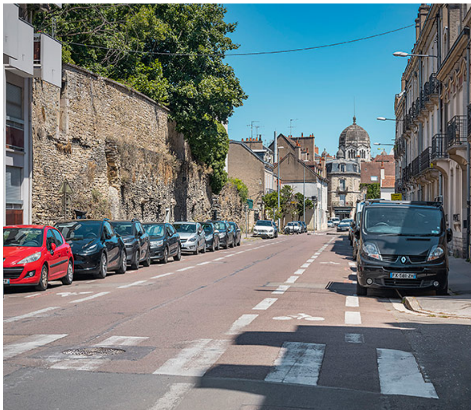
Vue de situation de la muraille, rue de Tivoli. 21, Dijon
