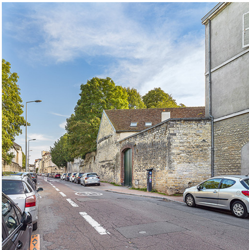
Portion du rempart, rue Diderot. 21, Dijon
