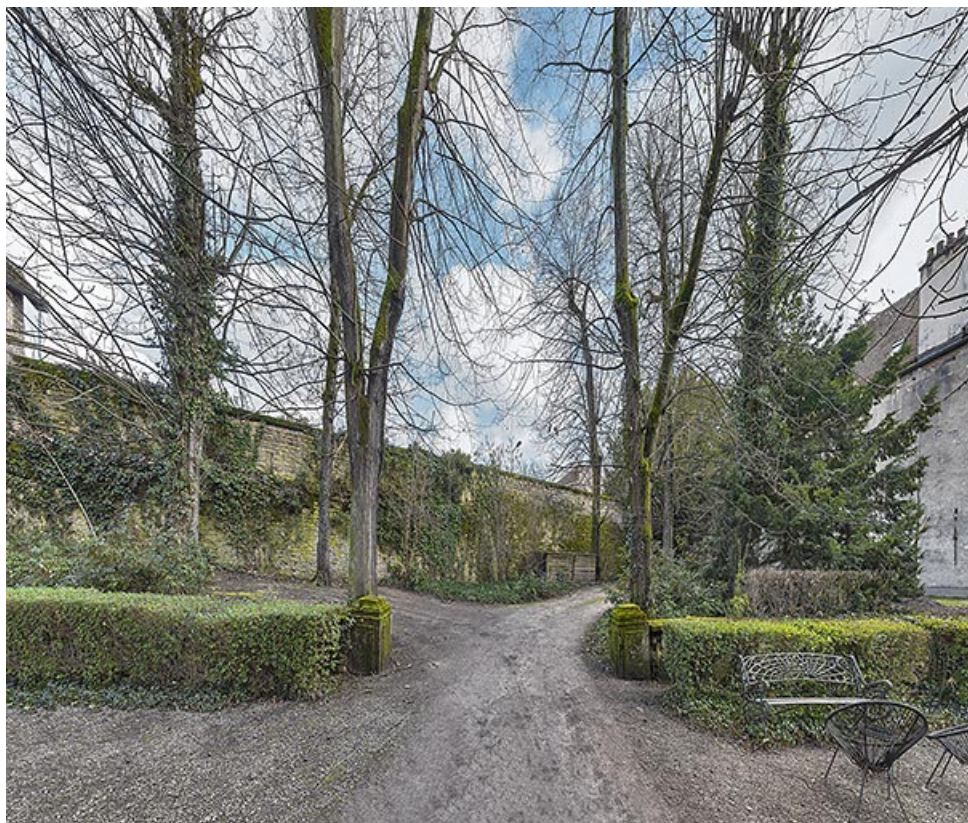
Rempart, vue depuis l'intérieur de l'ancienne enceinte. 21, Dijon
