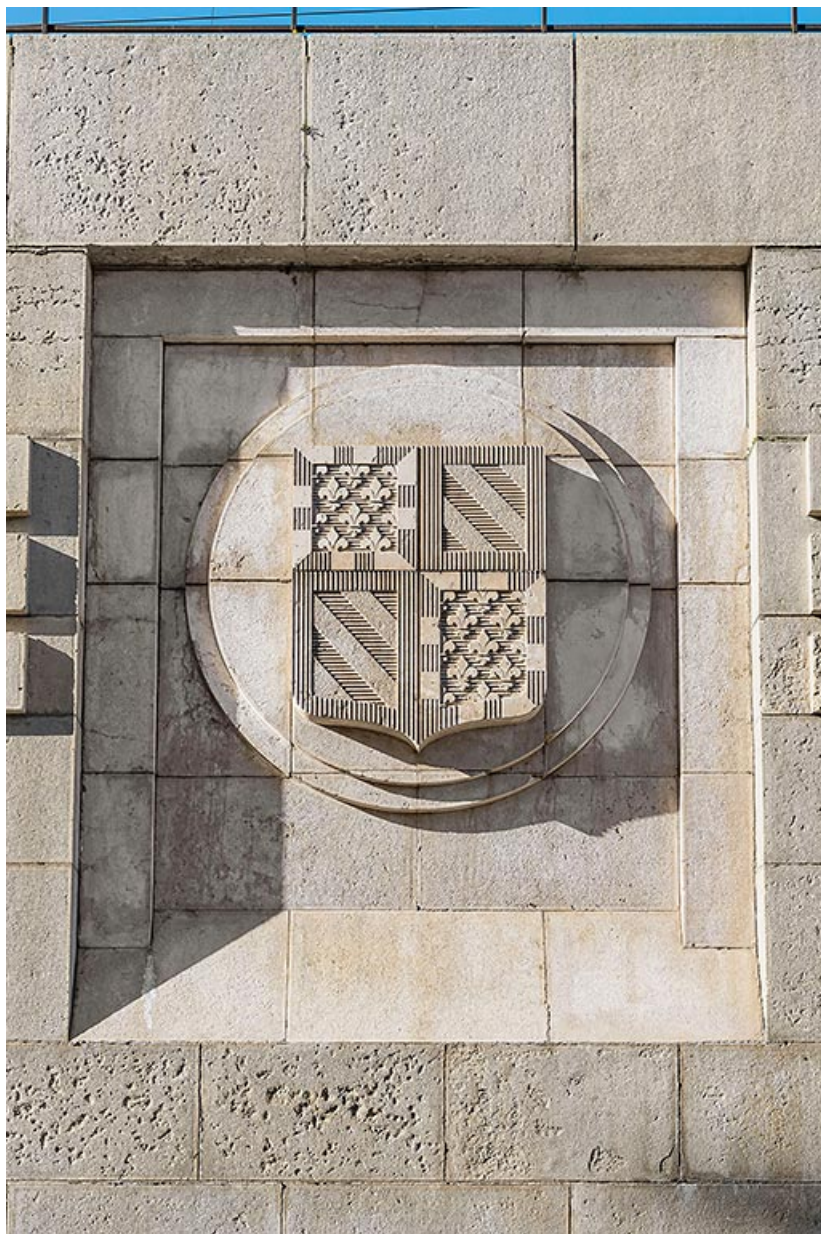
Armoiries de la ville, pont ferroviaire, rue Monge.
