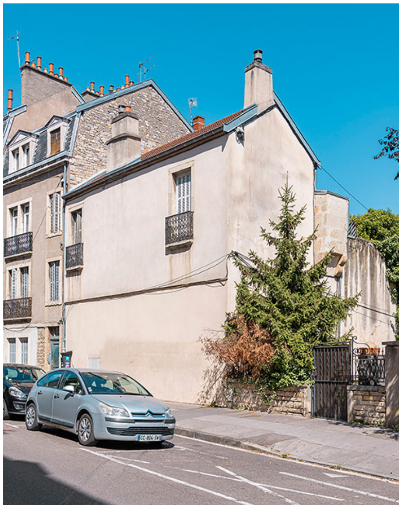
Bâtiment conservant une bretèche, rue Berlier. 21, Dijon
