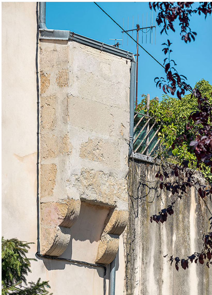
Détail de la bretèche, rue Berlier. 21, Dijon
