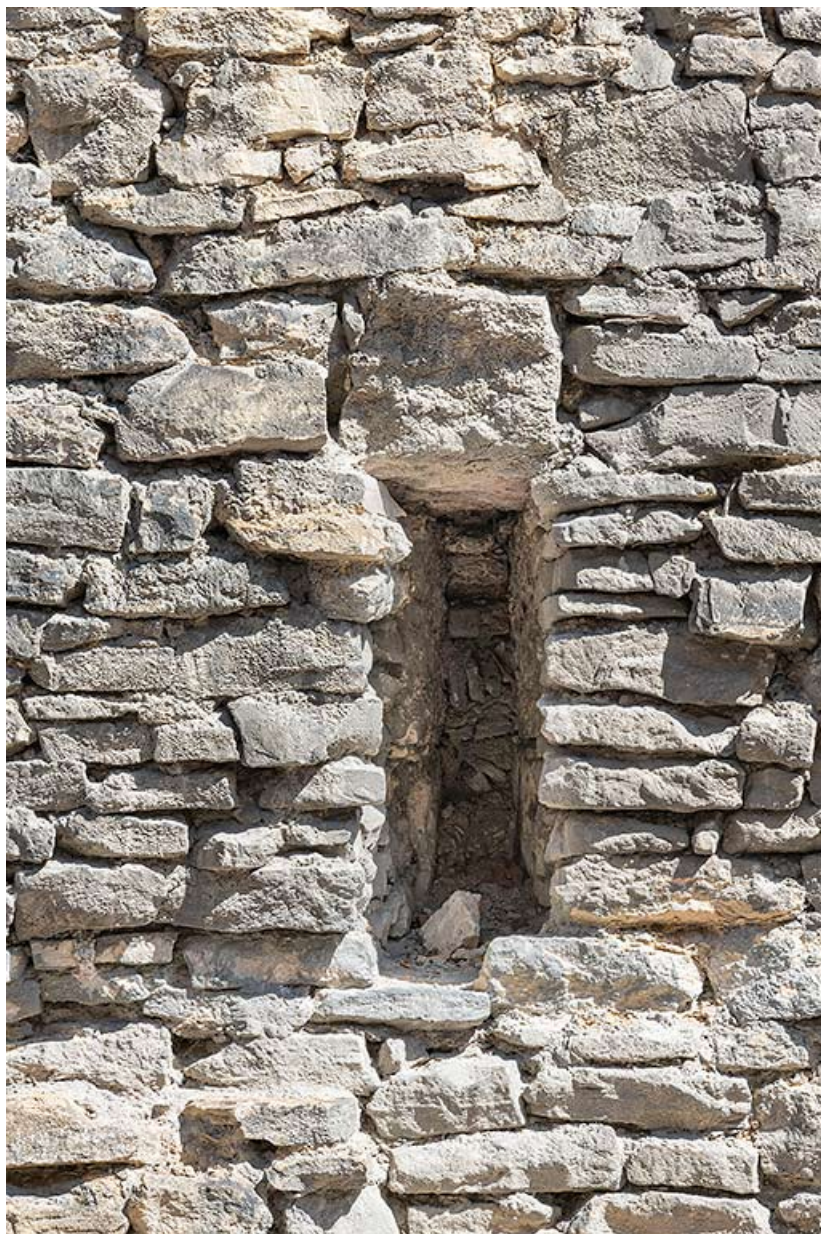
Détail d'une meurtrière, rue de Tivoli. 21, Dijon
