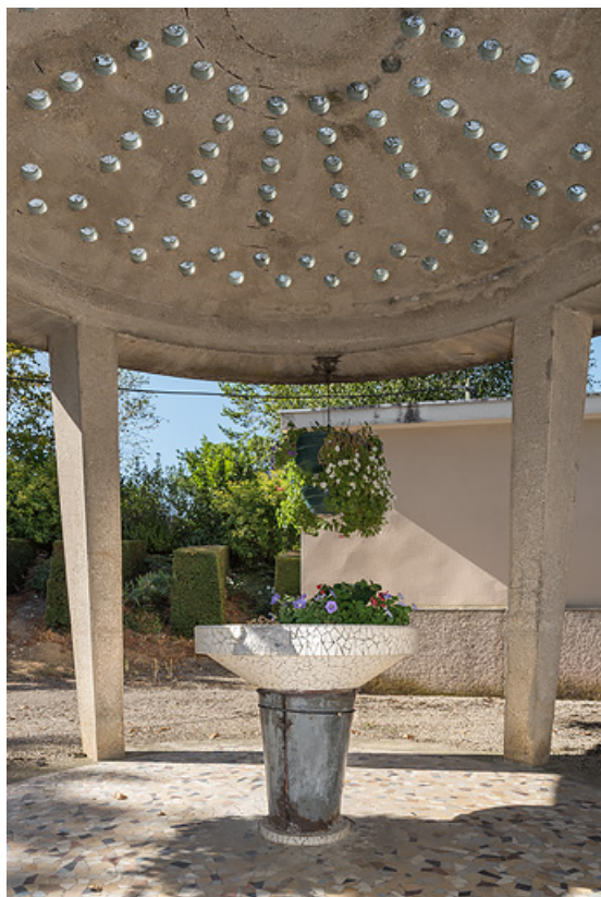
Kiosque de dégustation commun aux sources Lithium et Carnot, état en 2019. 21, Santenay avenue des Sources
