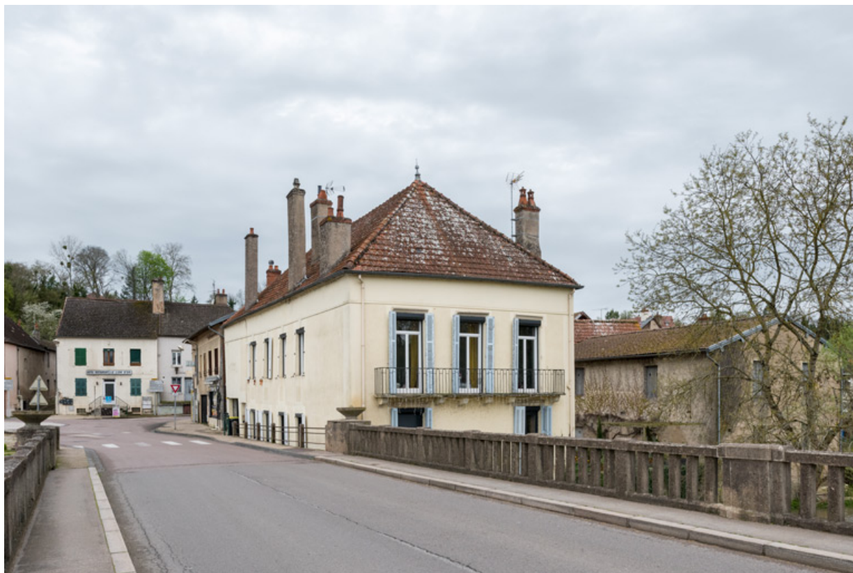
Pontallier-sur-Saône, 62-64 rue du 8 Mai 1945 : le Tivoli.
