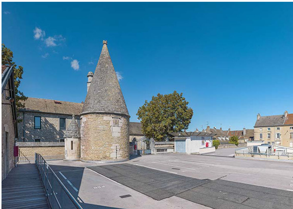
Partie supérieure de la tour. 21, Beaune rempart Madeleine
