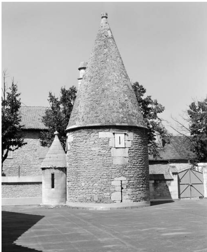
Tour des poudres : partie supérieure depuis la terrasse du magasin Calvet 21, Beaune rempart Madeleine
