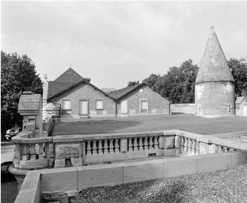
Tour des poudres : partie supérieure depuis la terrasse du magasin Calvet 21, Beaune rempart Madeleine
