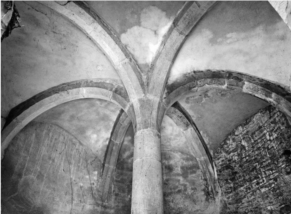
Tour Blondeau, casemate inférieure, détail : voûtement 21, Beaune rempart de la Comédie
