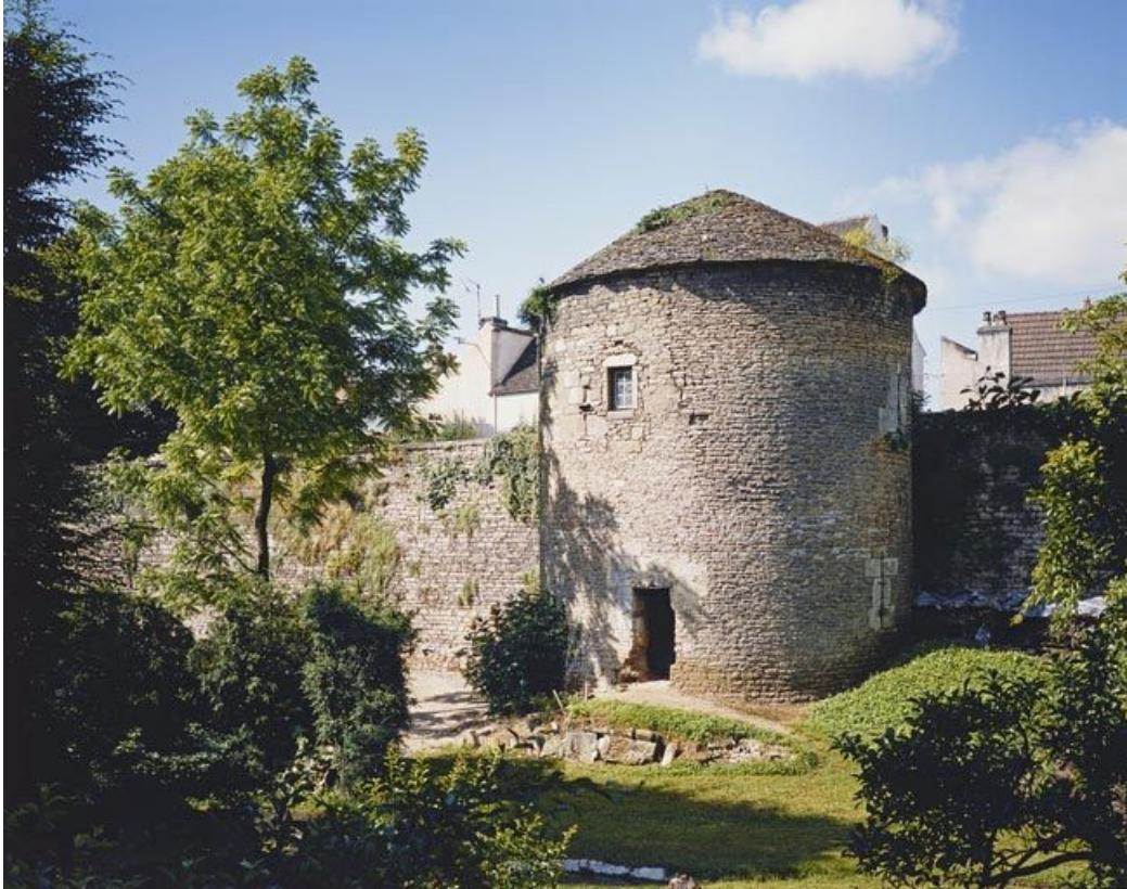
Tour Blondeau depuis le fossé 21, Beaune rempart de la Comédie
