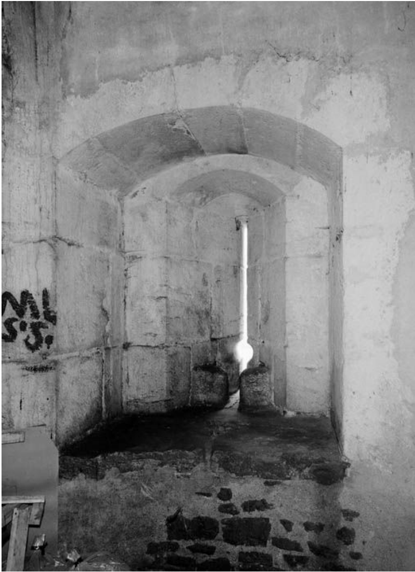
Tour Blondeau, casemate inférieure, détail : archère canonnière (vue intérieure) 21, Beaune rempart de la Comédie
