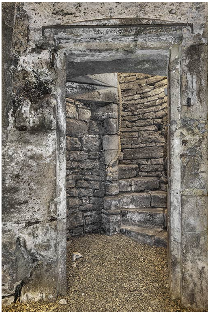
Première volée de l'escalier en vis.
