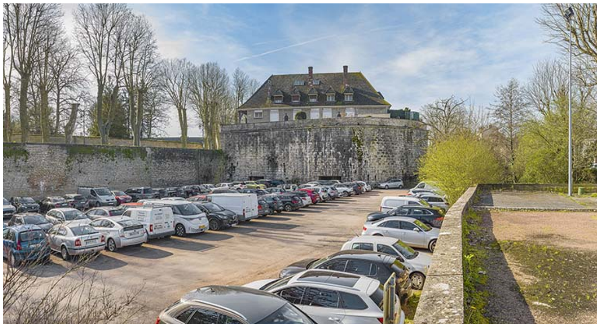
La tour depuis l'ancien fossé.
