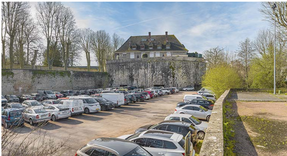
La tour depuis l'ancien fossé.
