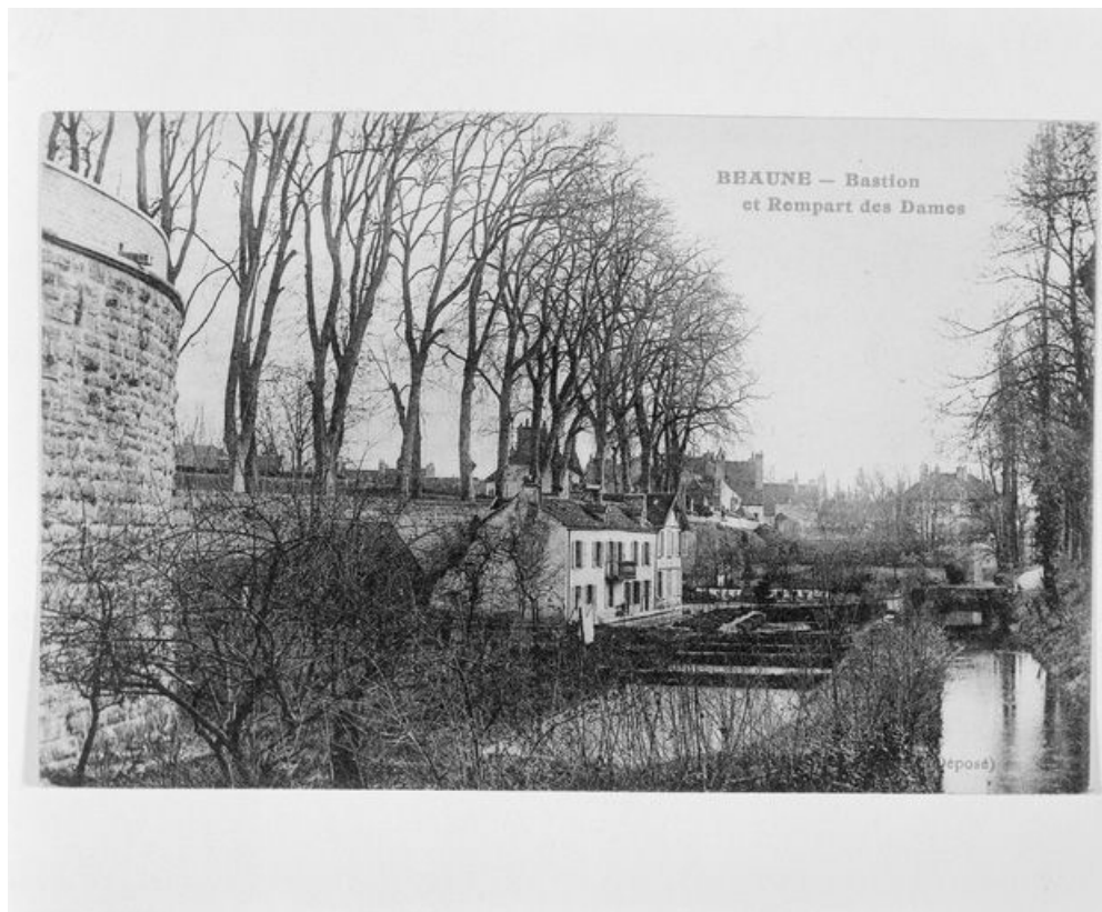
Beaune-Bastion et Rempart des Dames. S.d. 21, Beaune boulevard Clémenceau
