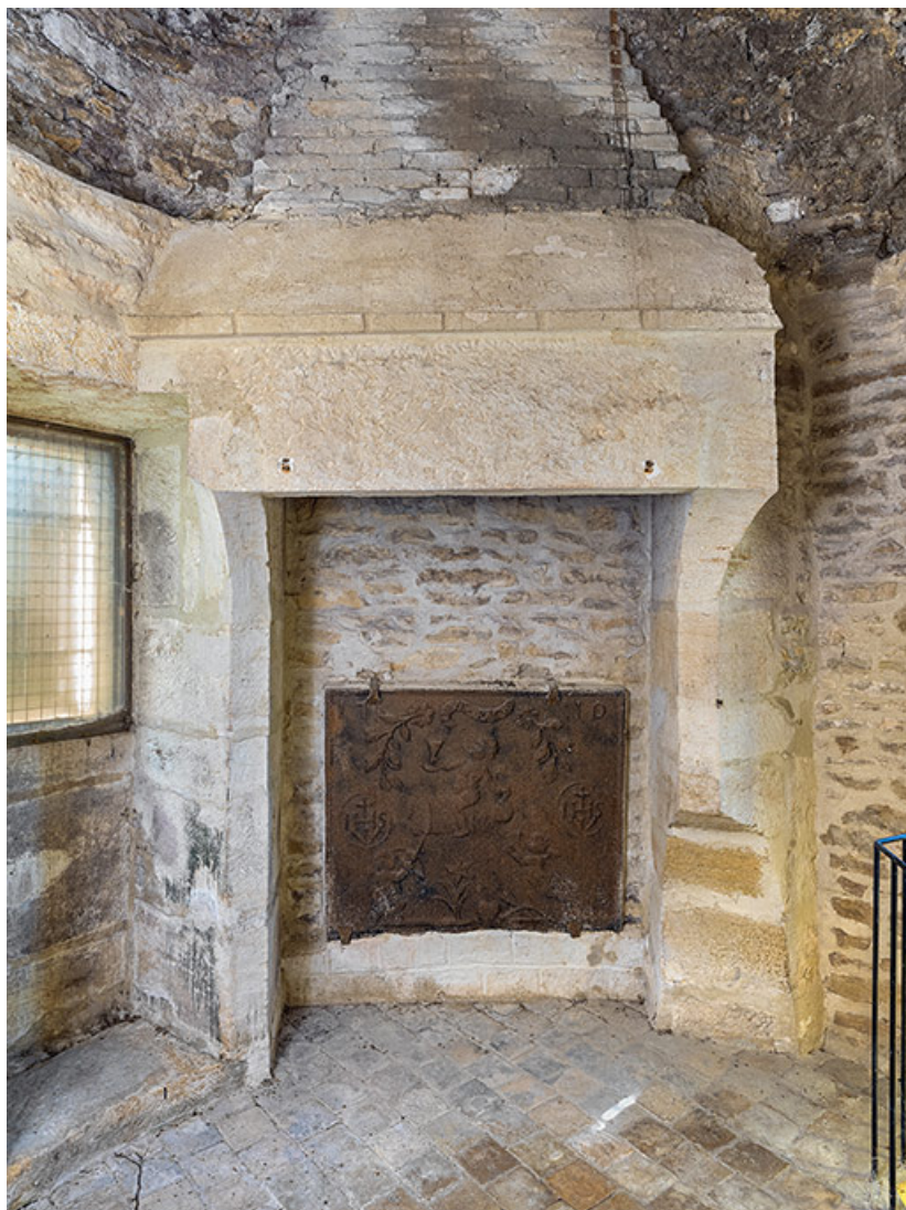
Cheminée de l'étage supérieur.
