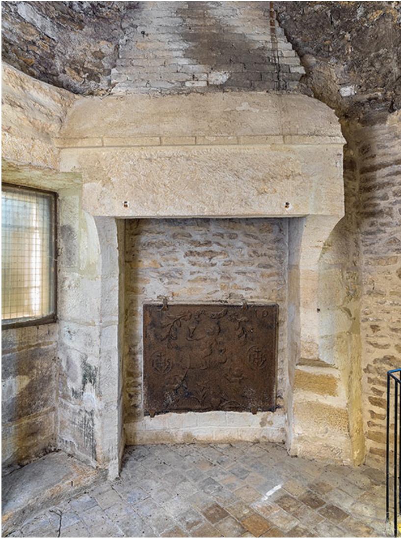
Cheminée de l'étage supérieur.
