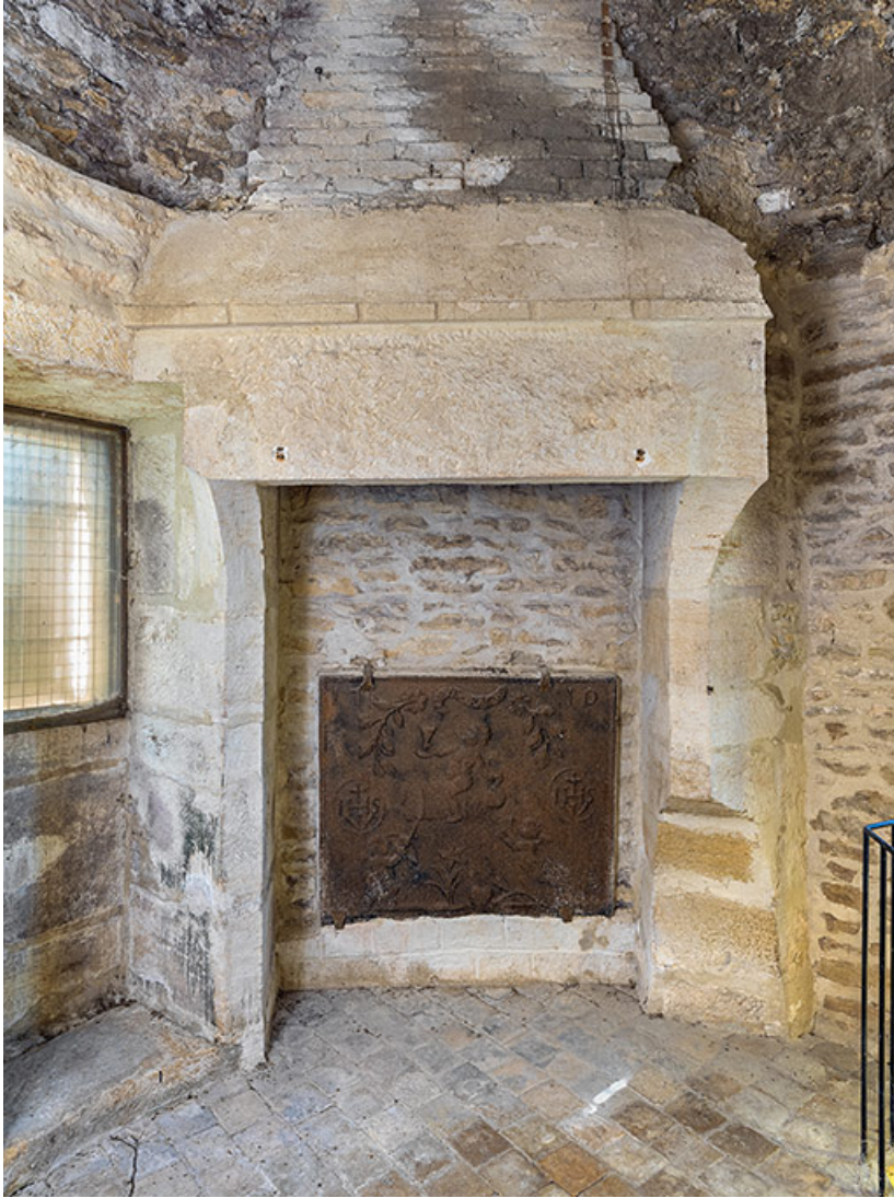
Cheminée de l'étage supérieur.
