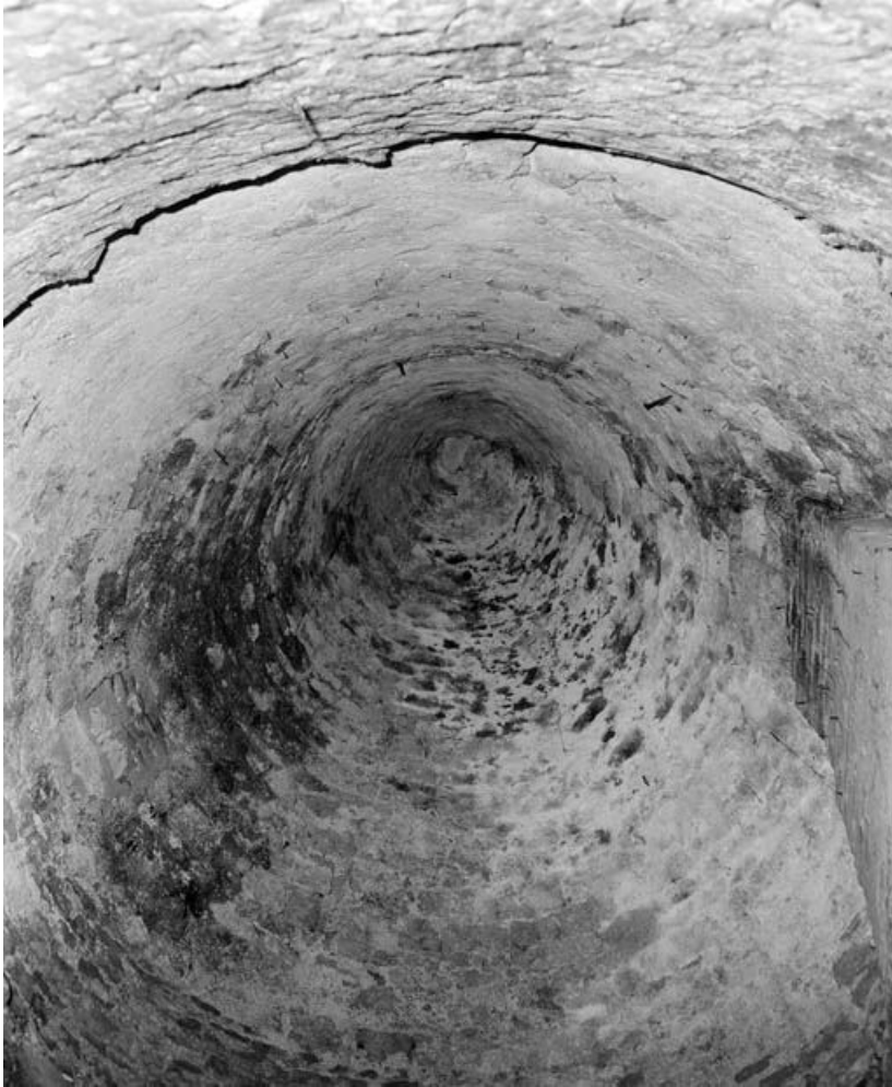
Tour des billes incluse dans la "Grosse Tour", appelée aussi bastion Calvet, détail : vue intérieure de la flèche 21, Beaune rempart Madeleine
