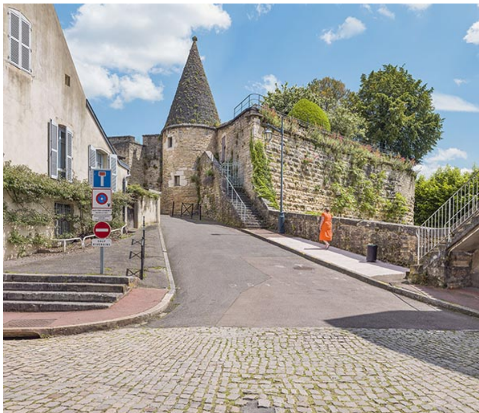
Vue depuis la rue Poterne.
