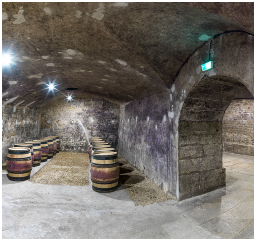
Caves, rez-de-chaussée : voûte en arc segmentaire.
