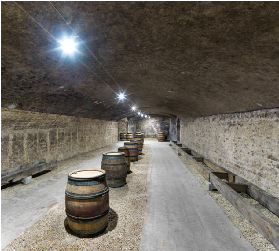
Caves, rez-de-chaussée : vaisseau central.
