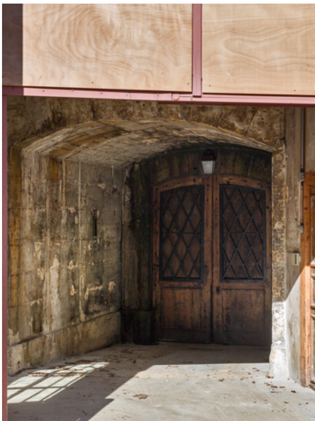
Entrée de la tour au rez-de-chaussée.
