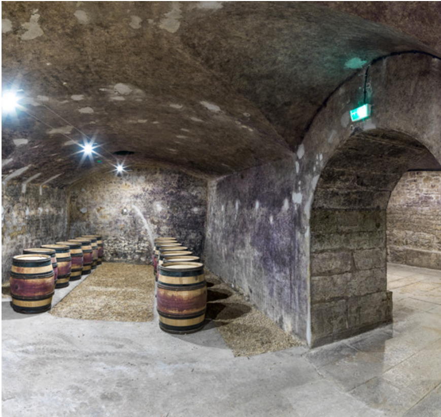
Caves, rez-de-chaussée : voûte en arc segmentaire.
