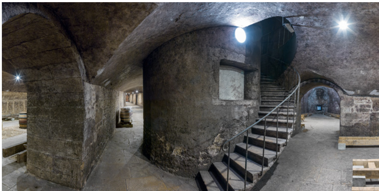
Caves, rez-de-chaussée : vue générale avec le monte-charge au centre.
