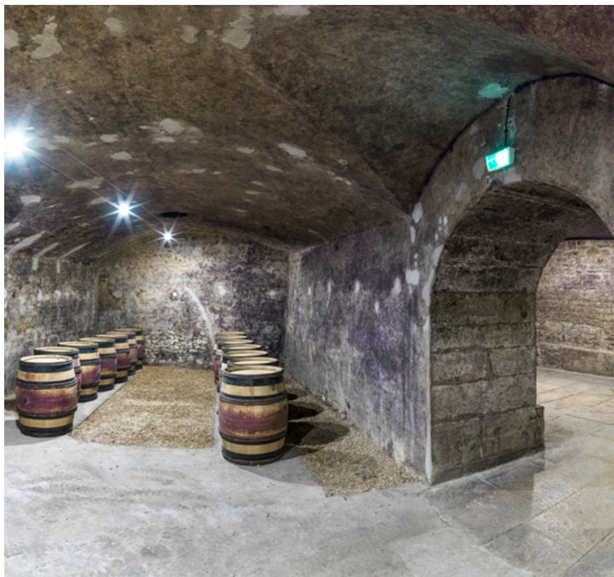
Caves, rez-de-chaussée : voûte en arc segmentaire.
