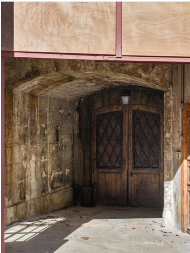
Entrée de la tour au rez-de-chaussée.
