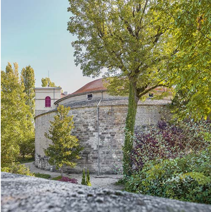
Vue depuis le boulevard du Maréchal Foch. 21, Beaune
