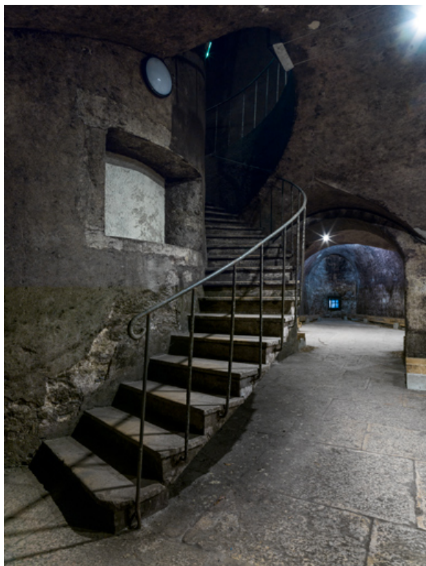
Caves, rez-de-chaussée : le monte-charge avec l'escalier tournant.
