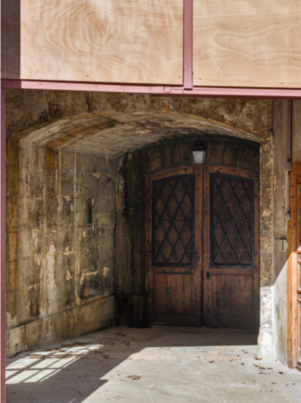
Entrée de la tour au rez-de-chaussée.
