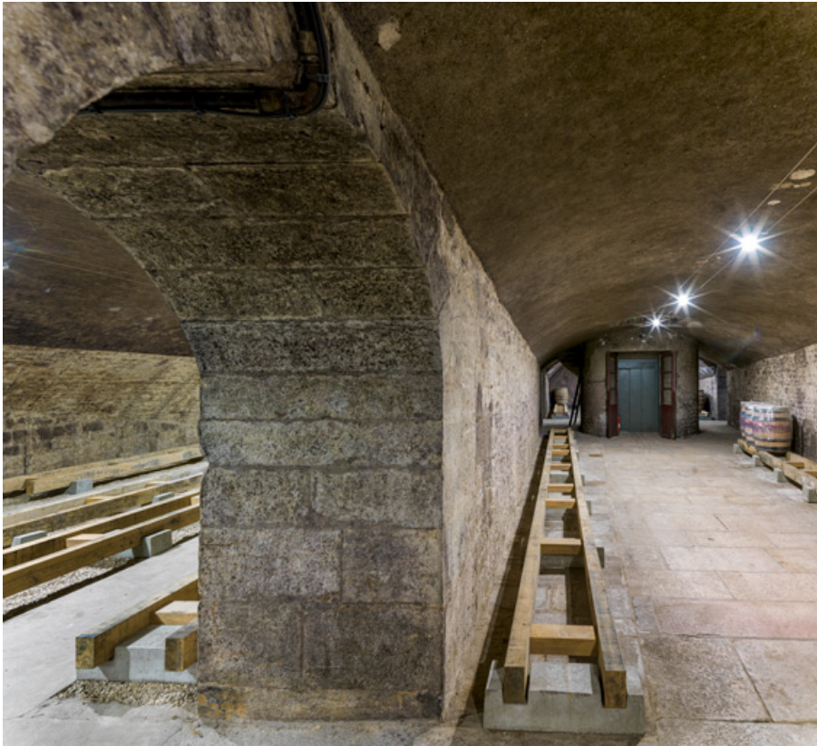
Caves, rez-de-chaussée : mur de refend entre deux vaisseaux.
