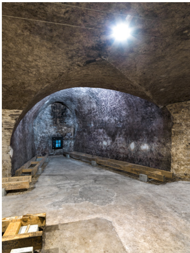
Caves, rez-de-chaussée : niche d'une embrasure.
