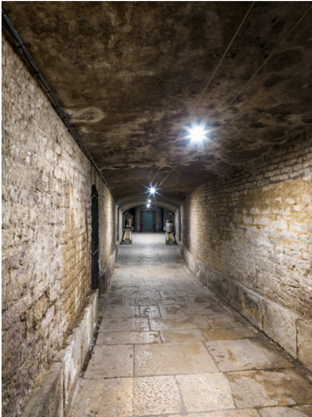
Galerie menant vers les caves, rez-de-chaussée.
