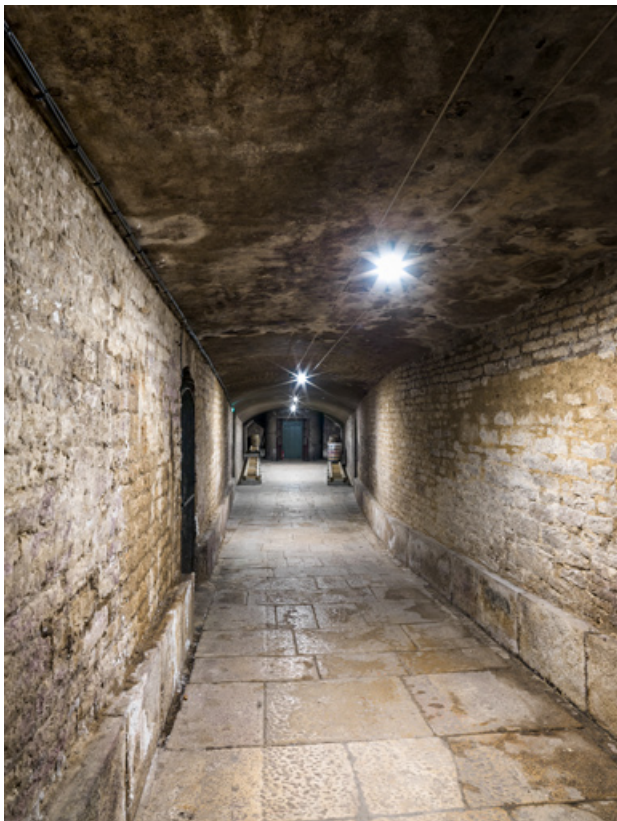
Galerie menant vers les caves, rez-de-chaussée.
