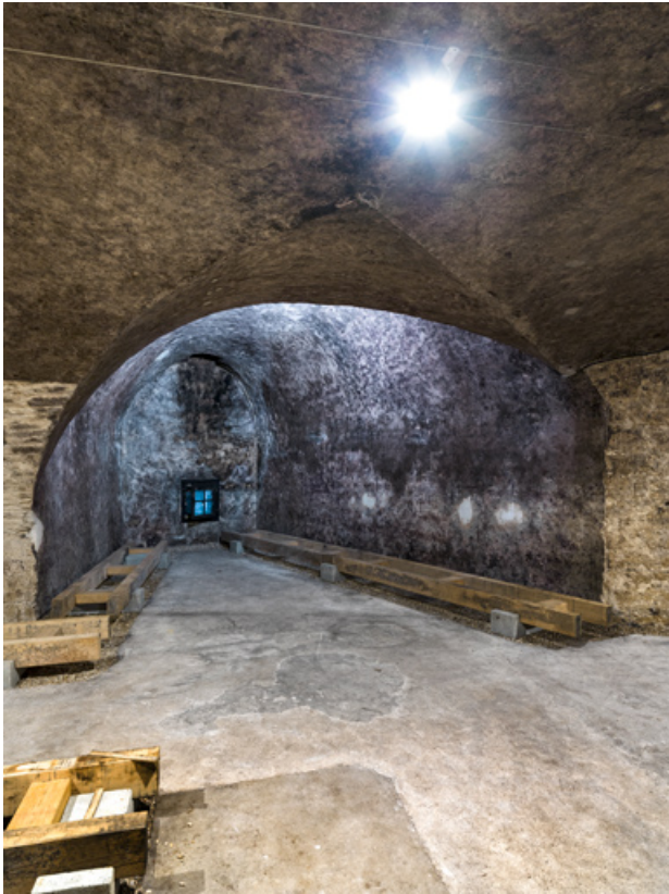
Caves, rez-de-chaussée : niche d'une embrasure.
