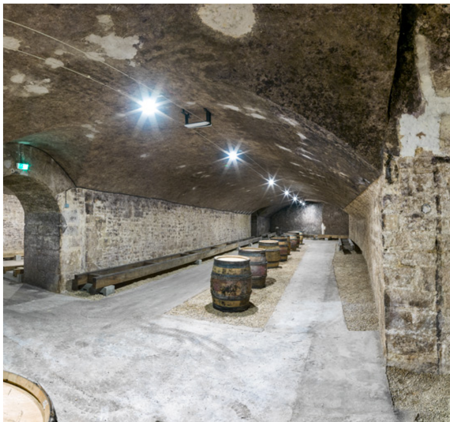
Caves, rez-de-chaussée : vue générale.
