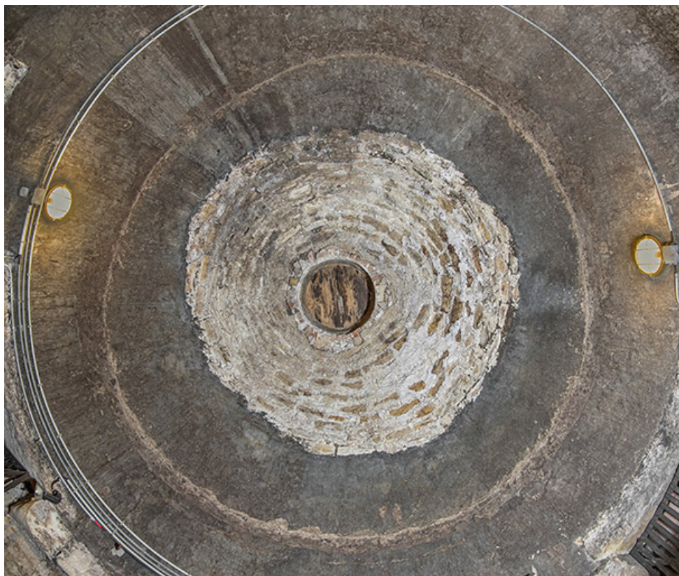
La tour des Cordeliers : plafond (ou couverture) du niveau inférieur.
