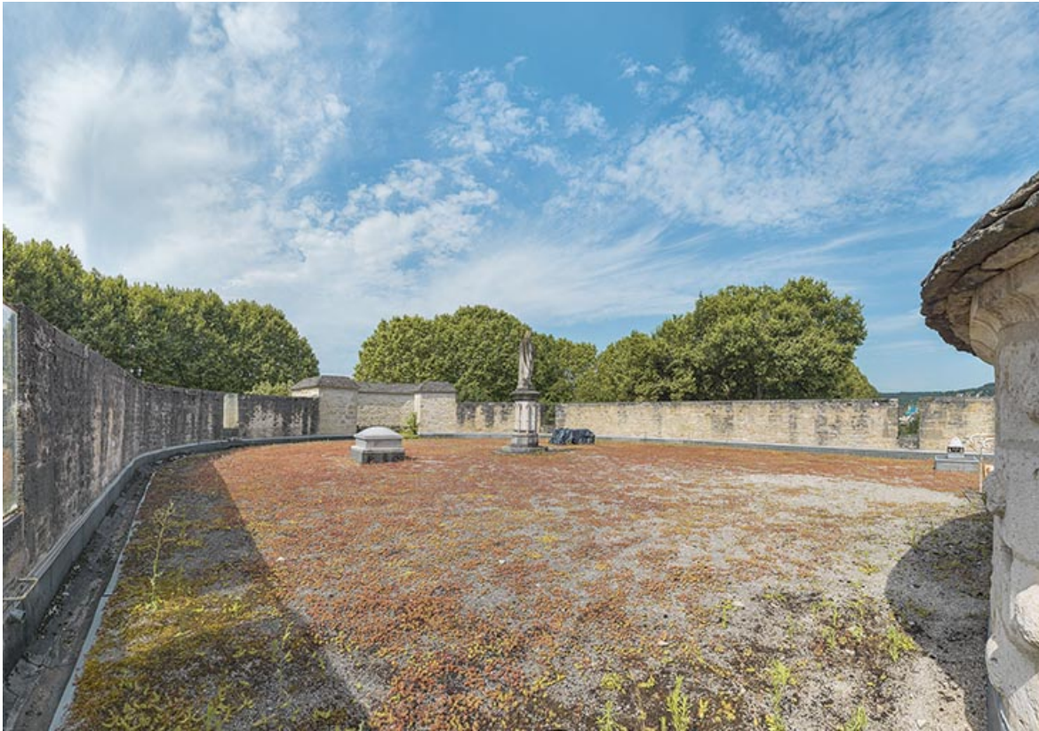
La plateforme supérieure de la tour : vue générale.
