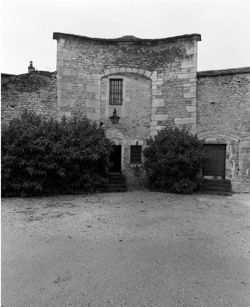
Tour des Cordeliers incluse dans la "grosse tour" (improprement appelée bastion de l'Hôtel-Dieu), depuis le rempart (1992). 21, Beaune boulevard Saint-Jacques
