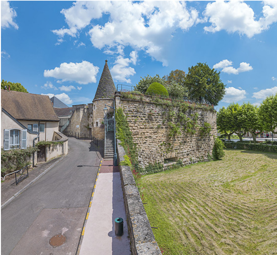
La tour, vue depuis celle des Bouchers.
