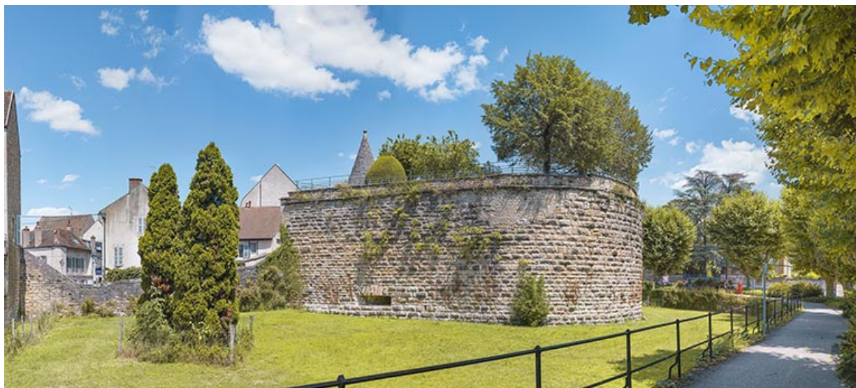
Vue générale depuis le boulevard Perpreuil.
