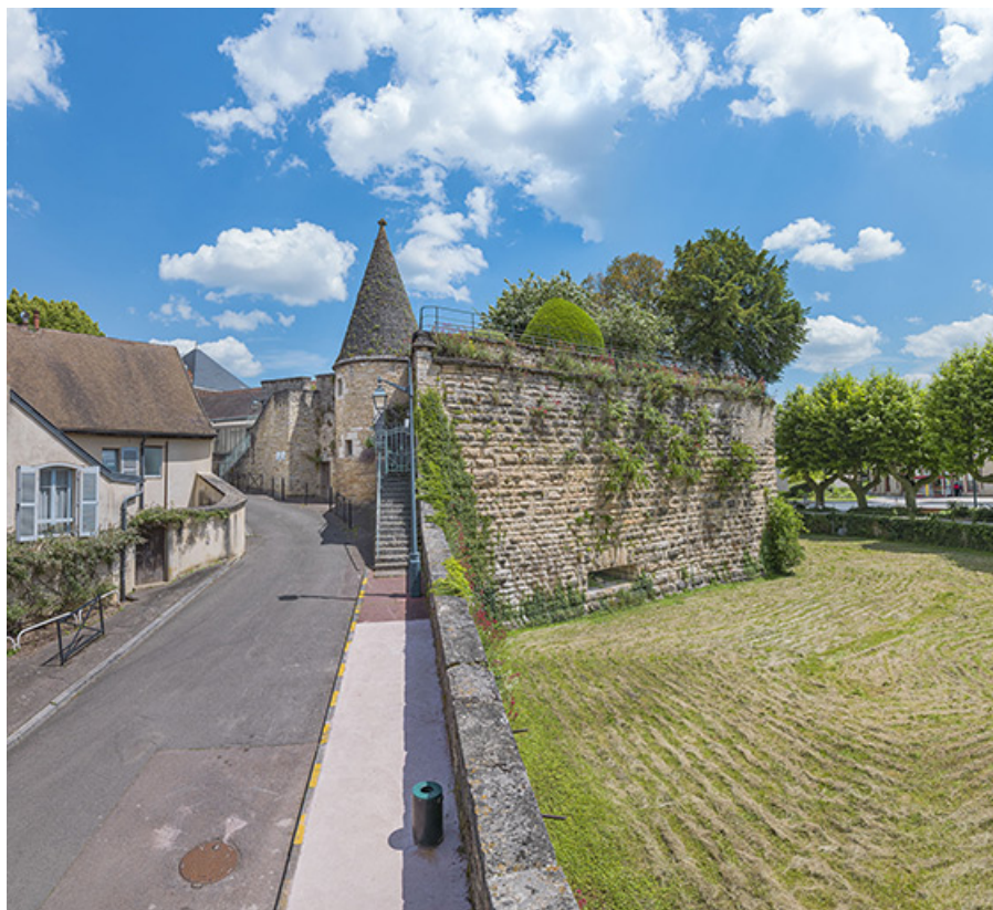
La tour, vue depuis celle des Bouchers.
