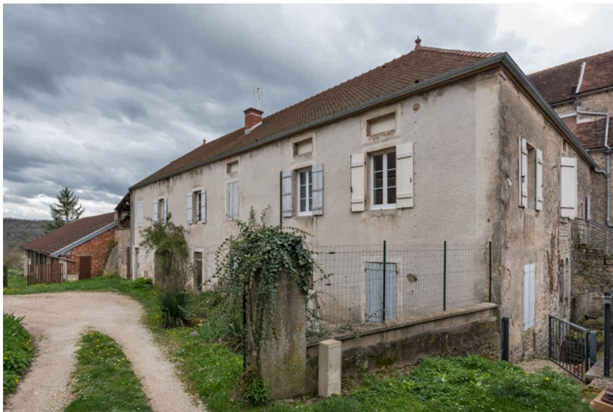
Vue d'ensemble depuis l'entrée du site, au nord. Le mur de briques du théâtre est visible à l'arrière-plan. 21, Alise-Sainte-Reine, 4 impasse du Théâtre
