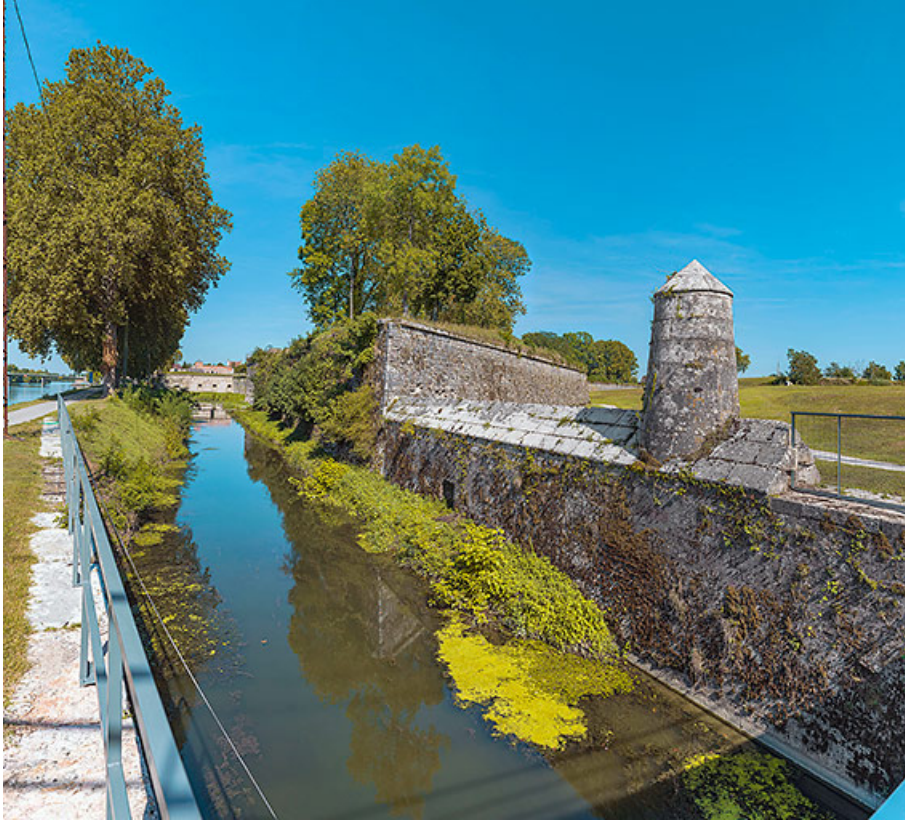
Le bastion et son batardeau.
