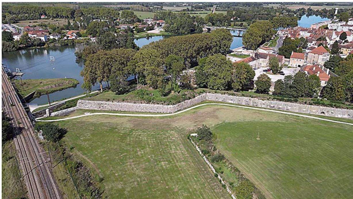
Vue aérienne du demi-bastion.
