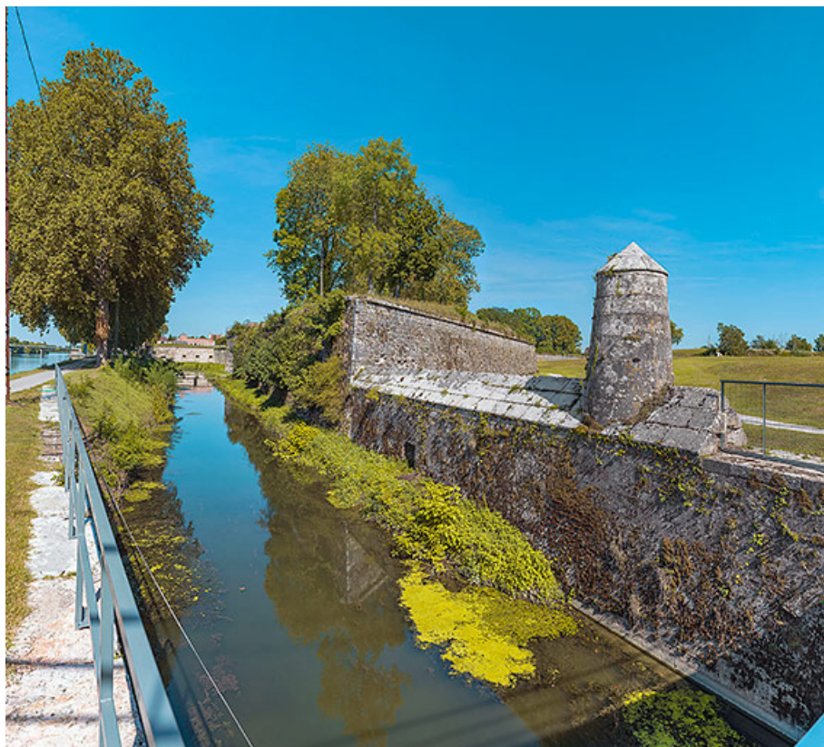
Le bastion et son batardeau.
