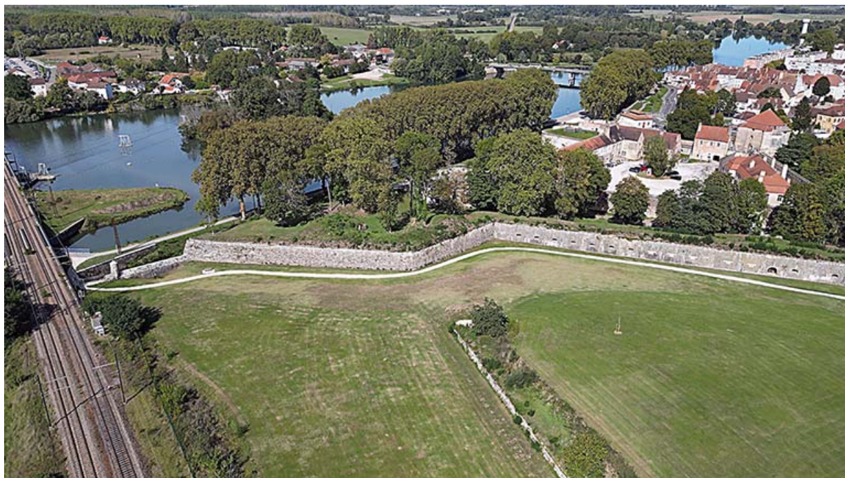
Vue aérienne du demi-bastion.
