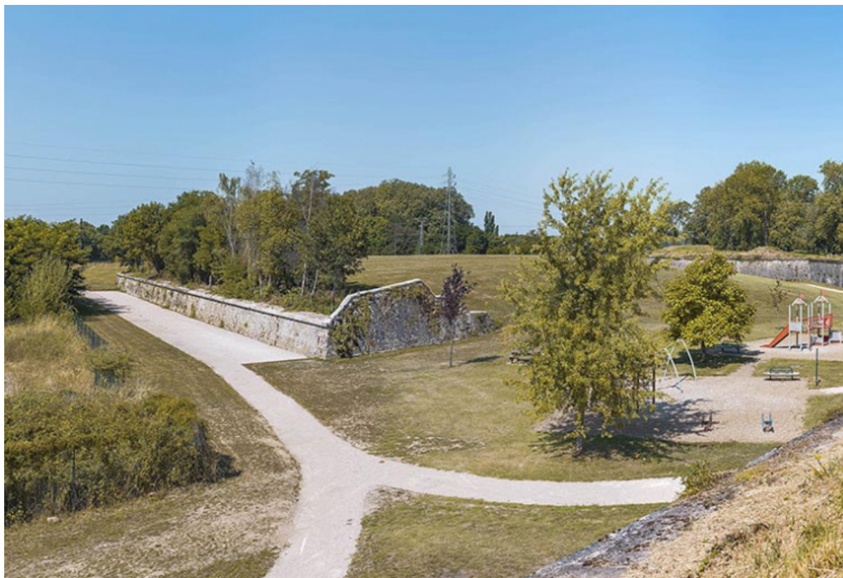
Face est de l'ouvrage.
