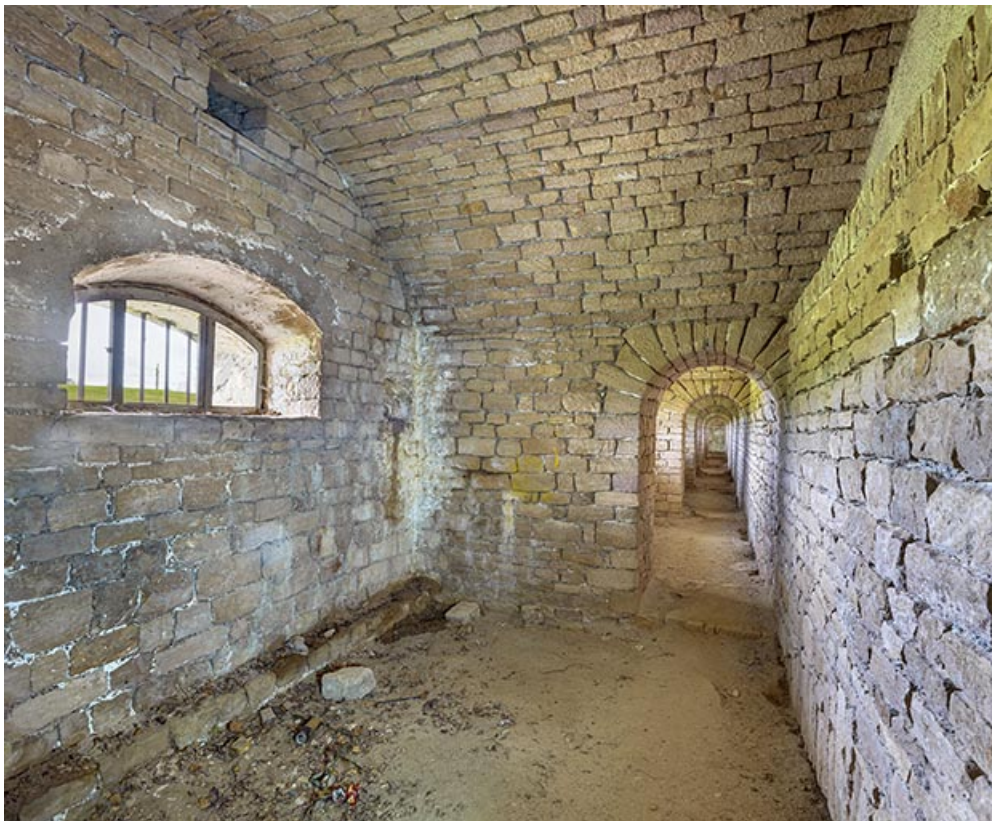
Galerie intérieure de la courtine.
