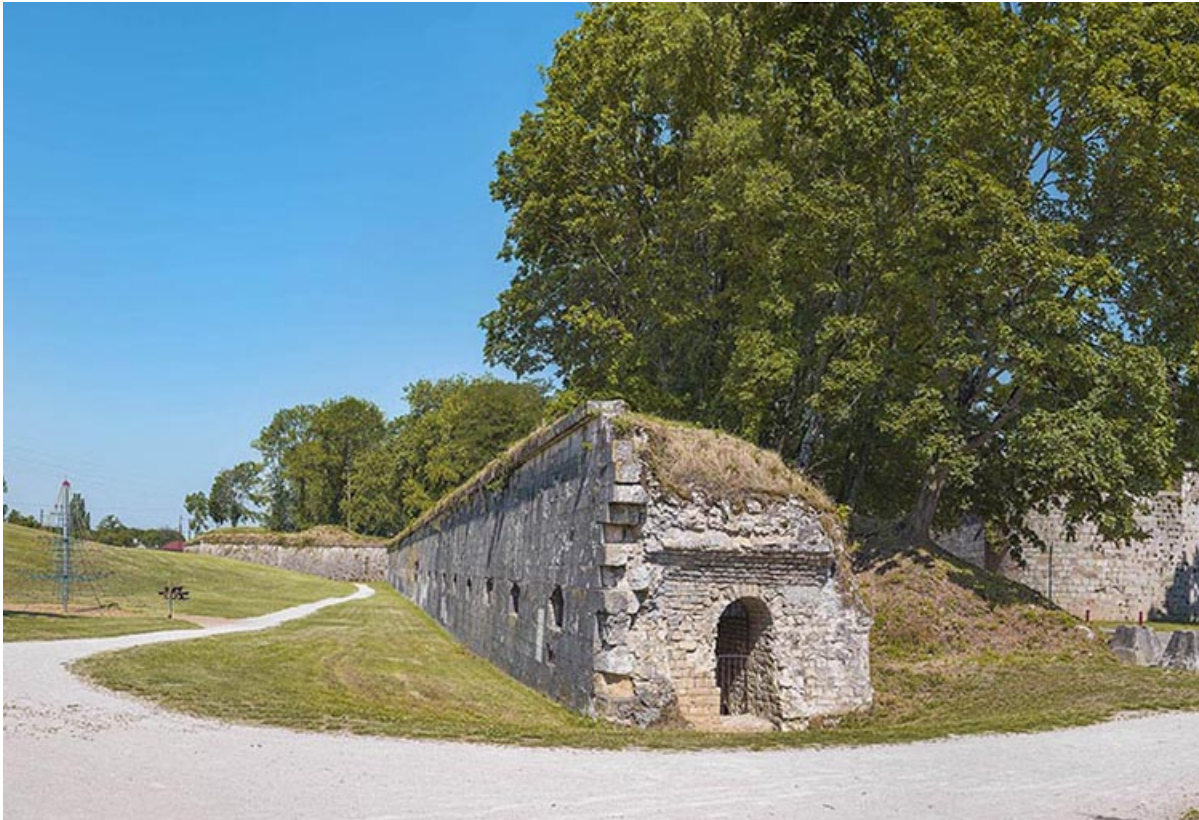
La courtine au niveau de la partie détruite au 20e siècle. 21, Auxonne rue du Château
