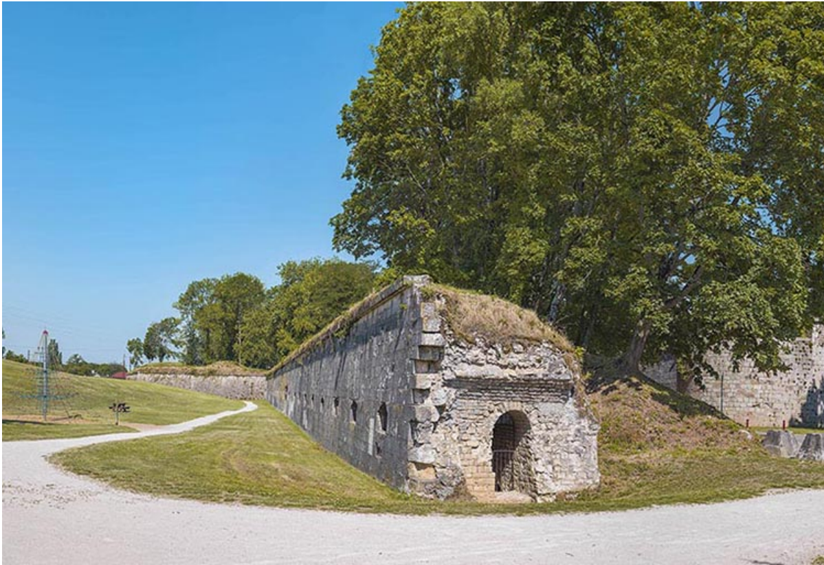
La courtine au niveau de la partie détruite au 20e siècle.
