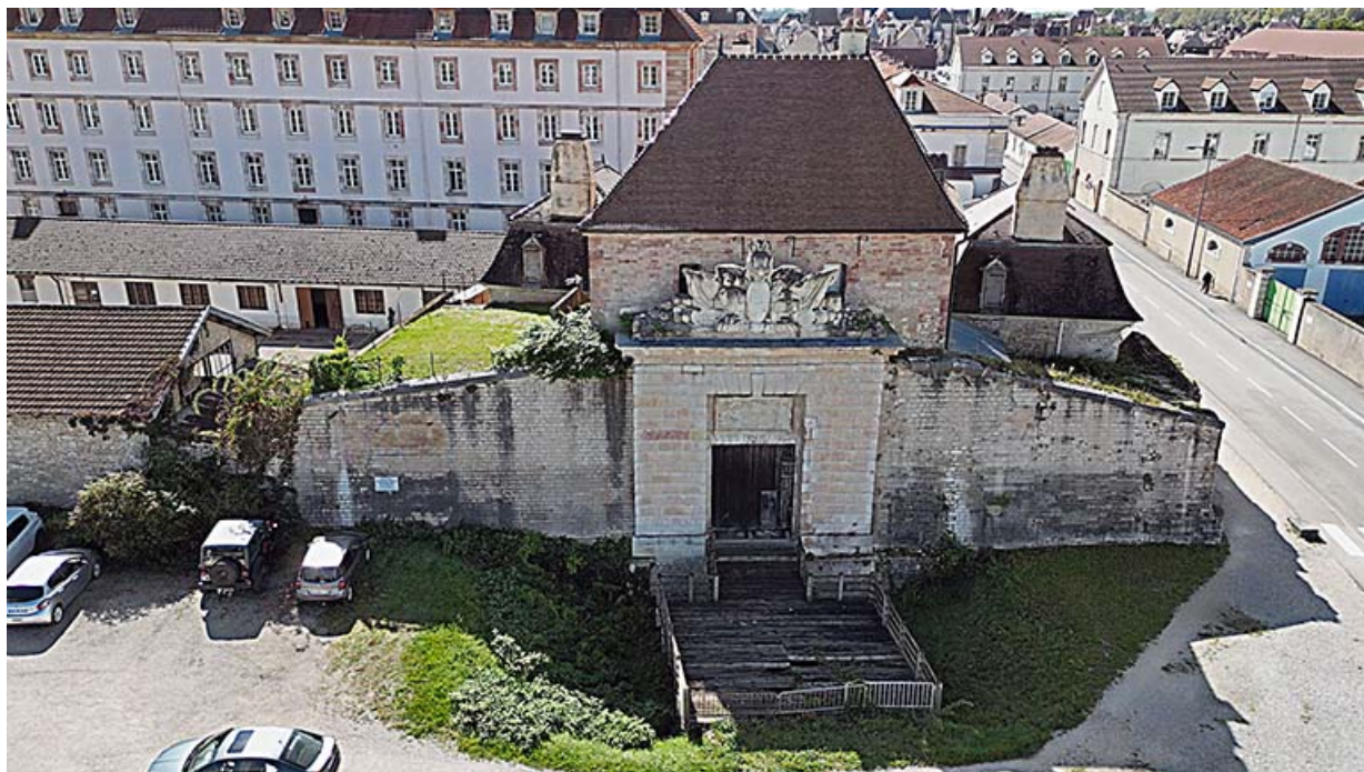
Vue aérienne de la porte.
